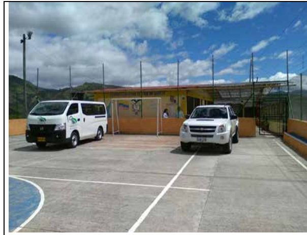
Image 5.3.38 Centro educativo Vereda Tablón de Obraje, Planar Coordinates Origin Magna Colombia E 961796,789516449 N 609503,75706119 Source (Géminis Consultores Ambientales S.A.S, 2016)
