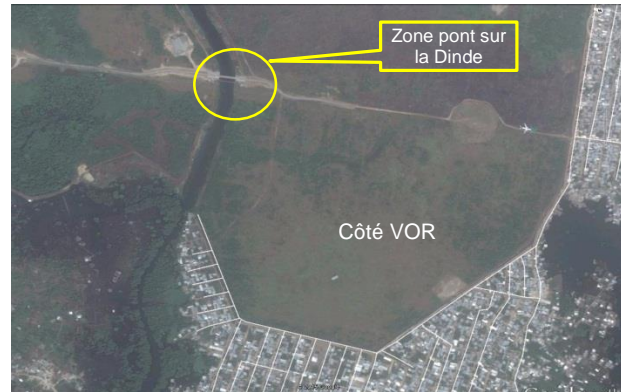
Figure 5 : Cours d'eau de la Dindé traversant le domaine de l'aéroport de Douala (source CCAA)
