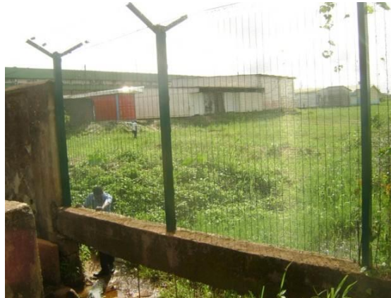
Photo 10 : Passage au niveau des ouvrages menant au FRET
