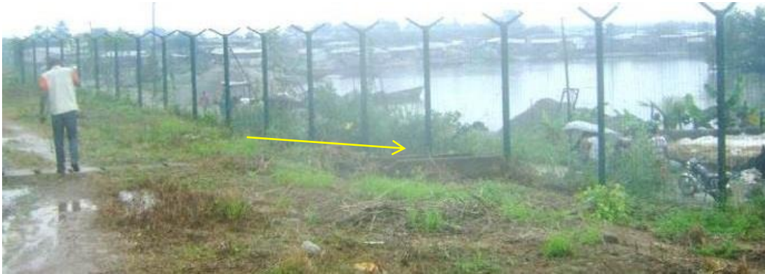
Photo 7 : Ouvrage partant de la route de patrouille et débouchant sur la voie d'accès du quartier Cité Berge
