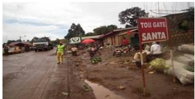
Photo 28 : Péage de Santa : encombrement des emprises
