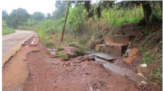
Photo 26 : Pk 3+700 arrivée d'eau sur la chaussée, facteur de dégradation accélérée de la route
