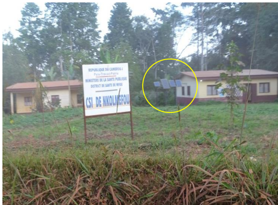
Photo 21 : Panneaux solaires pour la production d'énergie électrique au CSI de Nkolmefou :
