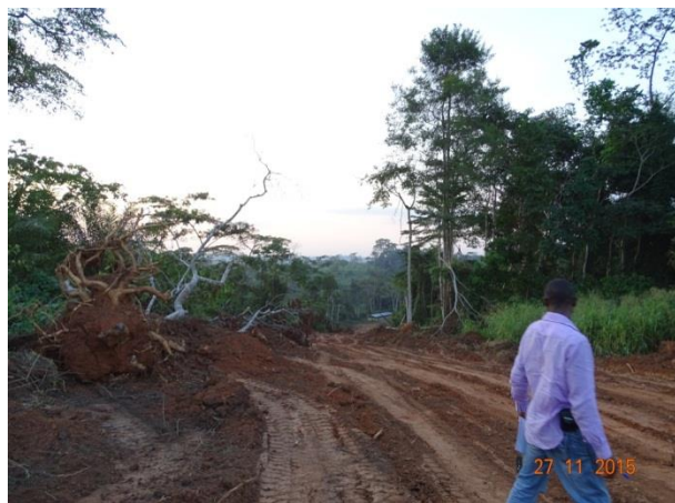
Photo 24 : Viabilisation foncière autour de la voie de contournement
