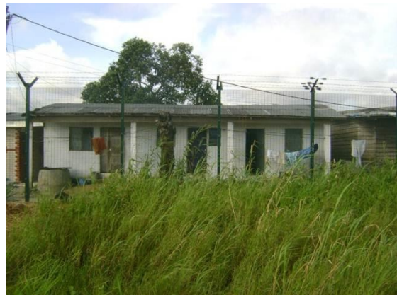
Photo 12 ; Construction riveraines très proches de la clôture
