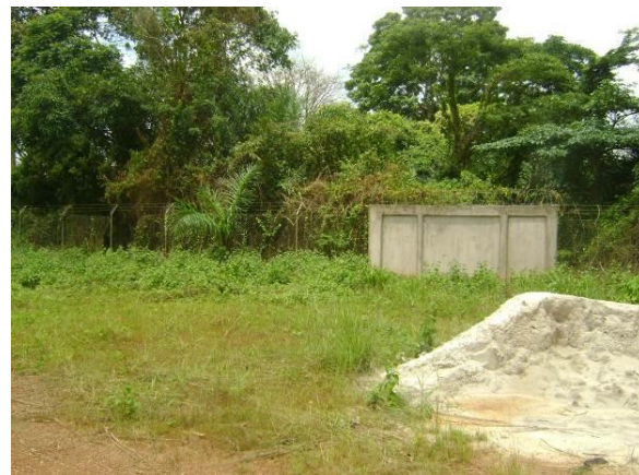
Photo 18 : Renforcement de la clôture par un muret en béton
