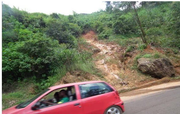
Photo 36 : Glissement de terrain à Up Station
