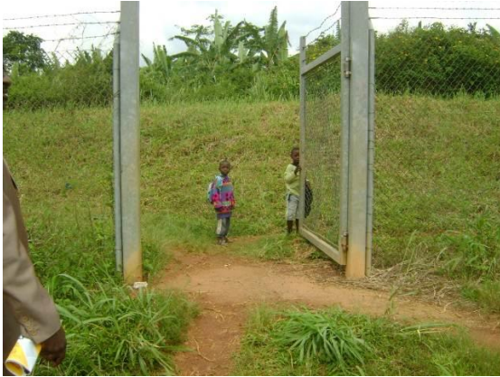
Photo 15 ; Crash gate en permanence ouvert coté VOR
