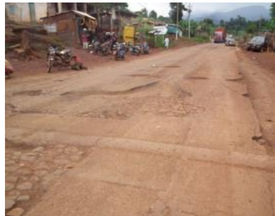
Photo 2 : Etat avancé de dégradation de la chaussée à Babadjou Pk15 + 500 (Cliché Foyet, mars 2016)
