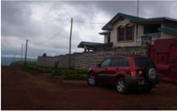
Photo 9 : Maison de haut standing à éviter (Cliché Foyet, mars 2016)
