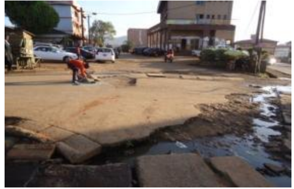
Photo 12 : Caniveaux obstrués, ruissellement d'eau sur la chaussée (Cliché Foyet, mars 2016)
