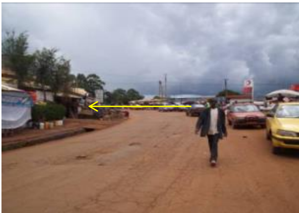
Photo 1 : Virage du carrefour Babadjou (Toumaka) à redresser (Cliché Foyet, mars 2016)
