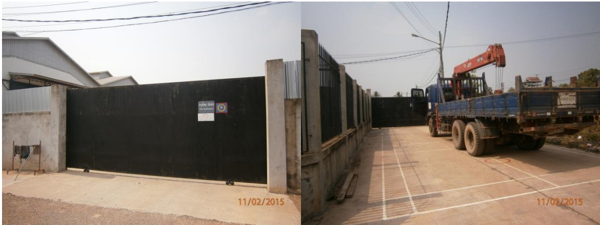
ຮູບ 3-3 ສາງເກັບ ອຸປະກອນໄຟຟ້າຂອງໄຟຟ້າລາວ ເພື່ອເກັບຮັກສາ ໝໍ້ແປງໄຟເກົ່າທີ່ມີສານ PCBs
