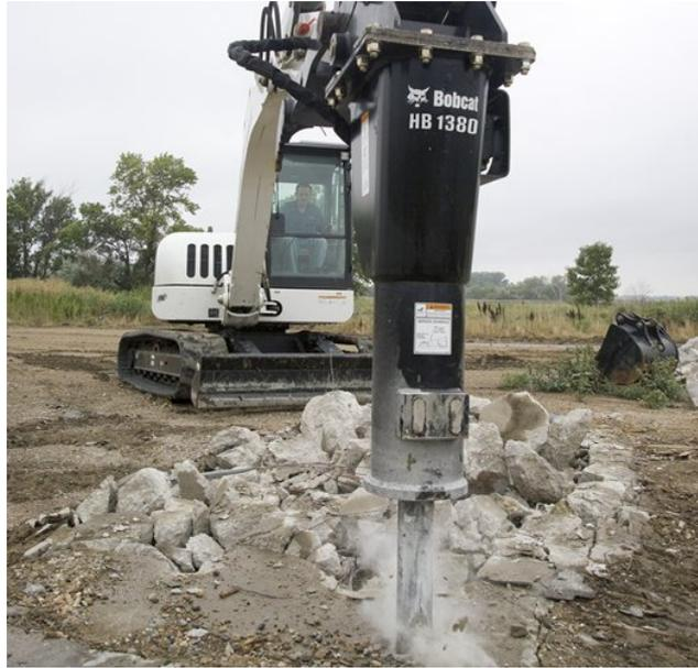
Figura 1 – Imagen de retroexcavadora con martillo hidráulico acoplado, picando una cimentación
