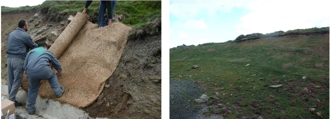
Figura 6 –Colocación de manta orgánica y misma manta orgánica, con incipiente vegetación herbácea, meses después.
