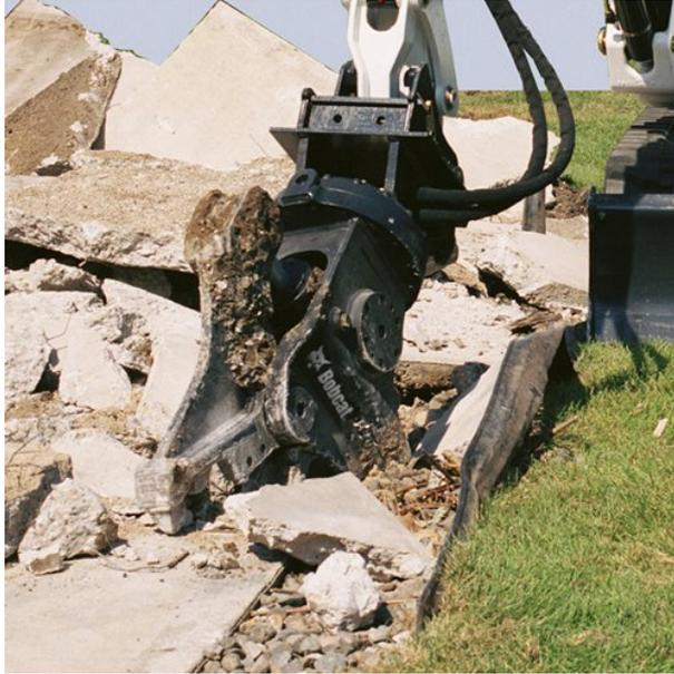
Figura 2 – Imagen de retroexcavadora con cizalla acoplada, separando la ferralla del hormigón
