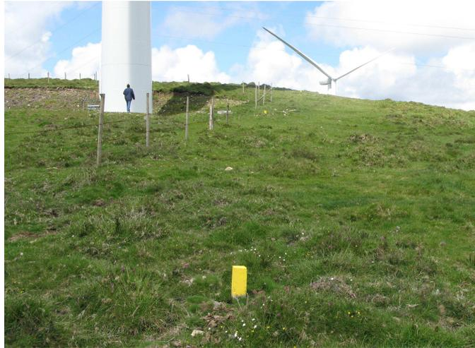
Figura 5 – Mojoneros señalizadores en zanja de cableado restaurada
