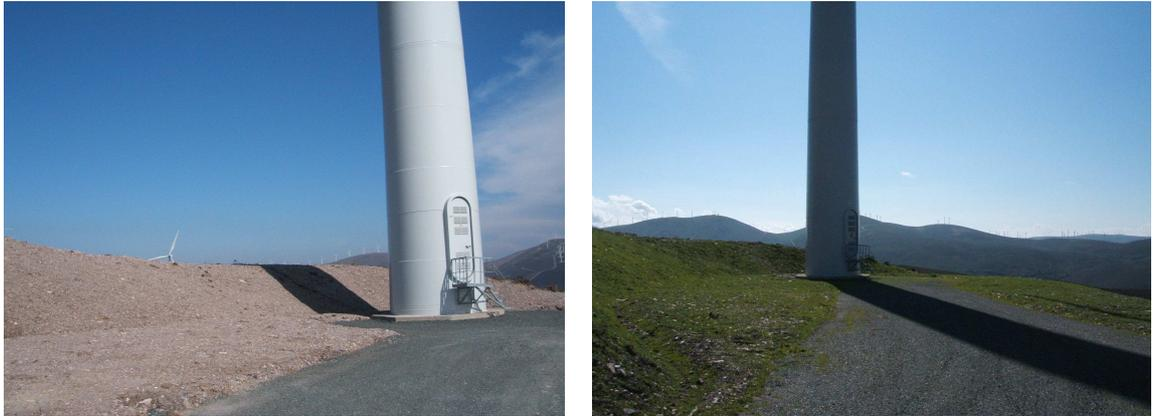
Figura 4 – Plataforma de aerogenerador antes y después de la siembra efectuada.
