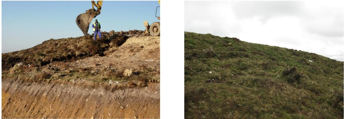
Figura 11 – Colocación de tepes en un talud de la plataforma; mismo talud (foto derecha) dos años después de su restauración
