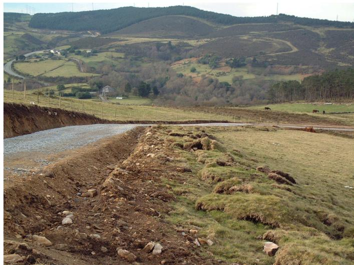
Figura 89 – Cordón de tepes depositado a un lado del ramal abierto
