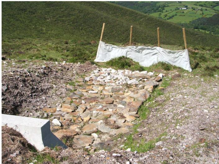
Figura 91 –Detalle de embocadura de aleta en viales, escollera de piedra y red de retención de sólidos a la salida de aguas
