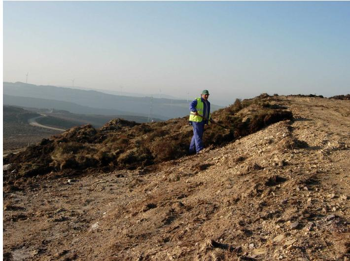
Figura 90 –Colocación de tepes previamente retirados en terraplén
