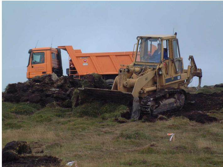
Figura 88 – Retirada de tepes en la apertura de accesos
