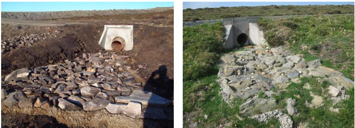
Figura 8 – A la izquierda obra de drenaje tras su construcción; a la derecha detalle del entorno de una ODT una vez restaurado.
