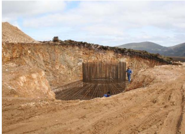
Figura 2 – Armado de cimentación de aerogenerador.
