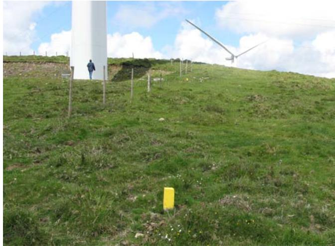
Figura 5 – Mojonos señalizadores en zanja de cableado restaurada
