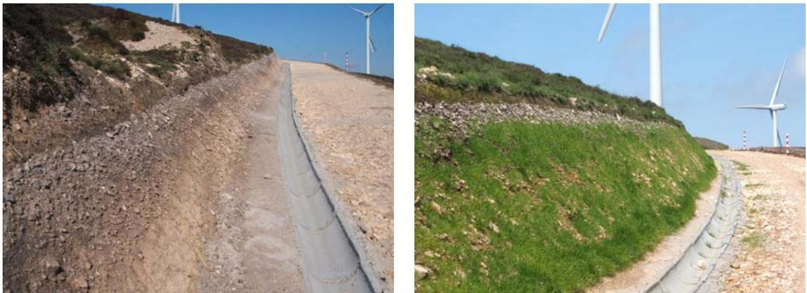
Figura 7 – Talud en vial antes y después de ser hidrosechado.
