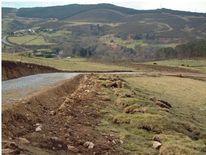
Figura 71 – Cordón de tepes depositado a un lado del ramal abierto
