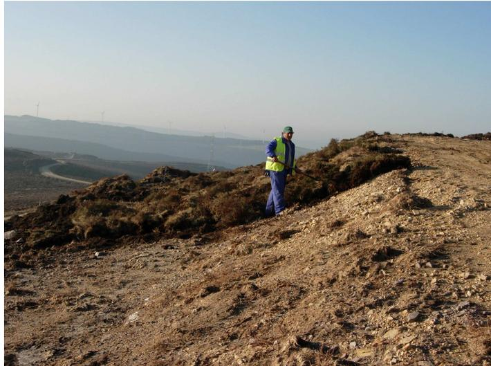
Figura 72 –Colocación de tepes previamente retirados en terraplén
