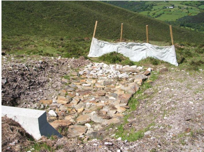
Figura 73 –Detalle de embocadura de aleta en viales, escollera de piedra y red de retención de sólidos a la salida de aguas
