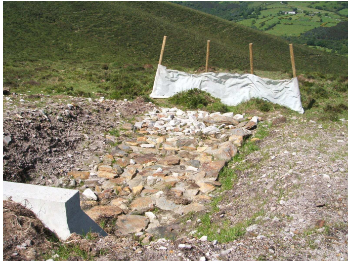
Figura 76 –Detalle de embocadura de aleta en viales, escollera de piedra y red de retención de sólidos a la salida de aguas
