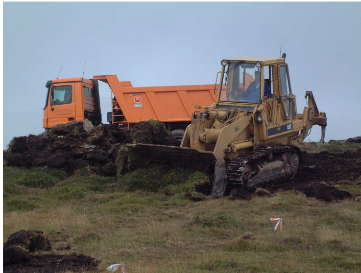
Figura 73 – Retirada de tepes en la apertura de accesos
