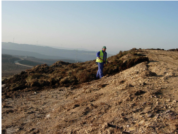
Figura 75 –Colocación de tepes previamente retirados en terraplén
