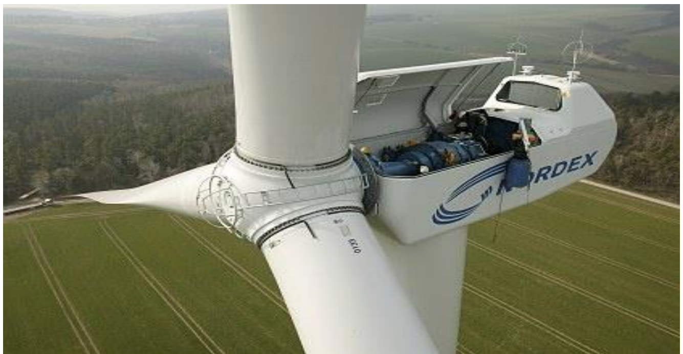
Fig. 7.4. Inspection of wind turbines «on march»
