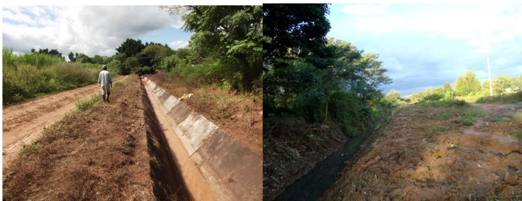
Figura N°12. Canal A. Situación actual.
