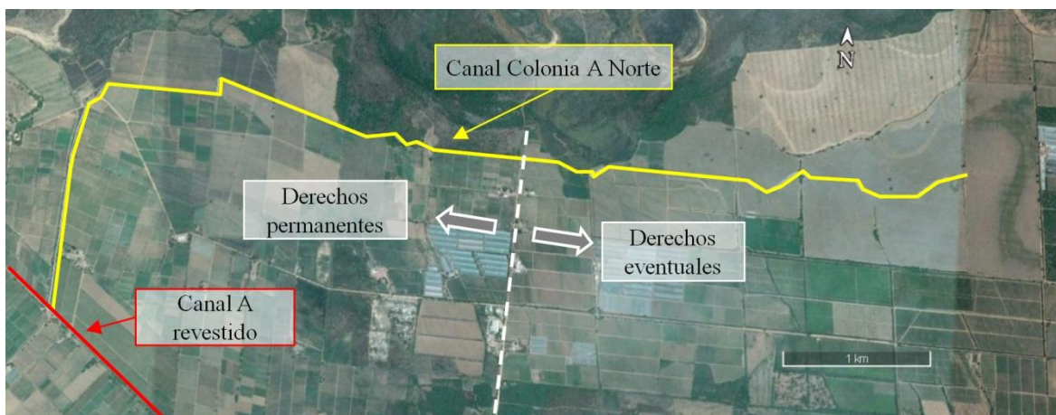
Figura N°17. Canal Colonia A unificado y tramo Norte. Zona de estudio.
