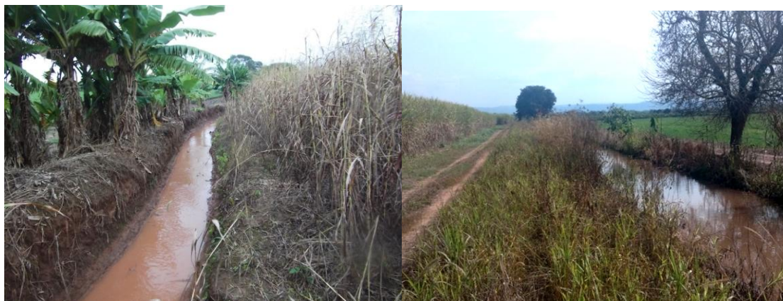
Figura N°14. Canal Colonia A Norte. Situación actual.
