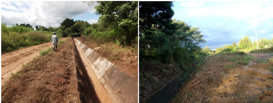
Figura N°16. Canal A. Situación actual.
