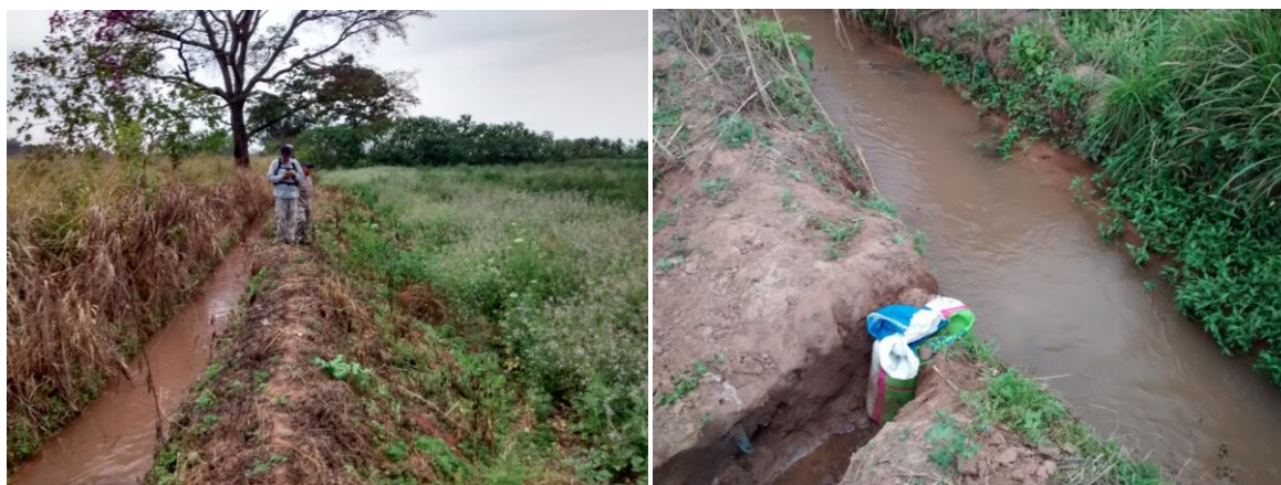
Figura N°21. Canal Colonia A Sur. Situación actual.
