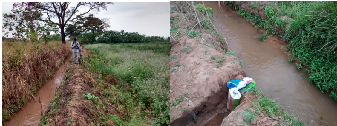
Figura N°17. Canal Colonia A Sur. Situación actual.
