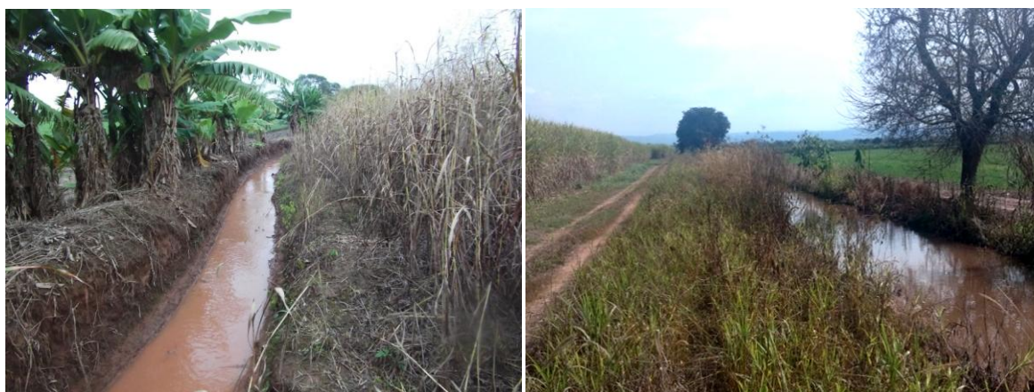
Figura N°18. Canal Colonia A Norte. Situación actual.
