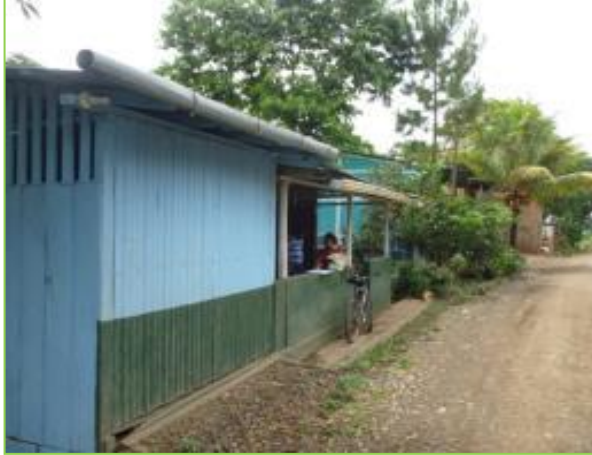
Propietario: Antonio Ochoa Zamora Estación: 0+620 Banda: I Afectación: Parcial
