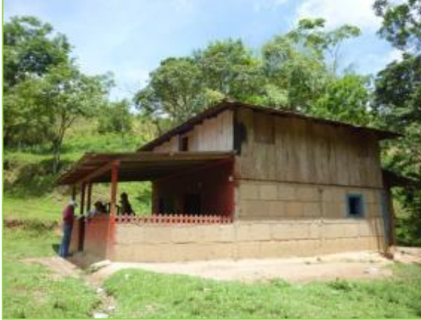
Figura 21. Propietario: José Ramón Fajardo Sobalvarro. Cód. SISCAT: R001-014-059. Estación: 8+475 Banda: D Afectación: Total
