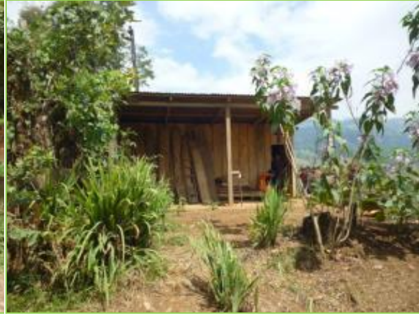
Figura 38. Propietario: Salomón Siles Martínez/ Petrona Mendoza Salgado Estación: 28+900 Banda: I Afectación: Parcial Cgo. SISCAT: 0707U002016-43
