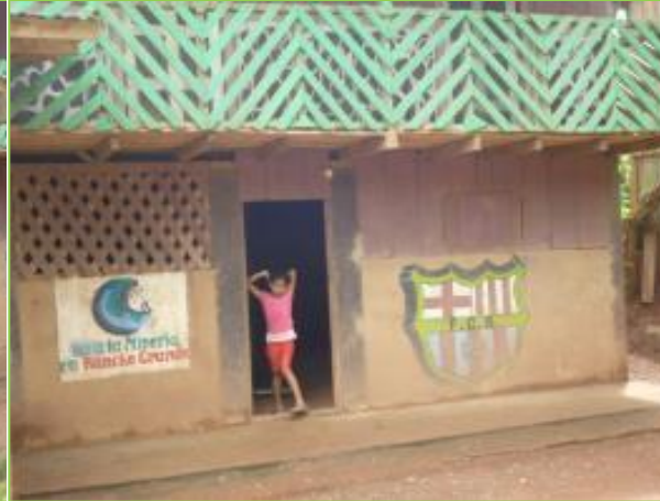
Propietario: Mariela Jarquín González Estación: 0+700 Banda: I Afectación: Parcial
