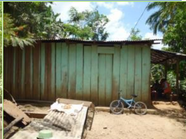
Figura 12. Propietario: Blanca Luz Pineda Urbina. Esta propiedad no está declarada. Estación: 5+220 Banda: D Afectación: Parcial
