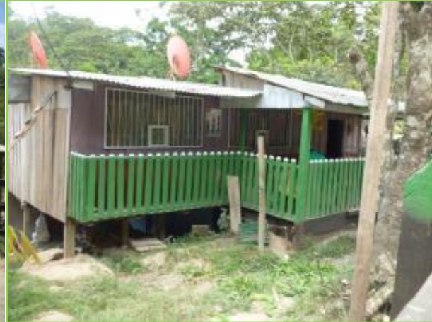
Figura 14. Propietario: Herlinton Marcos Rojas López Esta propiedad no está declarada. Estación: 6+710 Banda: I Afectación: Total
