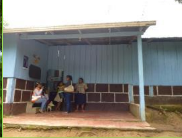
Propietario: Luz Marina García Linarte Estación: 10+820 Banda: D Afectación: Total
