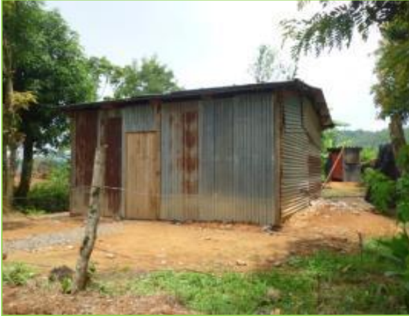
Propietario: Sunilda García Estación: 10+130 Banda: D Afectación: Total
