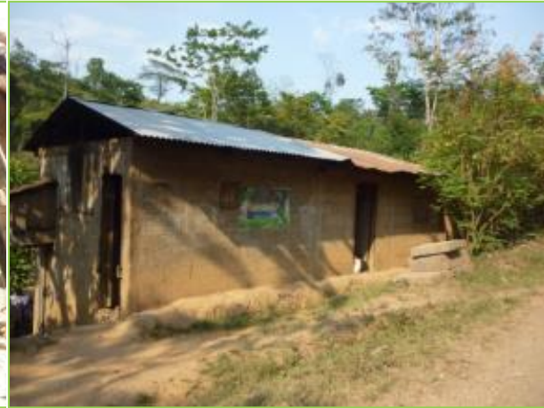
Figura 24. Propietario: Cándida Rosa Alvizua Molinares. Esta propiedad no está declarada. Estación: 13+490 Banda: I Afectación: Total
