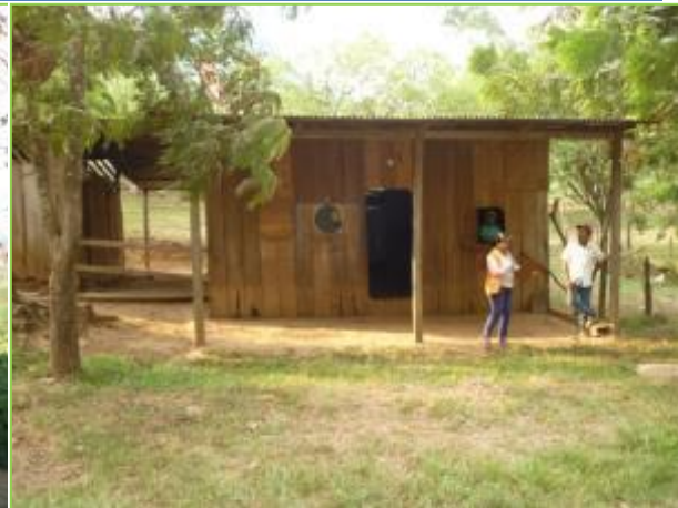
Figura 28. Propietario: Adán Roa Zeledón. Cód. SISCAT: R001-016-003. Estación: 17+300 Banda: I Afectación: Parcial
