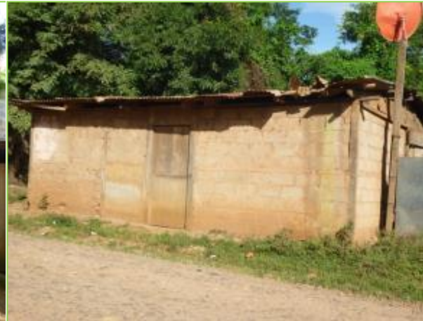
Propietario: Aneyna Vianney Moreno Blandón Estación: 24+460 Banda: D Afectación: Total Cgo. SISCAT: 0707-U001-009-63
