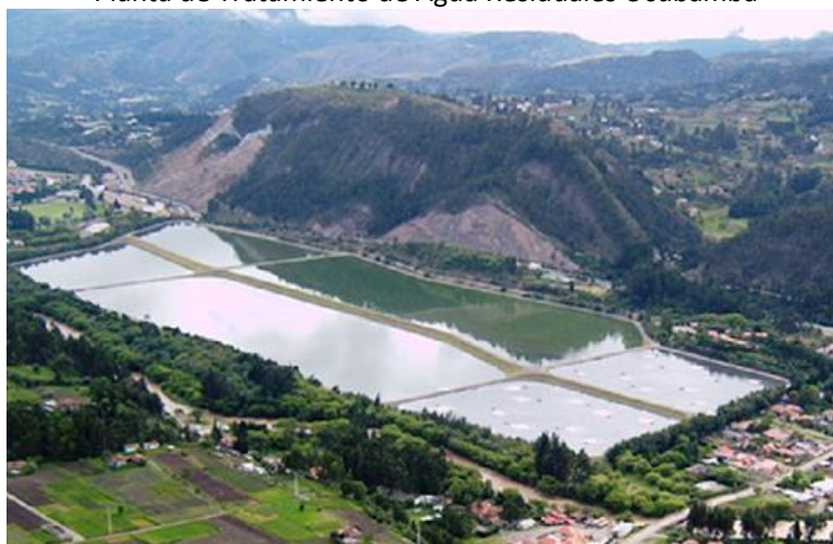
Planta de Tratamiento de Agua Residuales Ucubamba
