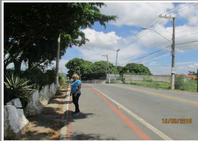
Foto 25: Vista da Rodovia Serafim Derenzi no local de implantação da UBS.
