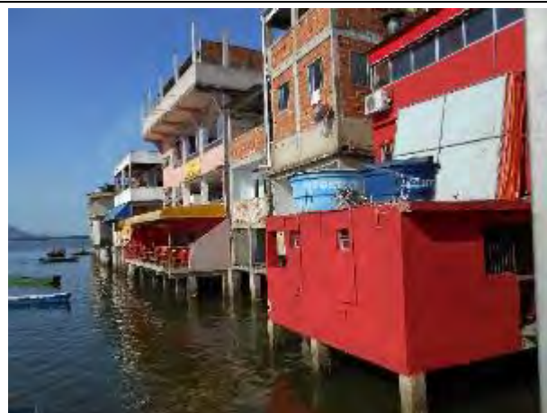
Foto 34: Estabelecimentos e residências avançando sobre o canal, onde será implantado parte do projeto Orla Noroeste.
