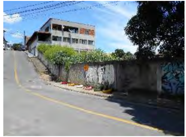
Foto 14: Vista do muro que delimita a propriedade onde será implantada o novo edifício da Unidade Básica de Saúde Santo Antônio, na Rua Agostinho de Oliveira.
