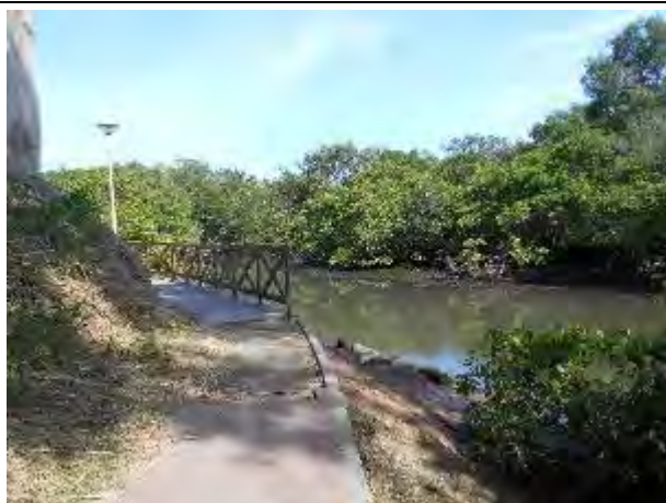
Foto 125: Passarela existente nos fundos da EMEF Neusa Nunes Gonçalves, ponto de tráfico de drogas segundo os entrevistados.
