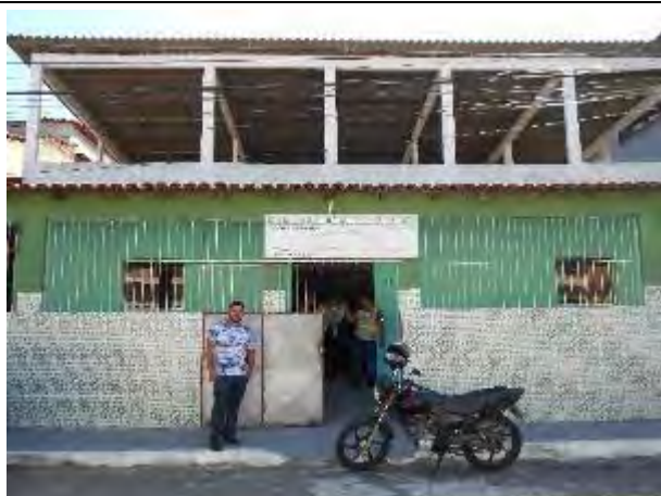
Foto 171: Prédio do Movimento Comunitário do Bairro da Resistência, situado na Rua da Luta.
