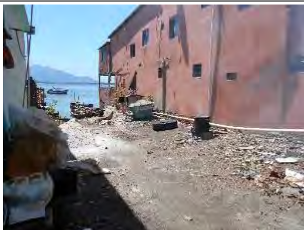
Foto 53: Caburê, atracadouro da Ilha das Caieiras, situado próximo à sede da ASPEMADE, utilizado por um outro grupo de pescadores da região.
