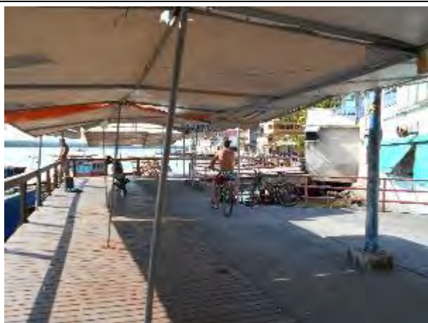
Foto 21: Cobertura instalada pelos restaurantes no deck de madeira da orla da Ilha das Caieiras para cobertura das mesas e uso dos clientes. Uma das reclamações dos moradores sobre o uso do local.
