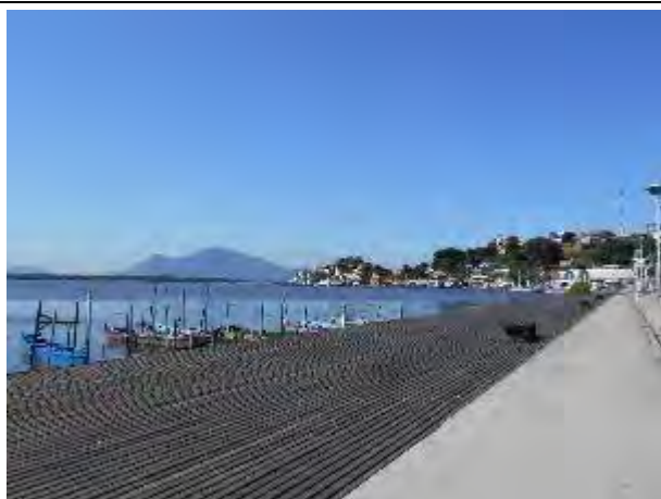
Foto 09: Deck de madeira instalado na orla do bairro São Pedro. Destaque para as canoas de pescadores atracadas.
