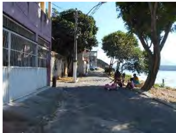
Foto 02: Morádias e via situadas na orla atual do bairro São Pedro, onde o projeto pretende ser implantado.
