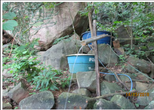
Foto 01: Sistema de Captação – Nascente da Capixaba
