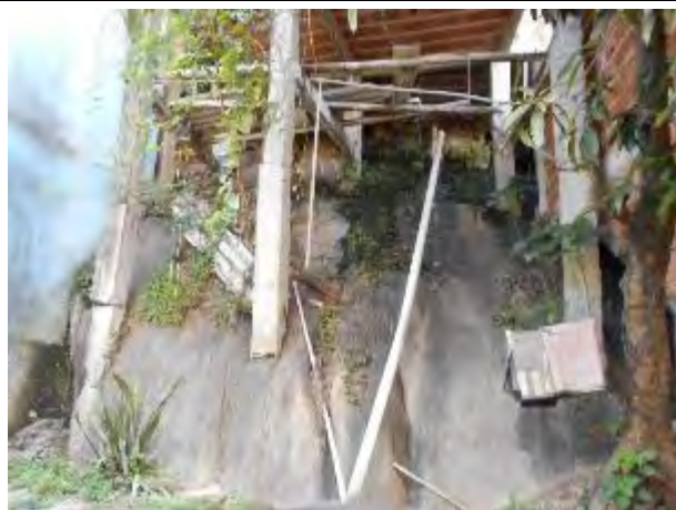
Foto 145: Residência próxima ao Cajún, onde o bairro da Nova Palestina se encerra devido a formação geológica do local. Nota-se lançamento irregular de efluentes.
