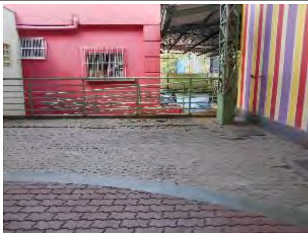
Foto 139: Piso cedendo devido, um dos problemas de infraestrutura enfrentados pela unidade.
