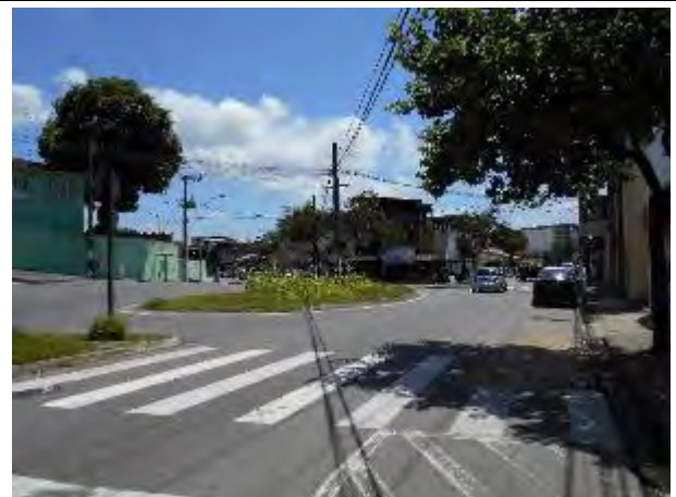
Foto 10: Rua Ernesto Bassini, onde se encontra a UBS Santo Antônio, e também onde ficará a nova edificação da unidade.
