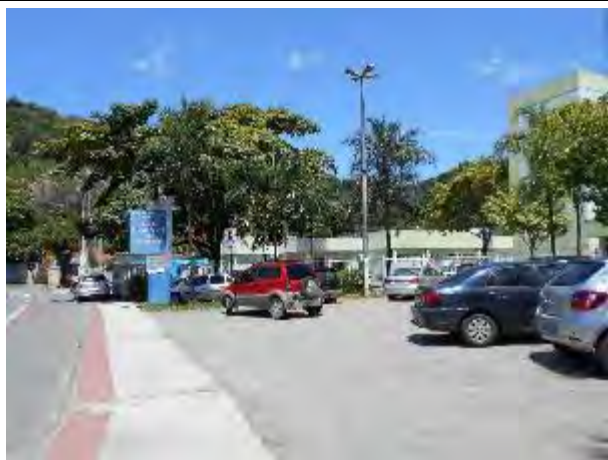
Foto 01: Frente do Pronto Atendimento São Pedro, também conhecido como Policlínica, situado na Rodovia Serafim Derenzi, onde está prevista reforma e ampliação.
