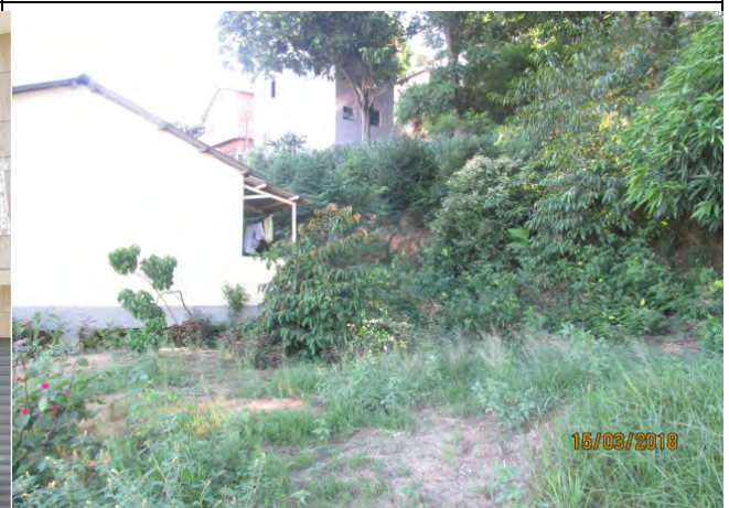
Foto 22: Talude susceptível à movimento de massa no Morro Forte São João.
