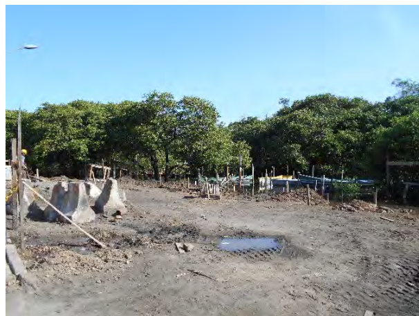
Foto 04: Reforma em andamento no entorno da Associação de Panelleiras de Goiabeiras, para ampliação do galpão onde as panelleiras trabalham.
