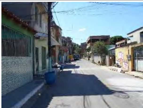
Foto 169: Rua da Luta, uma das principais vias do bairro da Resistência, onde se localiza o prédio do Movimento Comunitário do Bairro Resistência.
