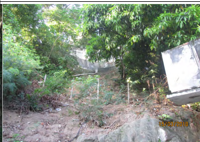
Foto 18: Estruturas de Contenção no Morro Santos Dumont.
