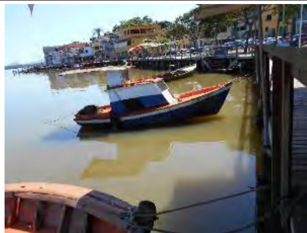
Foto 26: Canoas atracadas ao deck de madeira instalado na orla da Ilha das Caieiras, segundo os entrevistados a prefeitura não recomenda essa forma de atracação pois a estrutura não é adequada. Ponto de atenção sobre os decks e atracadouros.
