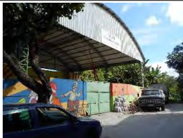
Foto 136: Unidade do Cajún – Nova Palestina (Projeto Caminhando Juntos), onde foram observados diversos problemas de infraestrutura devido à localização muito próxima ao mangue.
