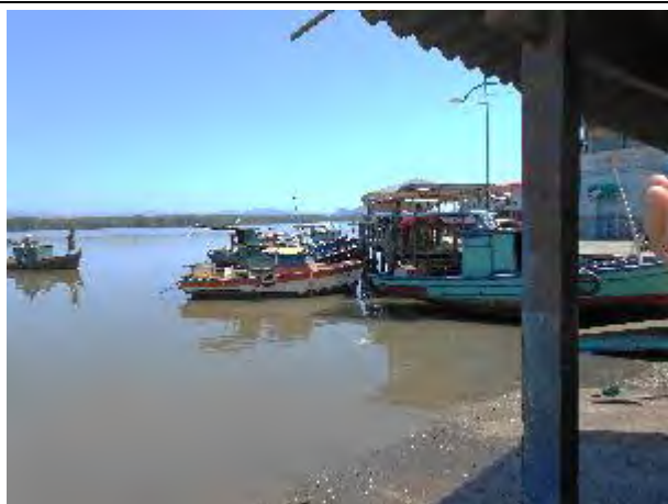
Foto 27: Canoas atracadas ao deck de madeira instalado na orla da Ilha das Caieiras, segundo os entrevistados a prefeitura não recomenda essa forma de atracação pois a estrutura não é adequada. Ponto de atenção sobre os decks e atracadouros.
