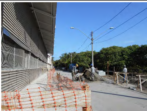
Foto 05: Reforma em andamento no entorno da Associação de Panelleiras de Goiabeiras, para ampliação do galpão onde as panelleiras trabalham.
