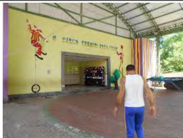
Foto 138: Unidade do Cajún – Nova Palestina (Projeto Caminhando Juntos), onde foram observados diversos problemas de infraestrutura devido à localização muito próxima ao mangue.
