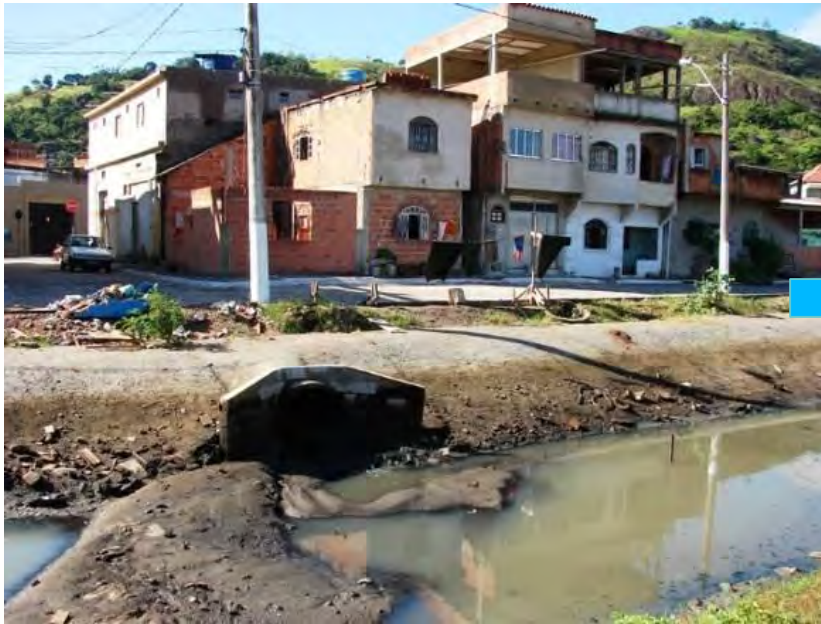
Lançamento de esgoto na rede pluvial
