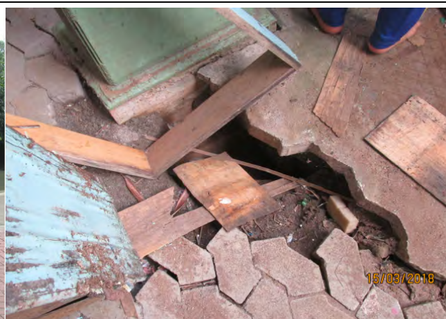
Foto 12: Detalhe de Recalque no entorno da Fundação do Cajum – Bairro Nova Palestina.
