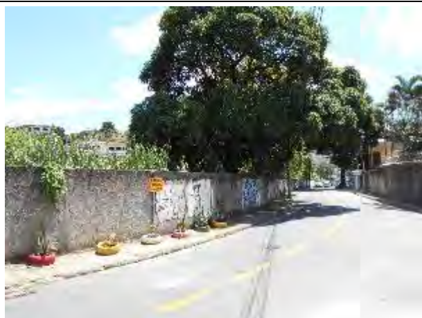
Foto 15: Vista do muro que delimita a propriedade onde será implantada o novo edifício da Unidade Básica de Saúde Santo Antônio, na Rua Agostinho de Oliveira.
