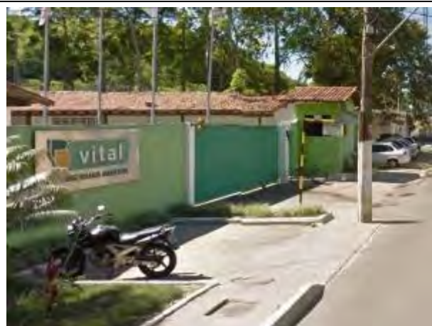
Foto 178: Vital Engenharia Ambiental, uma das empresas que prestam serviço de saneamento para a Prefeitura Municipal de Vitória, situada na Rua São Sebastião, bairro da Resistência.
