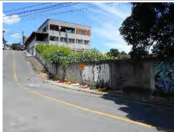
Foto 14: Vista do muro que delimita a propriedade onde será implantada o novo edifício da Unidade Básica de Saúde Santo Antônio, na Rua Agostinho de Oliveira.
