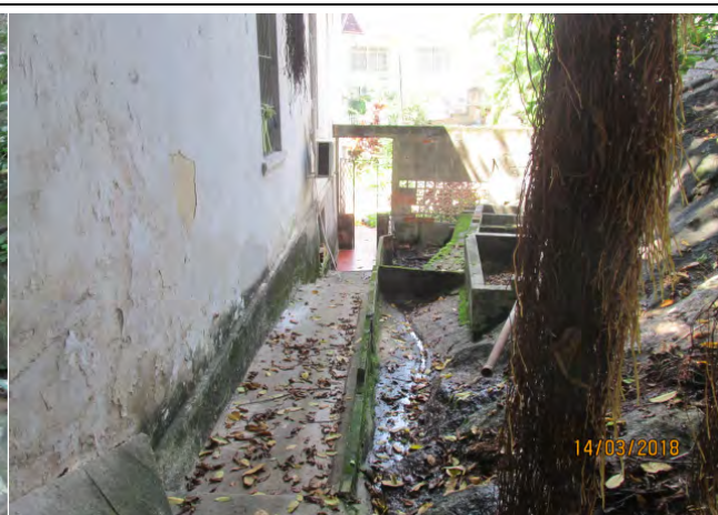
Foto 02: Nascente em residência nas proximidades do Parque Moscoso
