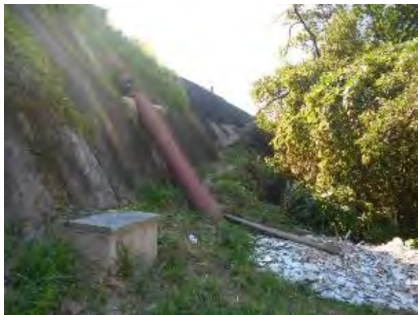
Foto 163: Tubulação e resíduos presentes no final da Rua José Romão de Melo, via que dá continuidade à Rua Beatriz Francisco Batista, onde o bairro da Resistência faz limite com o bairro da Nova Palestina por meio de uma formação geológica.
