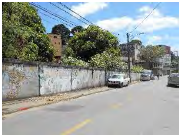
Foto 13: Rua Ernesto Bassini, uma das vias que margeiam o terreno onde será implantada o novo edifício da Unidade Básica de Saúde Santo Antônio.
