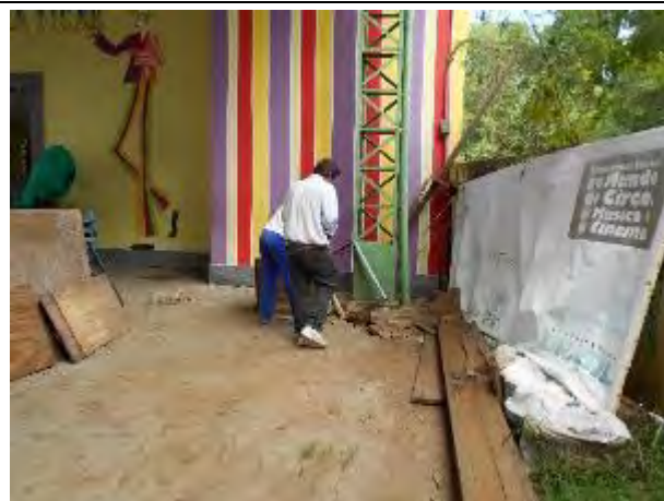
Foto 144: Problemas de umidade e estabilidade do muro e do piso no Cajún – Unidade Nova Palestina.
