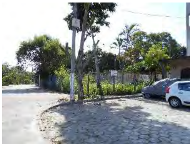
Foto 115: Estação de Tratamento de Esgoto desativada da CESAN, situada no final da Rua do Manguezal próxima a escola EMEF Neusa Nunes Gonçalves.
