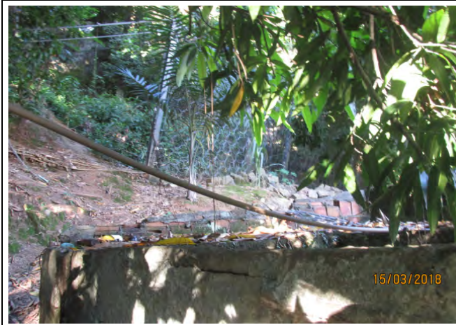
Foto 19: Detalhe de estruturas Geobrug no Morro Santos Dumont.
