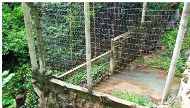
Foto 24: Detalhe de nascente existente em residência localizada no bairro Fradinhos, em Vitória, onde a água não é aproveitada.
