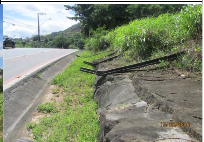
Foto 24: Afloramento de granito junto à Rodovia Serafim Derenzi.
