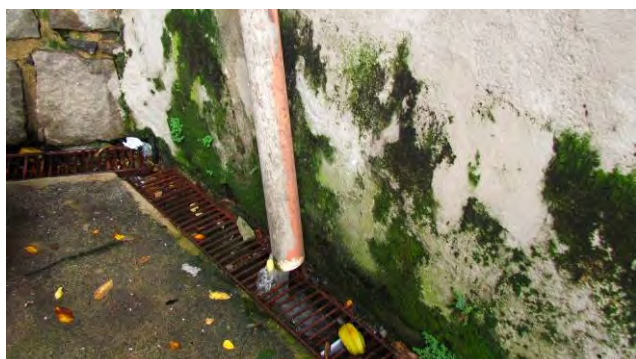
Foto 27: Detalhe de nascente existente em residência localizada no bairro Santa Clara, em Vitória, onde a água não é aproveitada.
