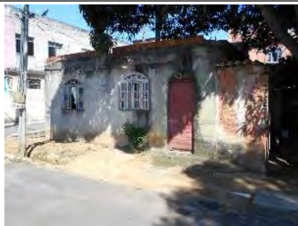
Foto 06: Residência de baixa renda situada no bairro São Pedro, próximo ao ponto inicial do projeto Orla Noroeste.
