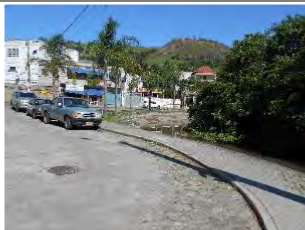
Foto 106: Início da Rua do Manguezal, que segue pela orla do Bairro da Redenção sentido Bairro da Nova Palestina, onde está sendo proposto o novo acesso ao Parque Natural Municipal Dom Luiz Gonzaga.
