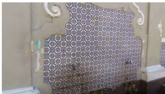
Foto 22: Detalhe do Chafariz da Capixaba, localizado na Rua Barão de Monjardim, em Vitória, cuja construção é de 1828.
