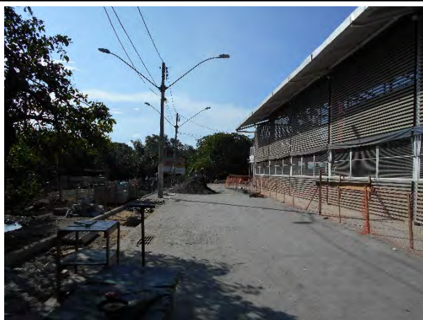
Foto 03: Reforma em andamento no entorno da Associação de Panelleiras de Goiabeiras, para ampliação do galpão onde as panelleiras trabalham.
