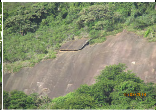
Foto 20: Desplacamento em Maciço de Granito no Morro Inhanguetá.
