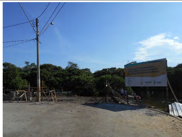
Foto 02: Reforma em andamento no entorno da Associação de Panelleiras de Goiabeiras, para ampliação do galpão onde as panelleiras trabalham.
