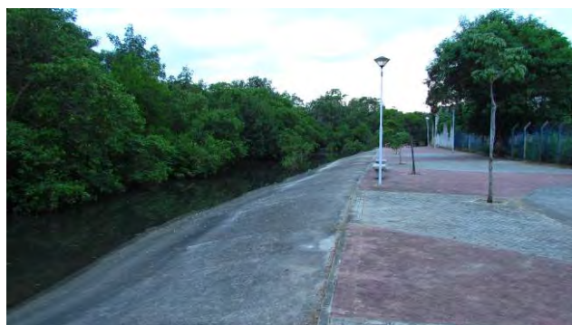
Foto 10: Detalhe de canal e manguezal no bairro Nova Palestina, em Vitória.
