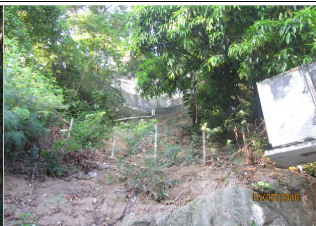
Foto 18: Estruturas de Contenção no Morro Santos Dumont.
