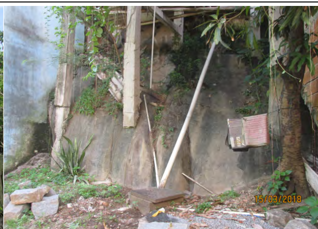
Foto 08: Maciço Residual de Granito com fundação de ocupação irregular no Bairro Nova Palestina.
