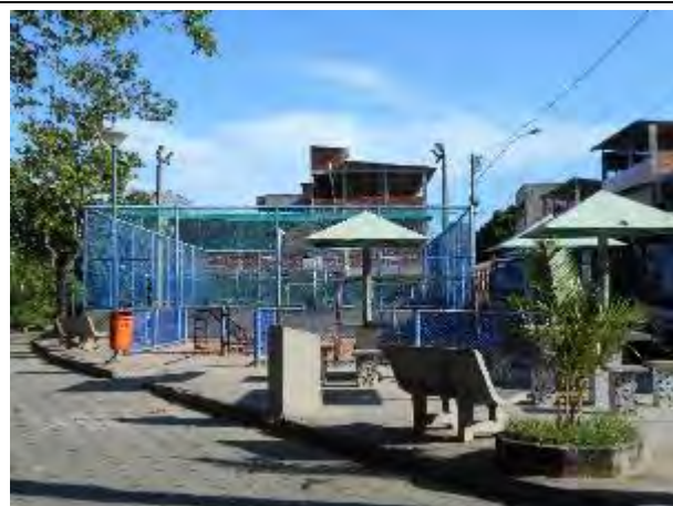
Foto 172: Estruturas de lazer situadas no bairro da Resistência situadas na Rua José Romão Melo.
