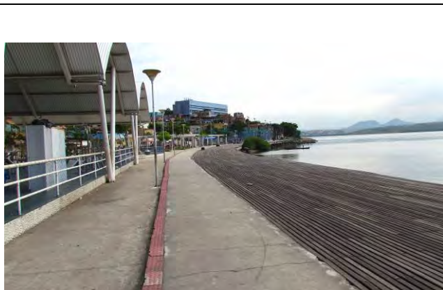
Foto 01: Vista parcial da Orla Noroeste de Vitória, com estruturas em parte já consolidadas, como o passeio público.
