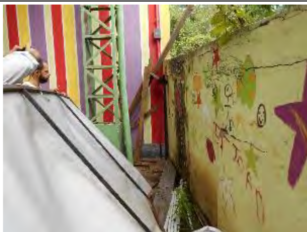
Foto 143: Problemas de umidade e estabilidade do muro e do piso no Cajún – Unidade Nova Palestina.
