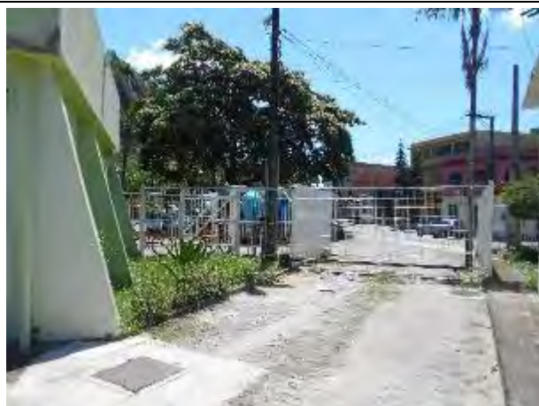
Foto 05: Portão de saída da ambulância que atende o Pronto Atendimento São Pedro, com acesso pela Rodovia Serafim Derenzi no bairro São José. Foto tirada de dentro do PA.
