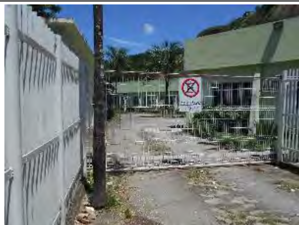
Foto 06: Portão de saída da ambulância que atende o Pronto Atendimento São Pedro, com acesso pela Rodovia Serafim Derenzi no bairro São José. Foto tirada de fora do PA.
