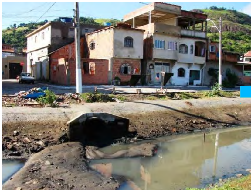
Lançamento de esgoto na rede pluvial
