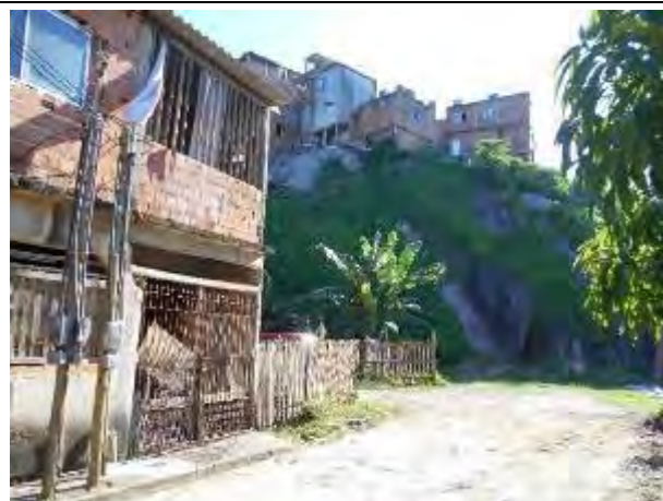
Foto 162: Final da Rua José Romão de Melo, via que dá continuidade à Rua Beatriz Francisco Batista, onde o bairro da Resistência faz limite com o bairro da Nova Palestina por meio de uma formação geológica.
