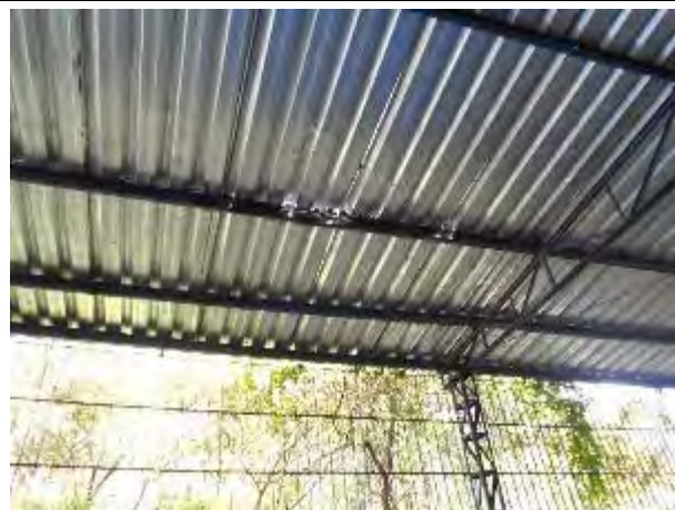
Foto 140: Cobertura da área de lazer enferrujada, um dos problemas de infraestrutura enfrentados pela unidade.
