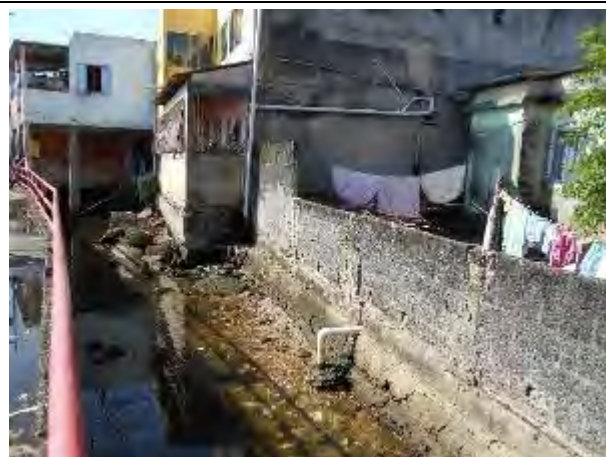
Foto 28: Lançamento irregular de efluentes realizado diretamente no canal de Santa Maria, na orla da Ilha das Caieiras, por moradia.
