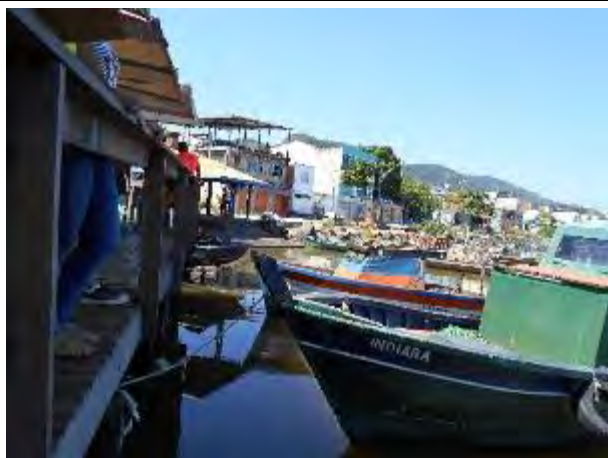
Foto 25: Canoas atracadas ao deck de madeira instalado na orla da Ilha das Caieiras, segundo os entrevistados a prefeitura não recomenda essa forma de atracação pois a estrutura não é adequada. Ponto de atenção sobre os decks e atracadouros.
