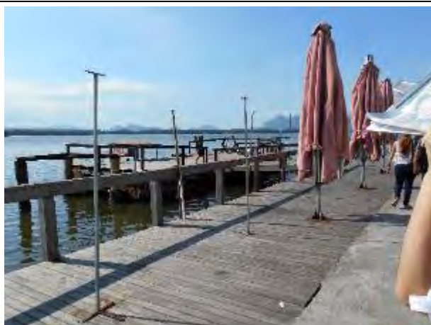
Foto 23: Estruturas implantadas pelos restaurantes fazer uso para seus clientes. Reclamação dos moradores sobre esta situação.
