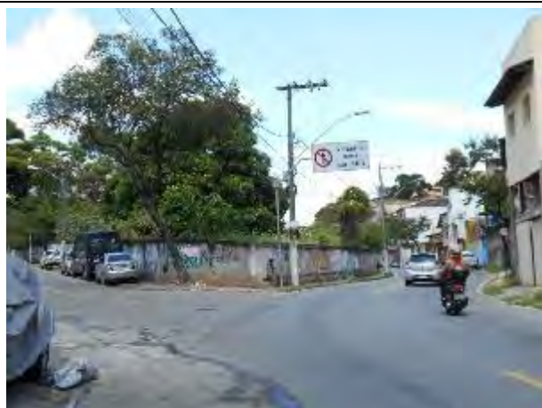
Foto 11: Vista de frente do terreno onde será construída o novo edifício da Unidade Básica de Saúde Santo Antônio. À direita a Rua Ernesto Bassini e à esquerda a Rua Agostinho de Oliveira.
