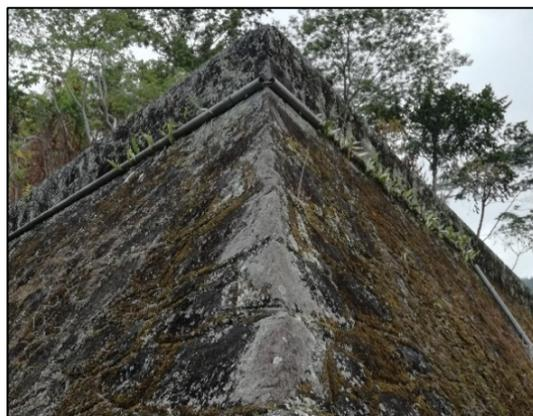
Foto 4.68 - Estrutura de alvenaria da câmara de carga
