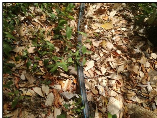
**Foto 4.18 - Tubo em PVC para adução de água a Ponta Figo a partir de nascente**
