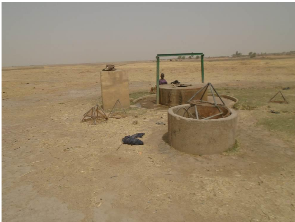
Vue d'un puits à grand diamètre sur l'emprise du projet.
