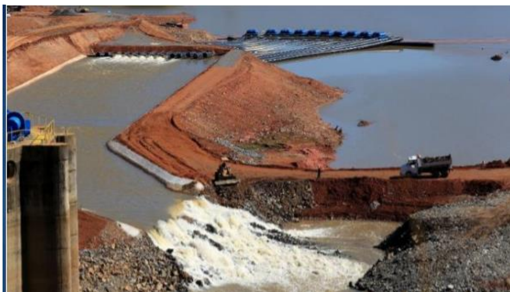
Captação da Reserva Técnica do Sistema Cantareira
