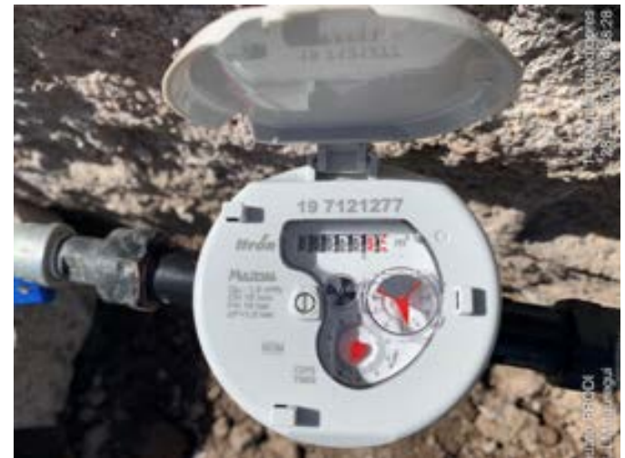
Visita instalación de micromedidores, colonia 12 de diciembre, Irapuato
