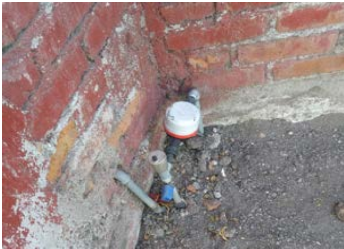
Visita instalación de micromedidores, colonia 12 de diciembre, Irapuato
