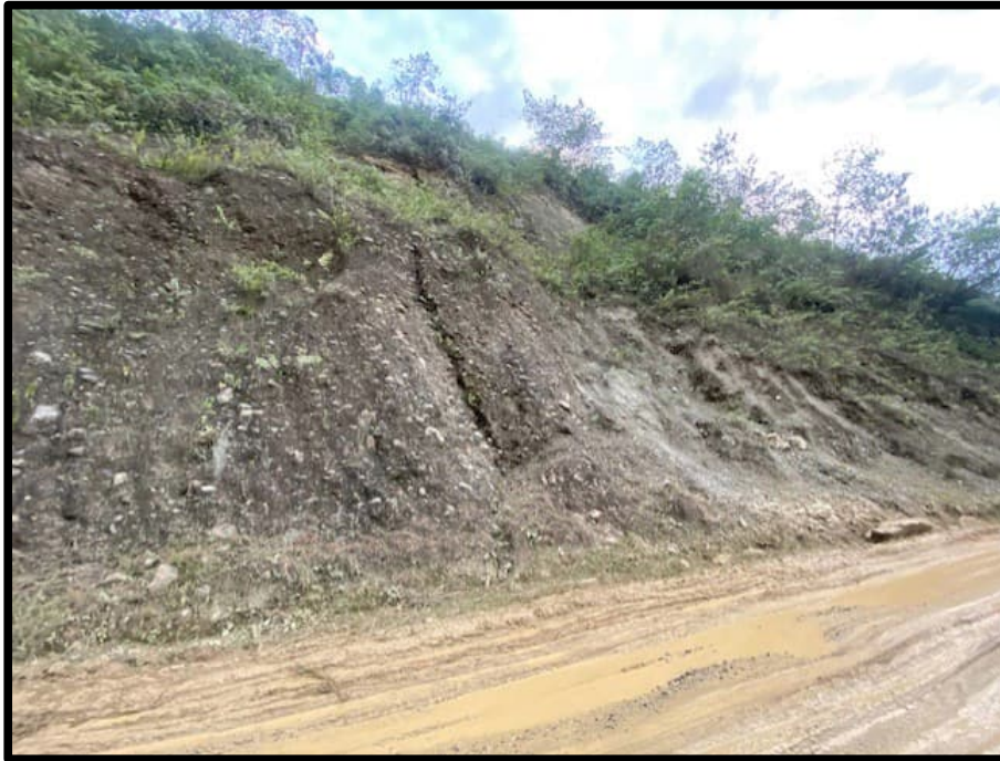
Figura 4.205. Talud Inestable con surcos de erosión hídrica y acumulación material deslizado al pie.
