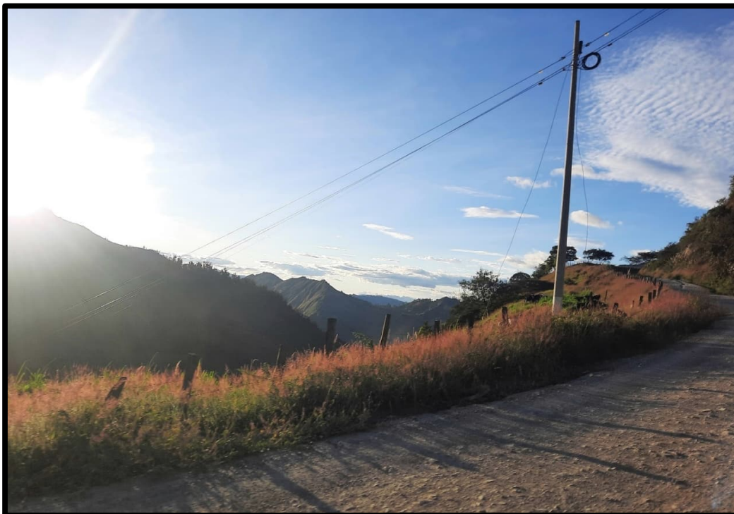
Figura 4.253. Tendido eléctrico en AID del proyecto
