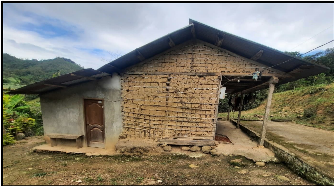
Figura 4.246. Vivienda Mixta entre Zumba y El Tablón
