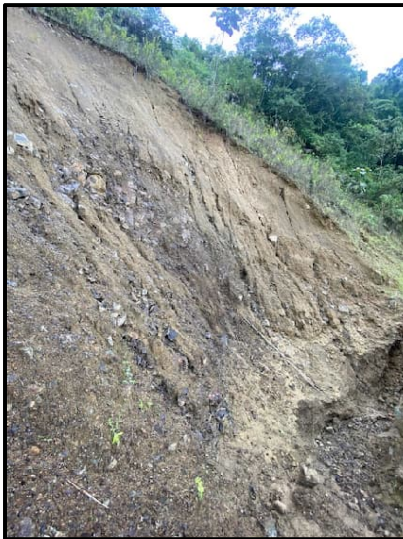
Figura 4.118. Deslizamiento de material y erosión hídrica.
