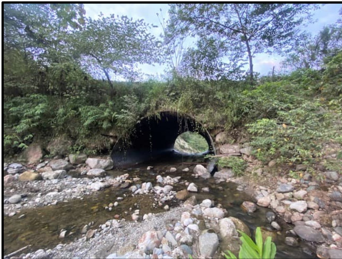
Figura 4.204. Alcantarilla Super SPAN sobre Rio Unganchi.
