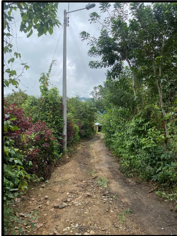
Figura 4.159. Camino estrecho de tierra, postes de luz afectados.
