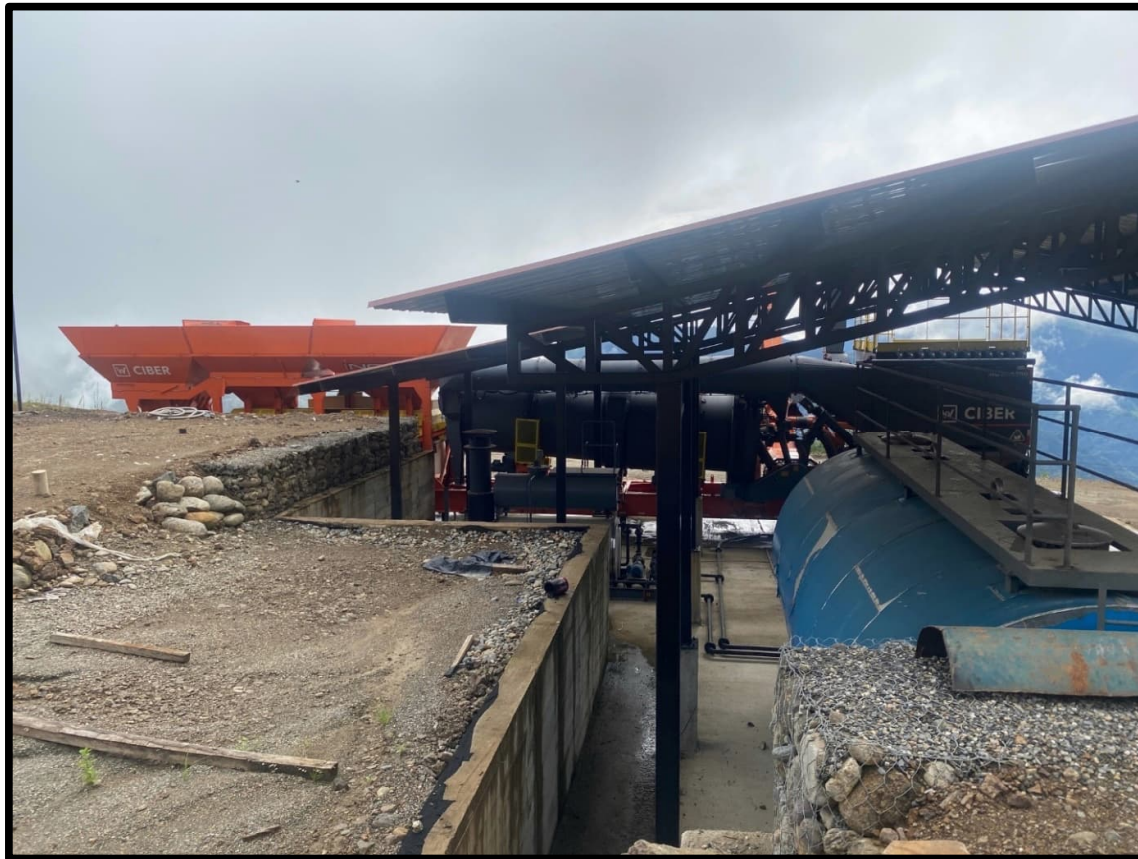
Figura 4.136. Planta de Asfalto.
