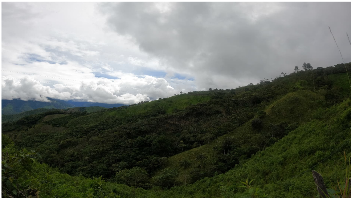
Figura 4.38. Visual de sitios de escombreras. Tramo 1 del Proyecto.
