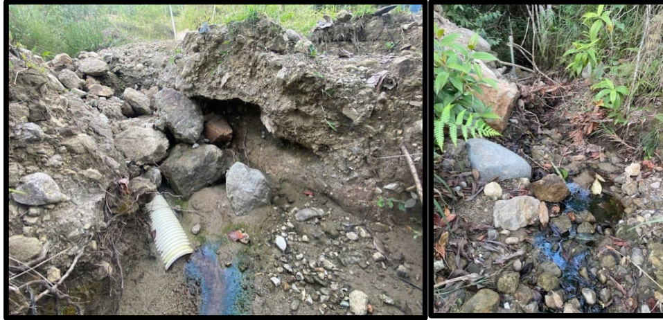
Figura 4.199. Desagüe posible conexión domiciliaria.
