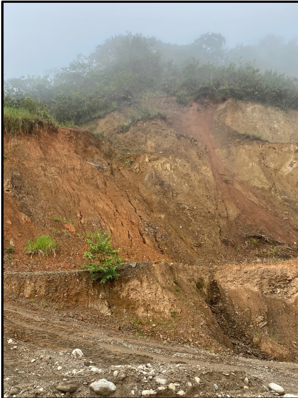
Figura 4.135. Planta de Asfalto, talud inestable, signos de deslizamiento y erosión hídrica.
