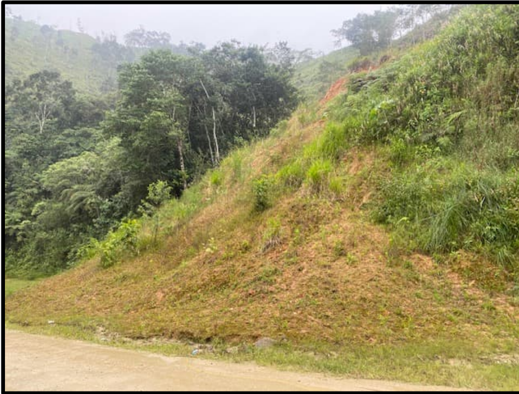
Figura 4.92. Deslizamiento en Tramo Bellavista-Progreso.
