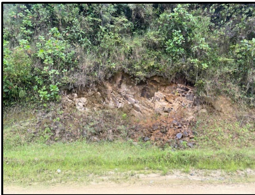
Figura 4.90. Extracción de materiales irregular en ruta.
