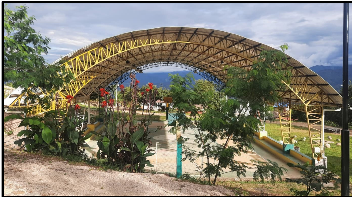
Figura 4.288. Cancha de usos múltiples Pucapamba
