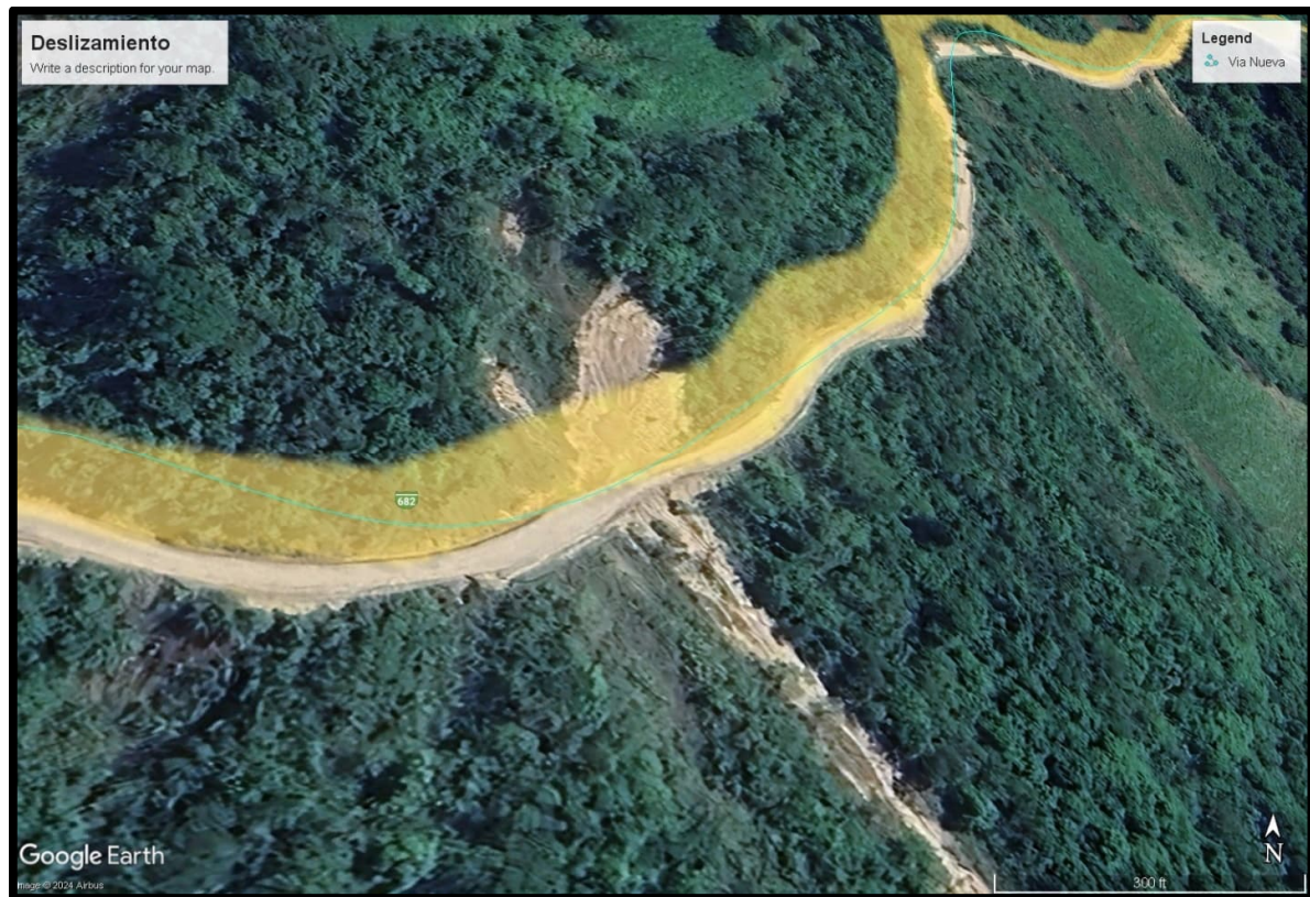
Figura 4.110. Deslizamiento y bote de material a ladera de montaña.
