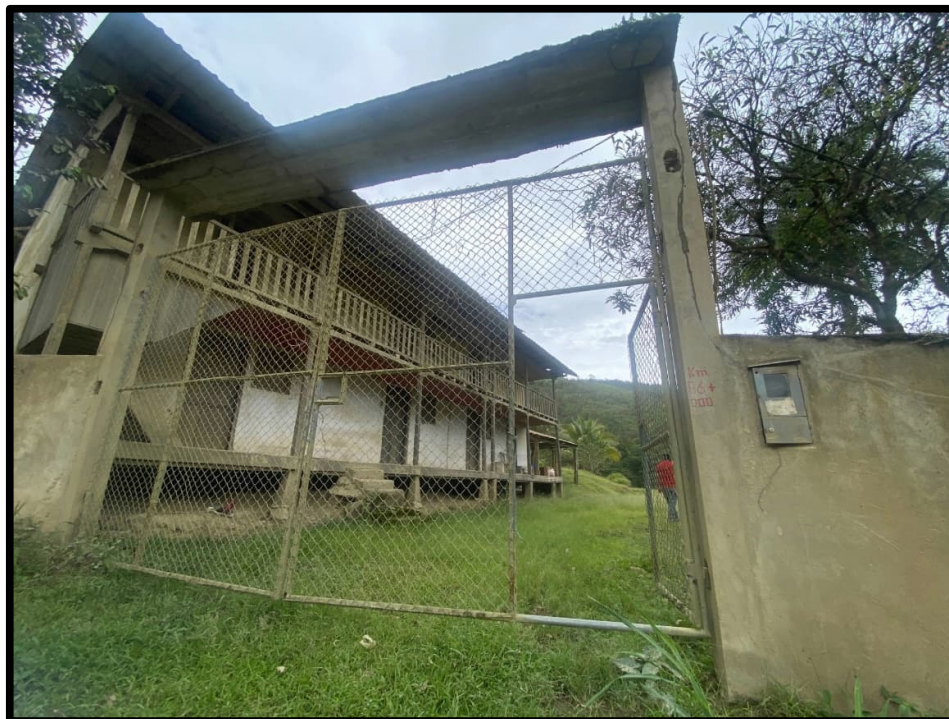
Figura 4.138. Ingreso al terreno de uso agrícola.
