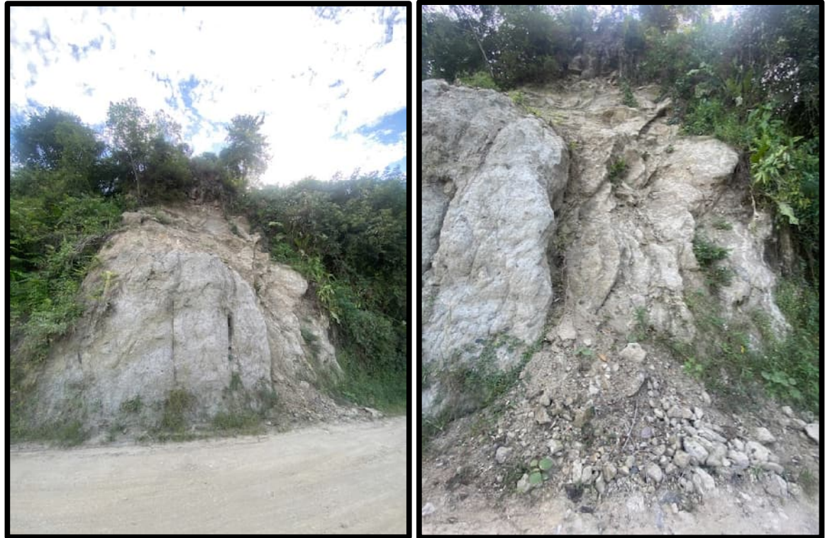
Figura 4.212. Deslizamiento de talud inestable.
