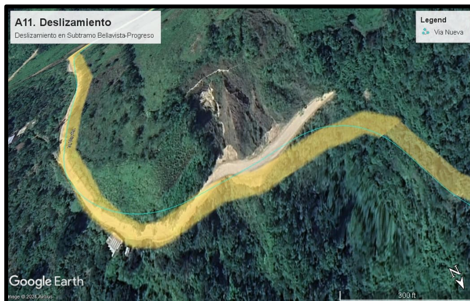
Figura 4.114. Deslizamiento en Subtramo Bellavista-Progreso.
