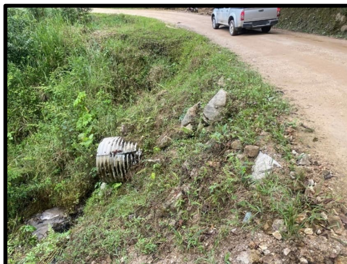
Figura 4.75. Salida de Alcantarilla T15.
