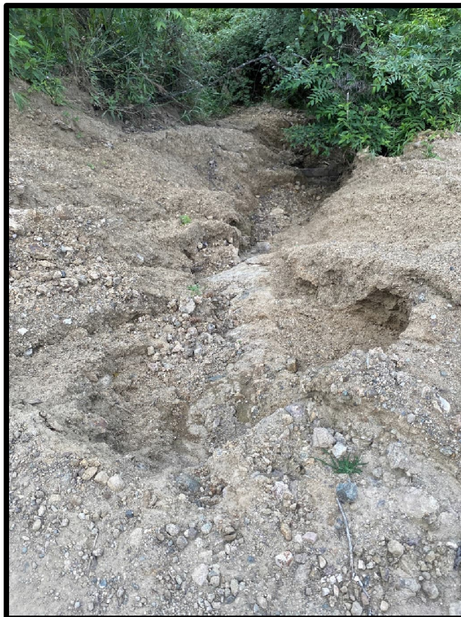
Figura 4.215. Bote lateral de material y erosión ladera de montaña.
