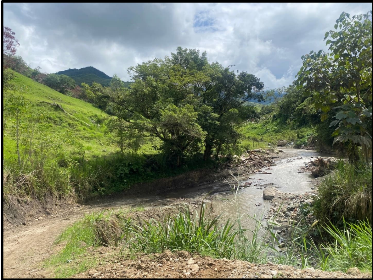
Figura 4.185. Ubicación Puente Zumbayacu sobre Quebrada Zumbayacu.
