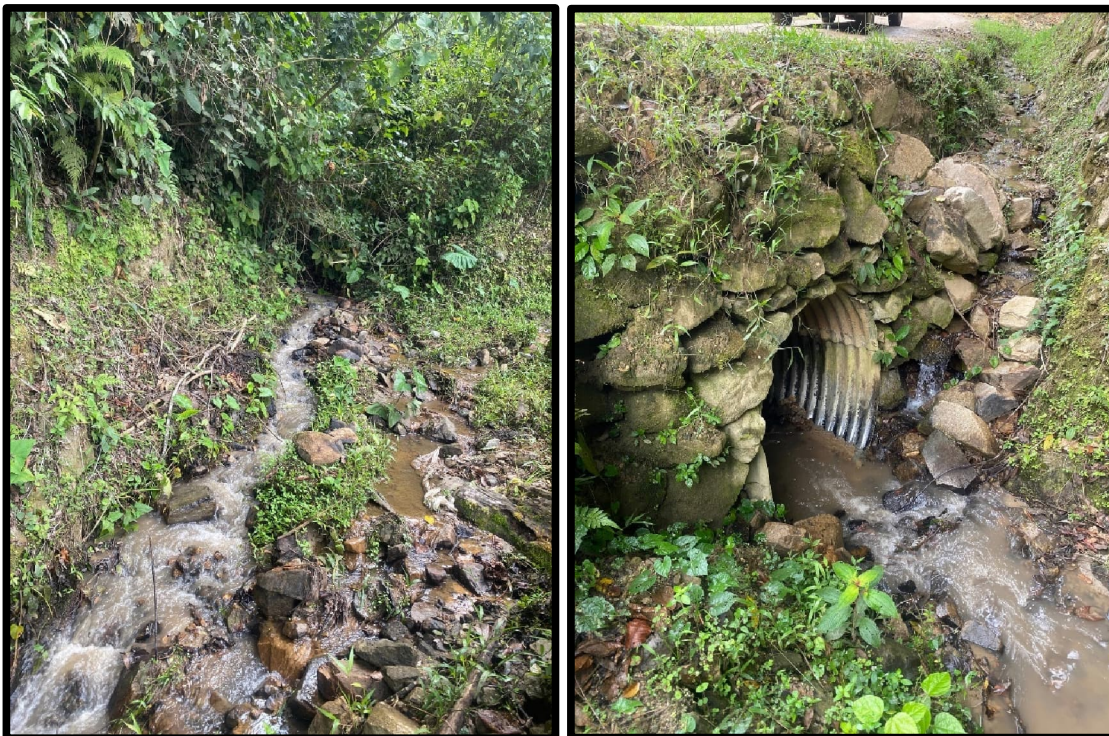
Figura 4.74. Quebrada y sistema de alcantarillado.
