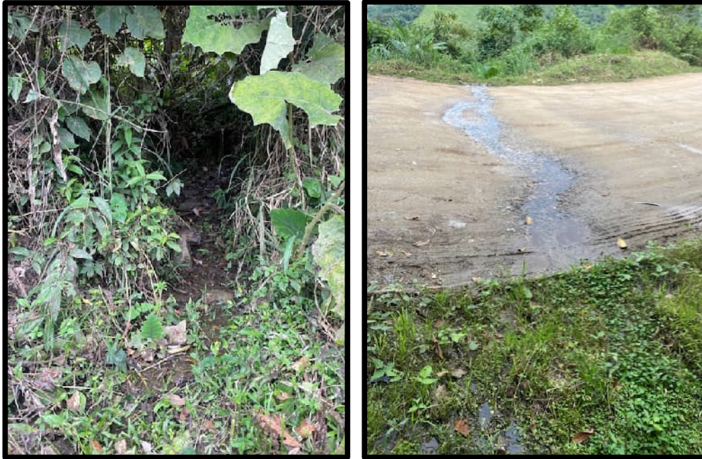
Figura 4.86. Quebrada Progreso sin alcantarillado.
