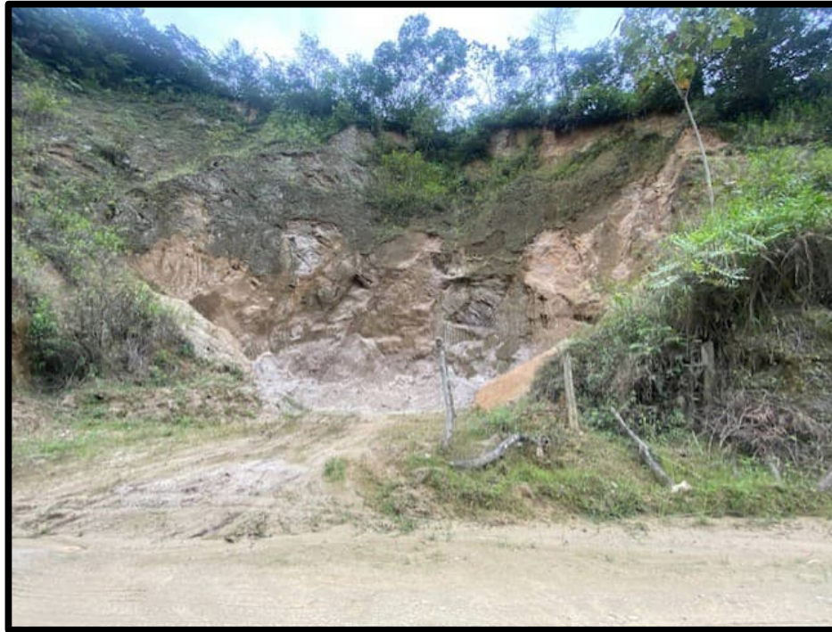
Figura 4.103. Extracción de Materiales en talud inestable de la vía.
