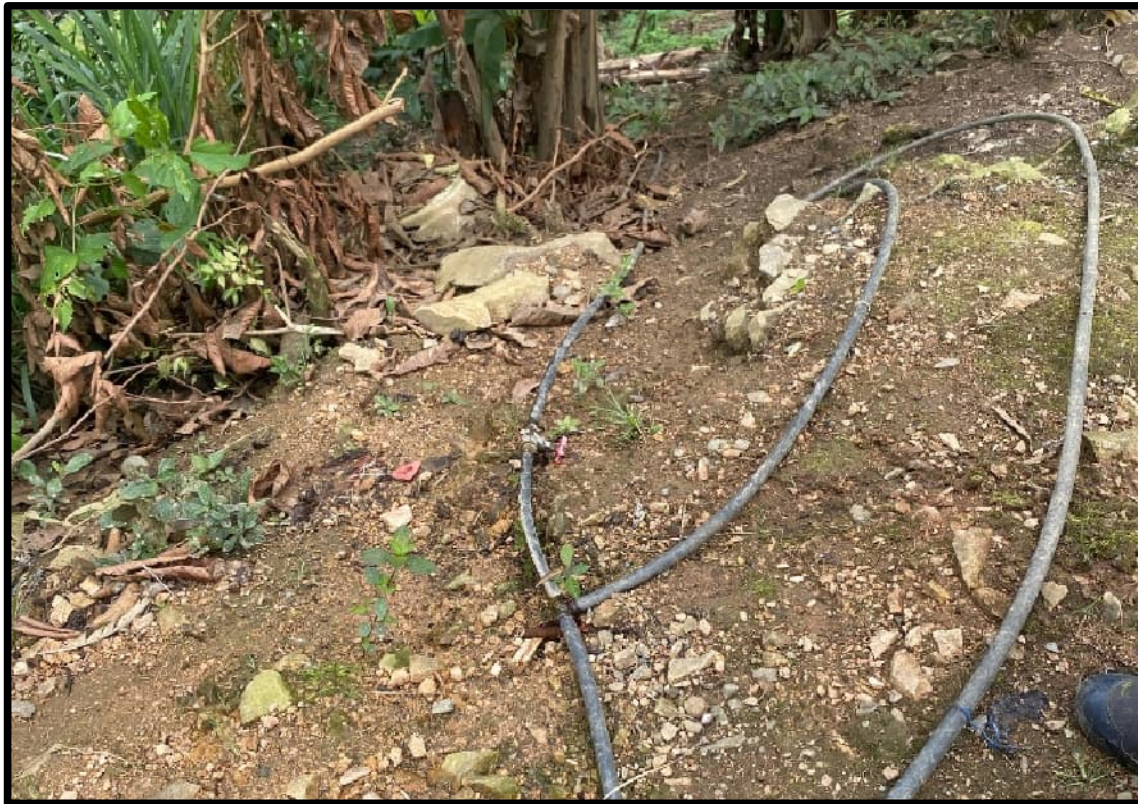
Figura 4.255. Conexiones de agua sobre vía alterna Palanda-Progreso.
