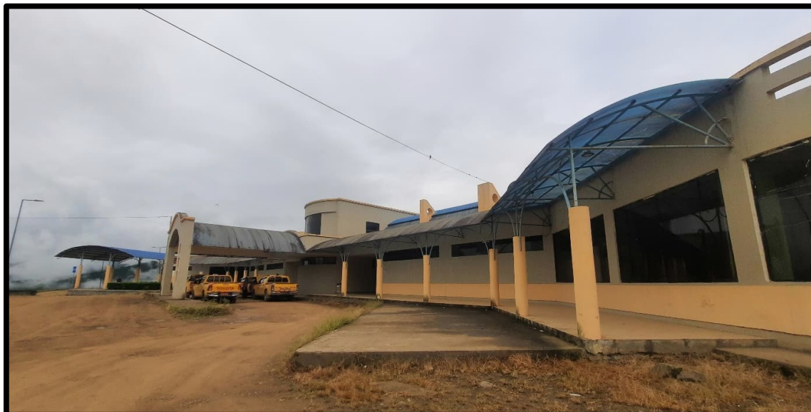
Figura 4.278. Terminal de Bus Zumba
