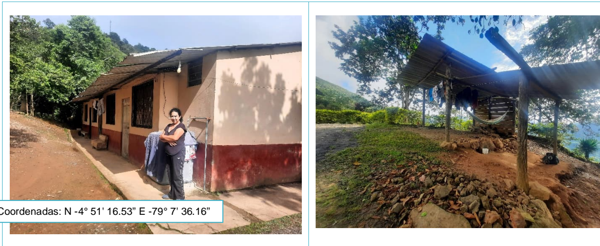
Figura 8.7: Vivienda Afectada N°4
