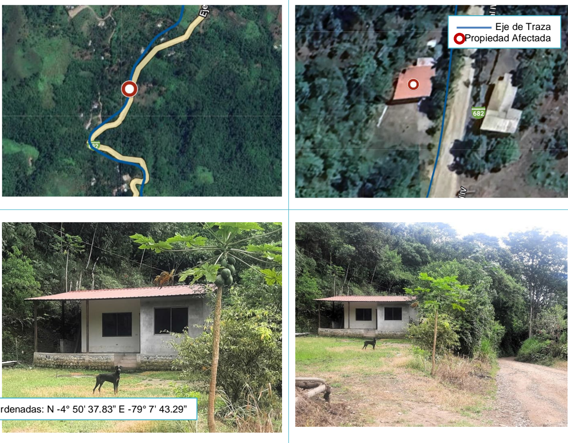
Figura 8.9: Vivienda Afectada N°6
