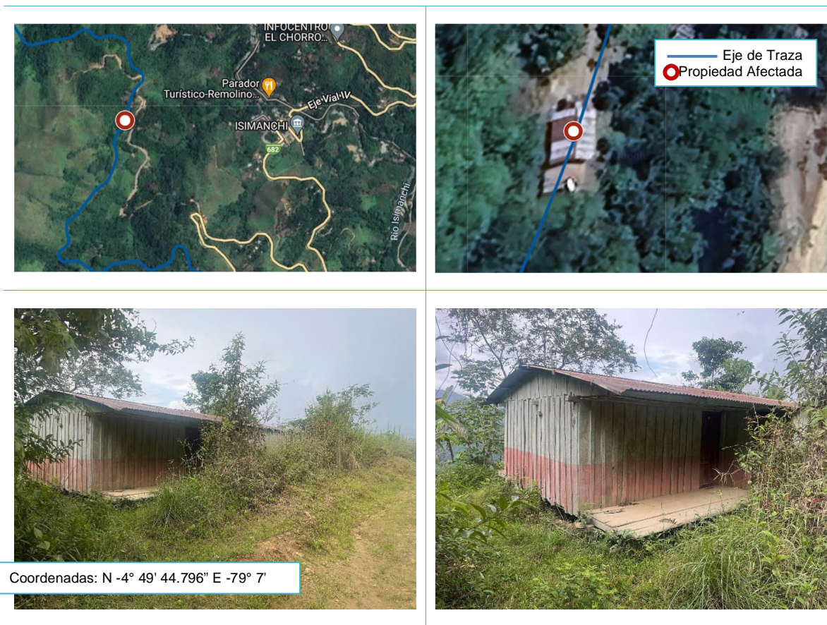
Figura 8.10: Vivienda Afectada N°7
