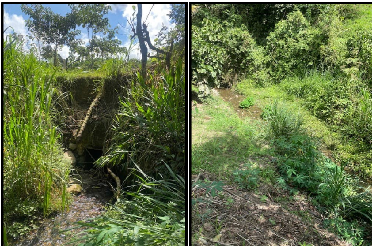
Figura 4.186. Alcantarilla T7 y quebrada s/n.
