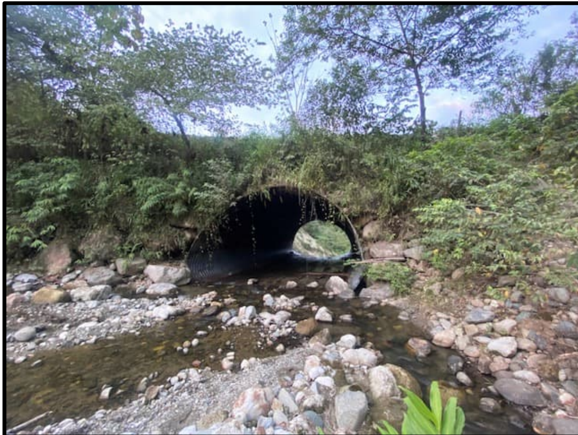
Figura 4.204. Alcantarilla Super SPAN sobre Rio Unganchi.
