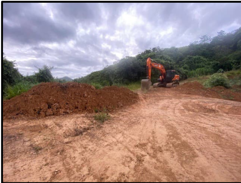
Figura 4.201. Ubicación Extracción de Pétreos al margen de la vía actual.
