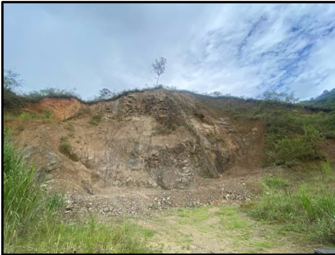
Figura 4.155. Extracción de Material Pétreo sobre ruta actual.
