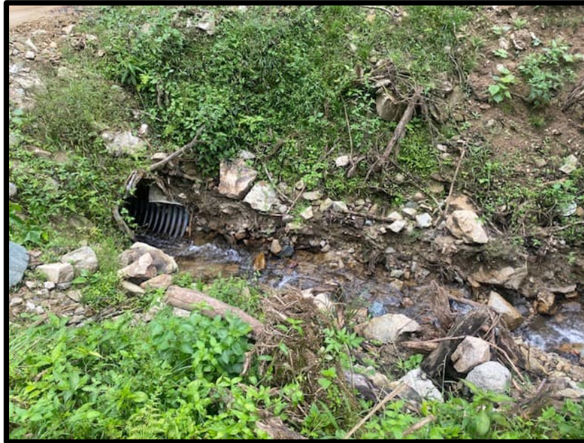
Figura 4.72. Estado de salida de la Alcantarilla.
