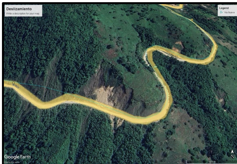
Figura 4.93. Deslizamiento en Ruta Tramo Bellavista-Progreso.
