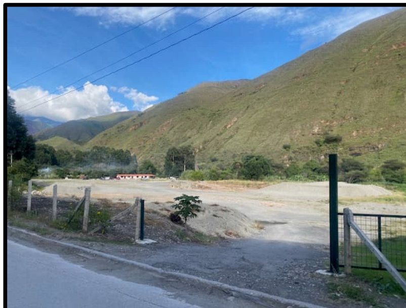
Figura 4.128. Antigua Planta de Asfalto.
