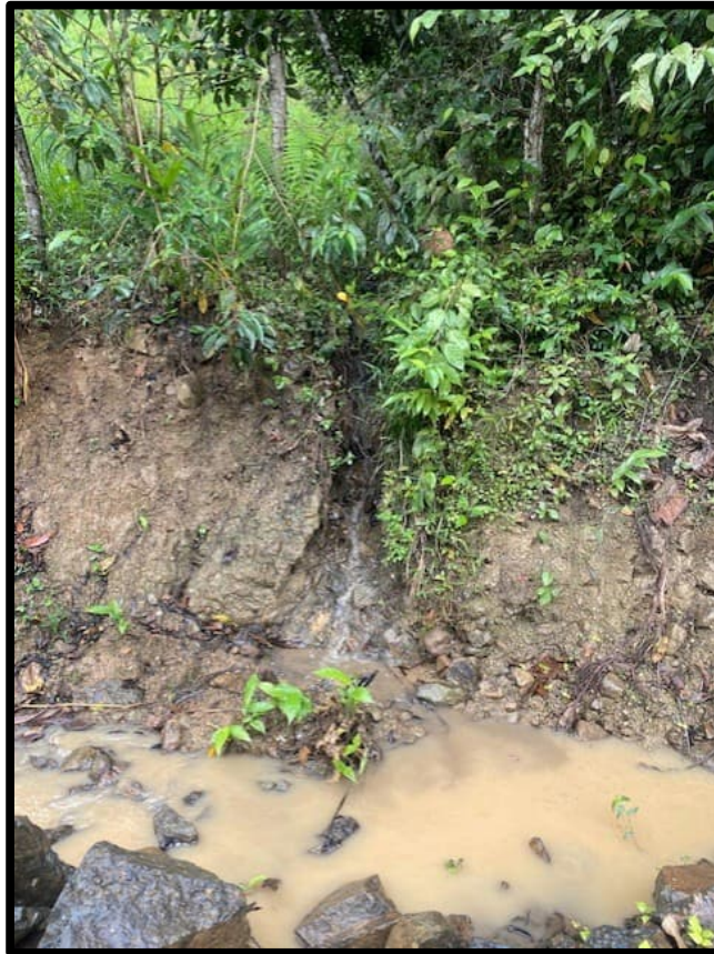
Figura 4.179. Quebrada S/N de Alcantarilla T5.
