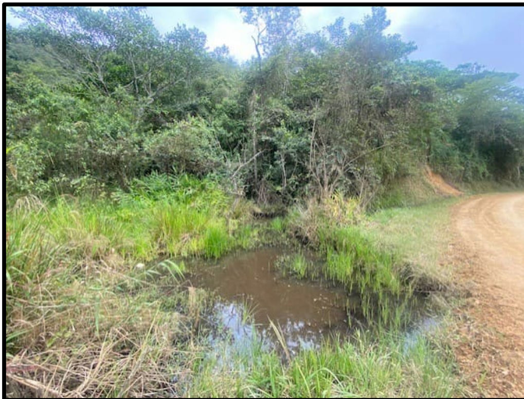
Figura 4.191. Anegamiento de Agua al margen de la vía.
