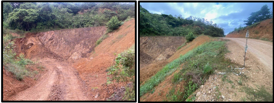
Figura 4.202. Extracción de materiales al margen de la vía.
