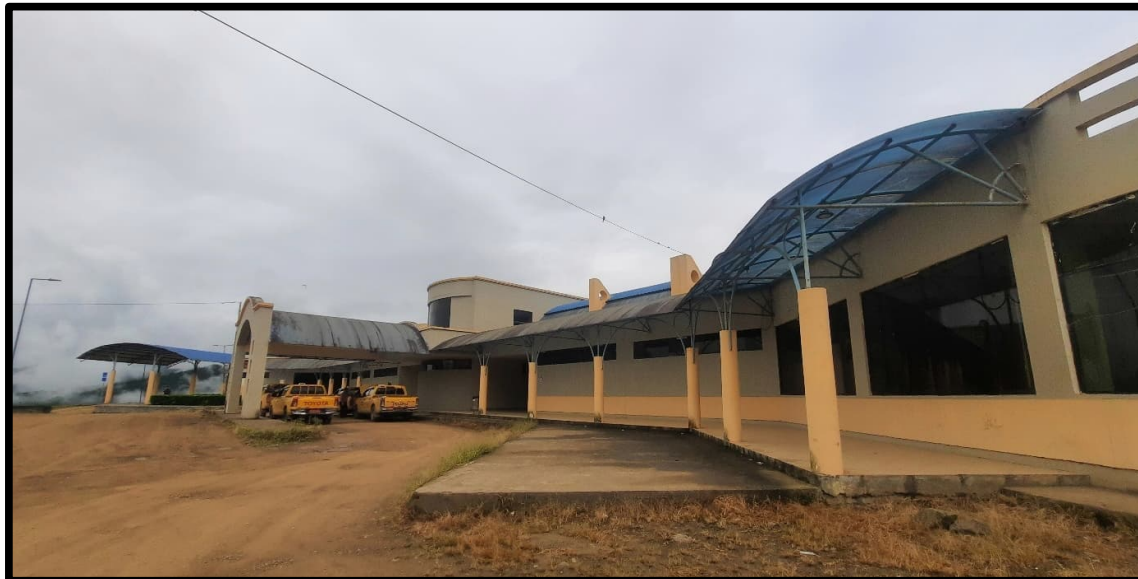
Figura 4.278. Terminal de Bus Zumba
