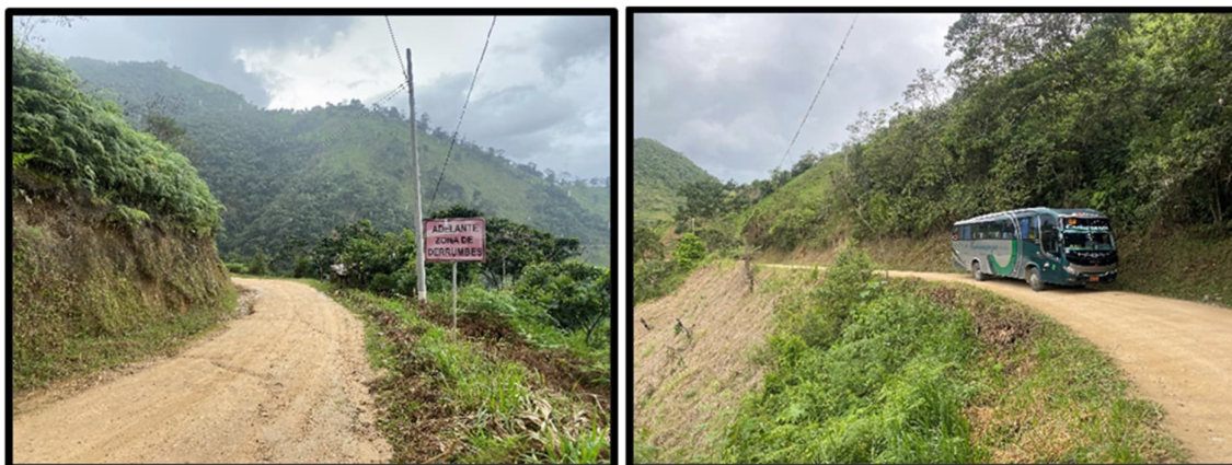
Figura 4.63. Tramo Bellavista-Progreso, ancho de calzada reducido e interferencias.
