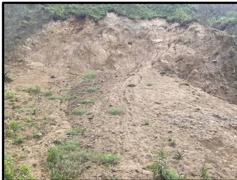
Figura 4.95. Deslizamiento de tierra y cárcavas por erosión hídrica.
