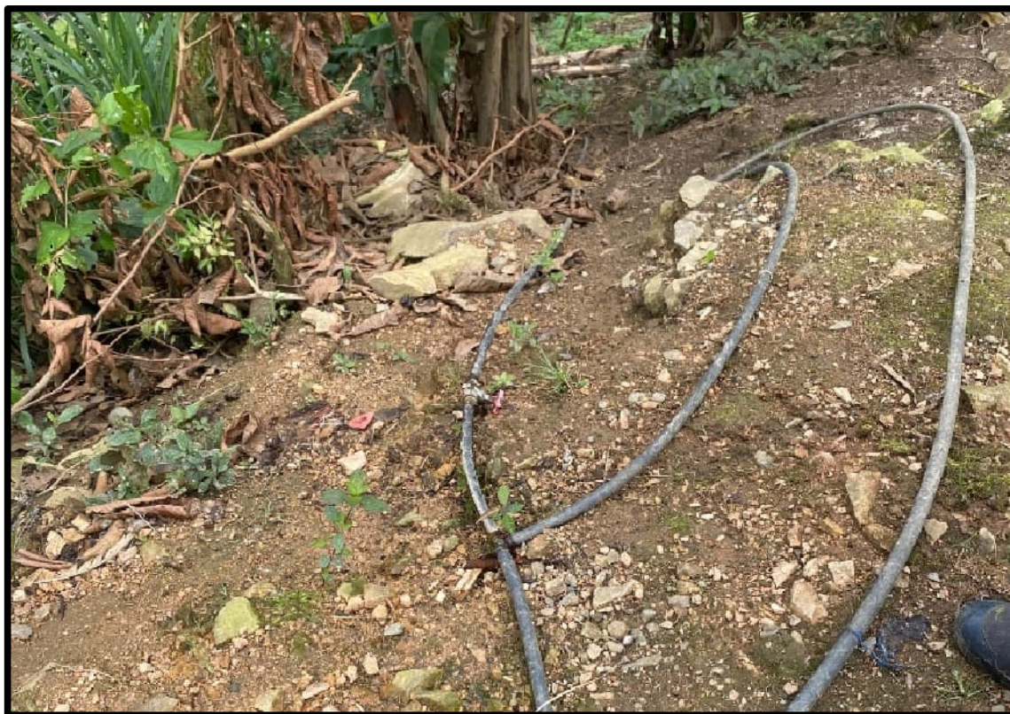
Figura 4.255. Conexiones de agua sobre vía alterna Palanda-Progreso.
