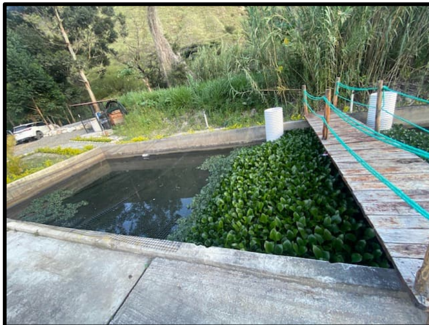
Figura 4.130. Antiguas piletas de tratamiento de aguas residuales.
