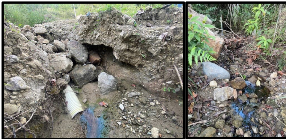
Figura 4.199. Desagüe posible conexión domiciliaria.
