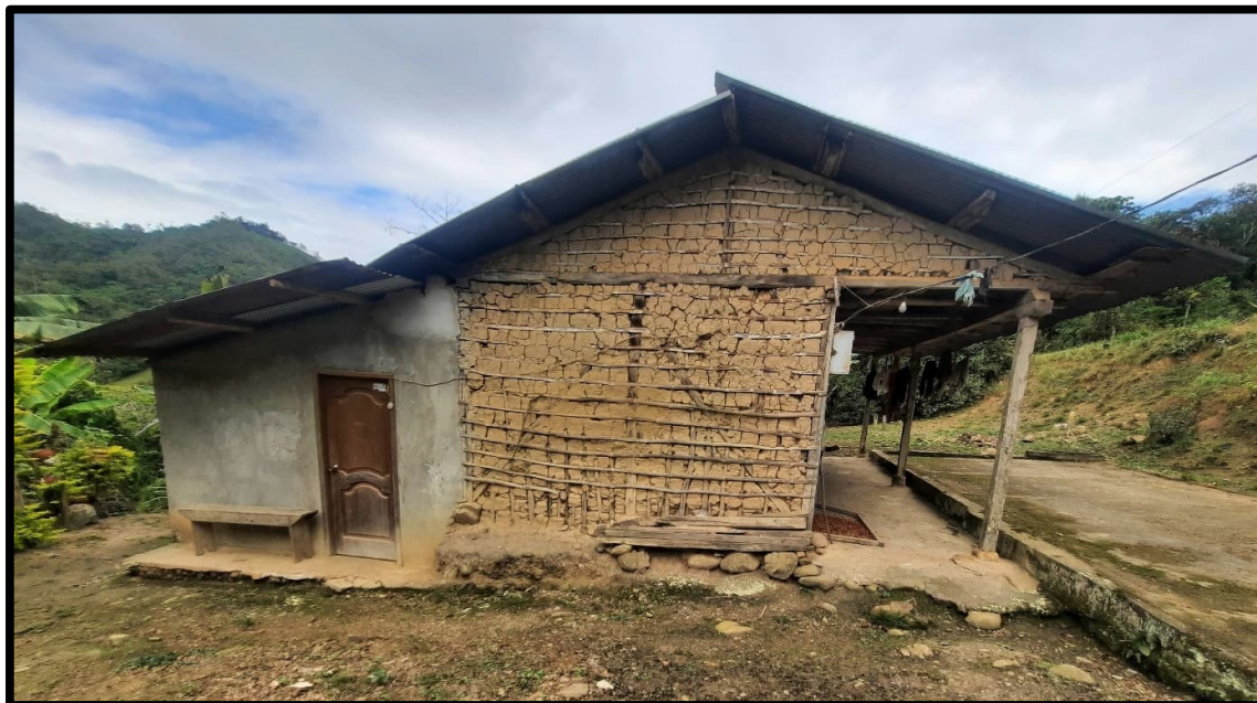
Figura 4.246. Vivienda Mixta entre Zumba y El Tablón
