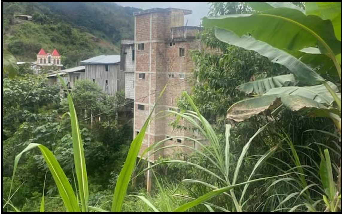
Figura 4.250. Centro de Progreso, sobre ladera de montaña.
