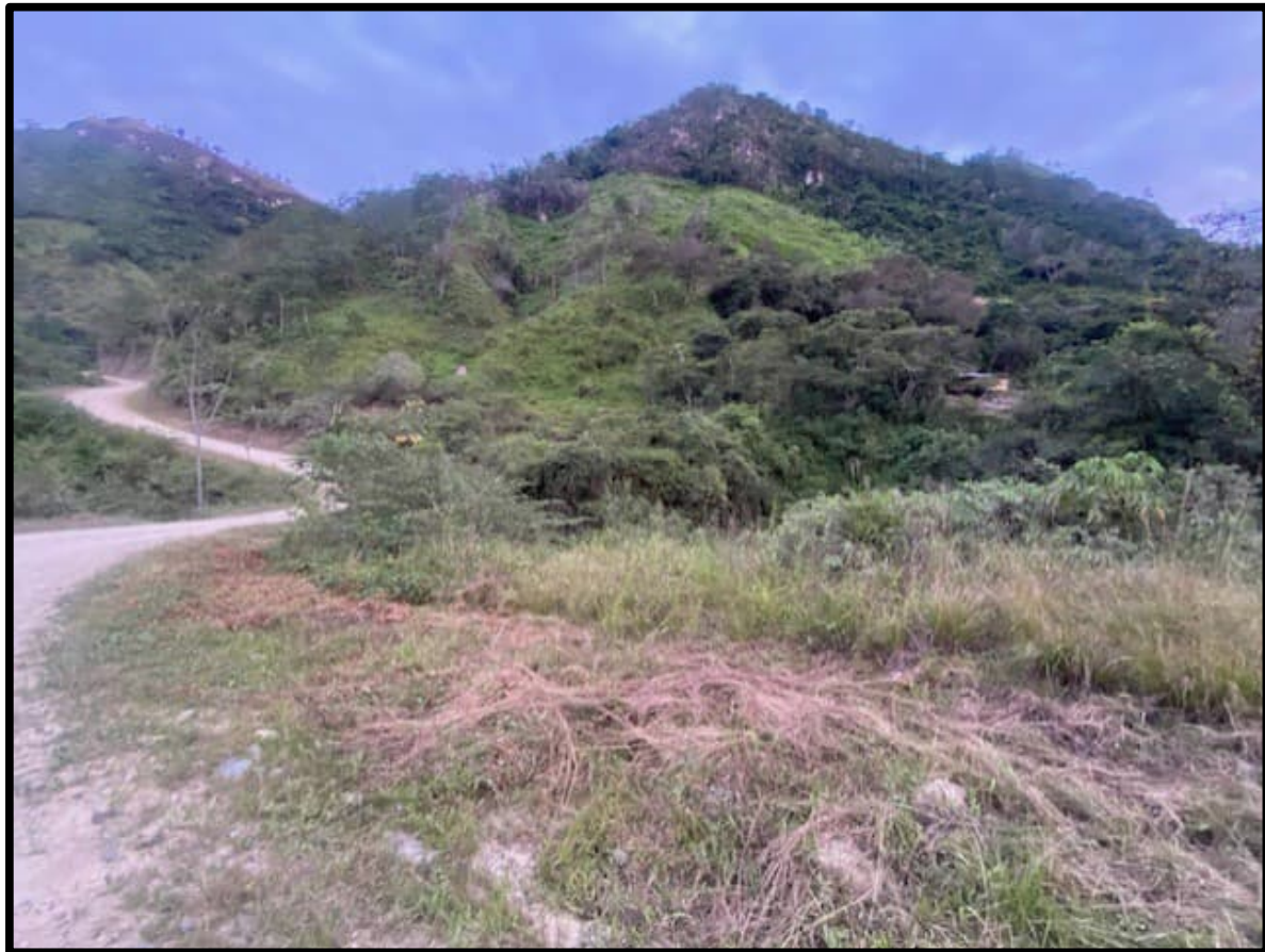
Figura 4.198. Alcantarilla Super SPAN actual (camino a la izquierda) y emplazamiento de nuevo Puente Uganche.
