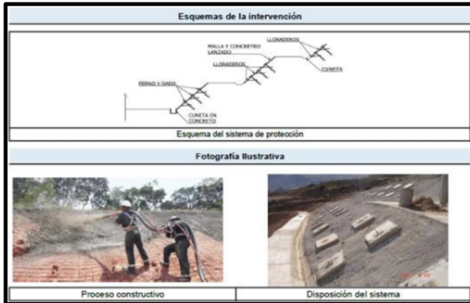
Figura 2.13. Infraestructura Gris. Protección con malla reforzada y concreto lanzado.
