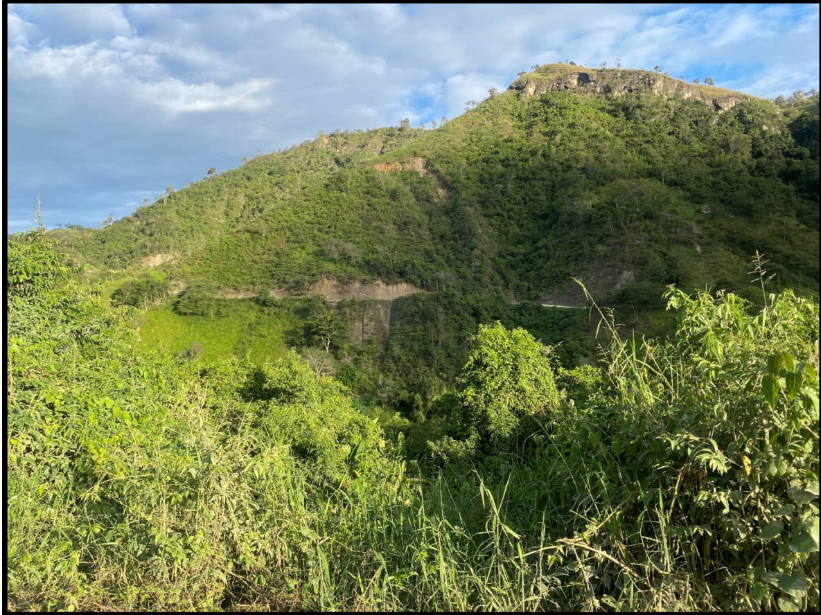
Figura 4.220. Taludes de Conglomerados en El Chorro.
