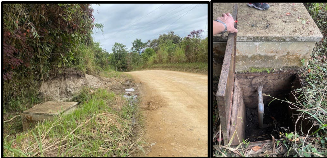
Figura 4.165. Desarenador al margen del Eje Vial IV, a 1km del Chorro.
