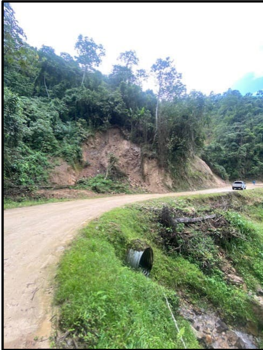
Figura 4.113. Derrumbe y caída de árboles.
