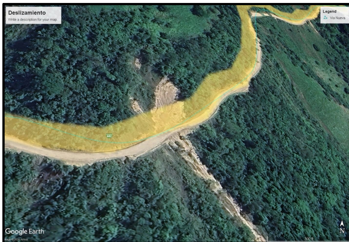
Figura 4.110. Deslizamiento y bote de material a ladera de montaña.
