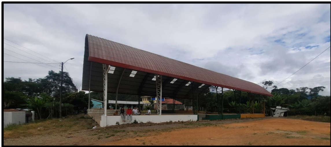
Figura 4.287. Cancha de usos múltiples El Tablón
