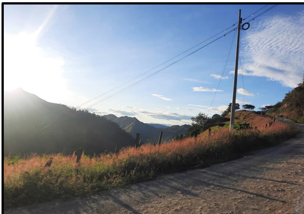
Figura 4.253. Tendido eléctrico en AID del proyecto
