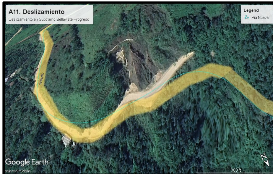
Figura 4.114. Deslizamiento en Subtramo Bellavista-Progreso.
