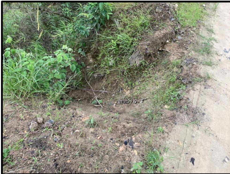
Figura 4.119. Bote lateral de material de deslizamiento y erosión en margen de ruta.
