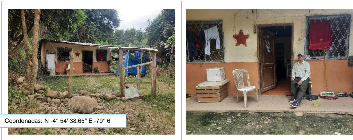
Figura 8.4: Vivienda Afectada N°1
