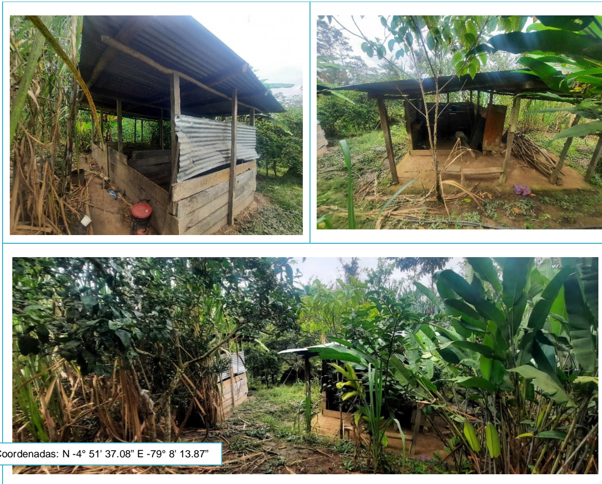
Figura 8.3: Afectación Infraestructura Económica N°2
