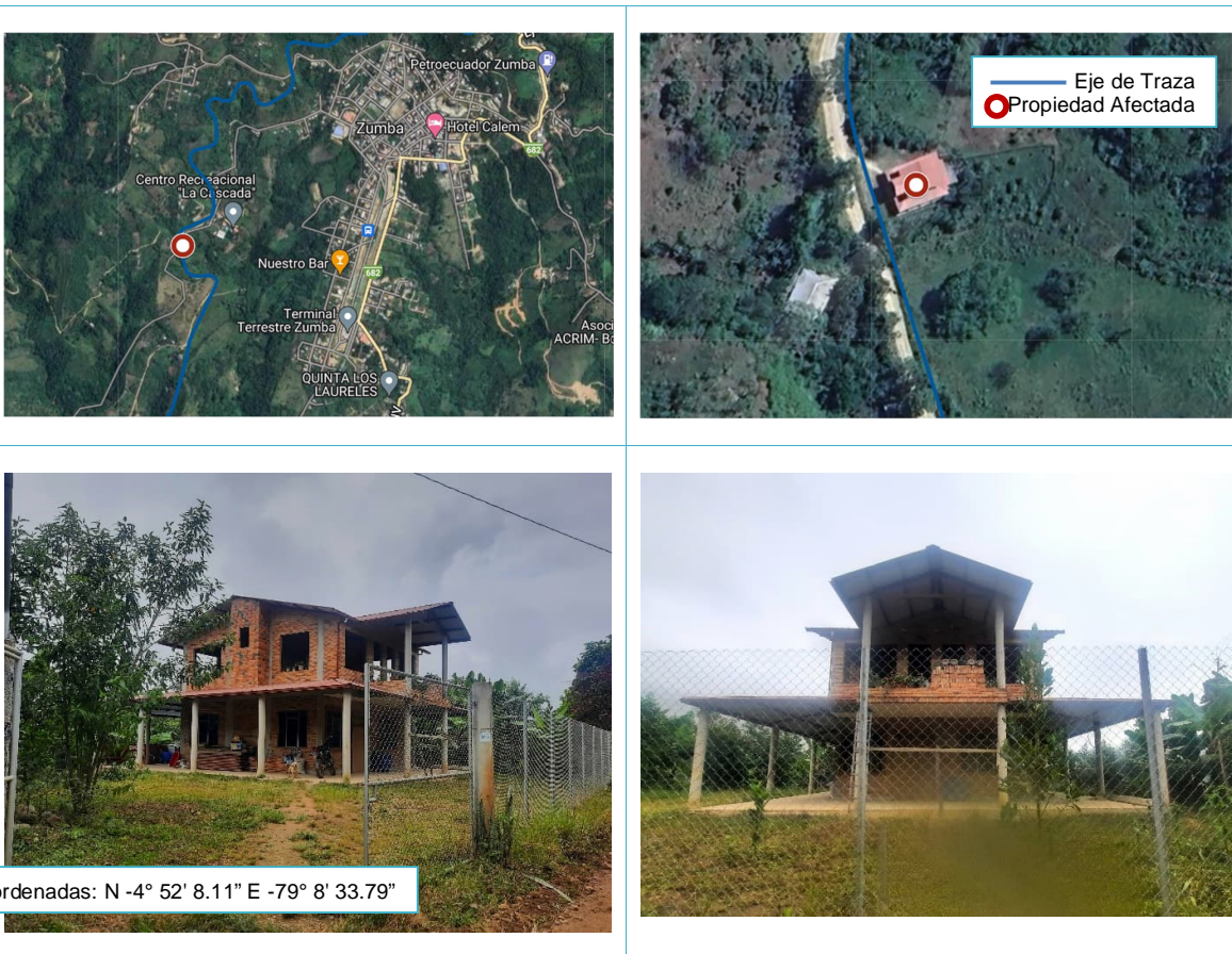
Figura 8.5: Vivienda Afectada N°2
