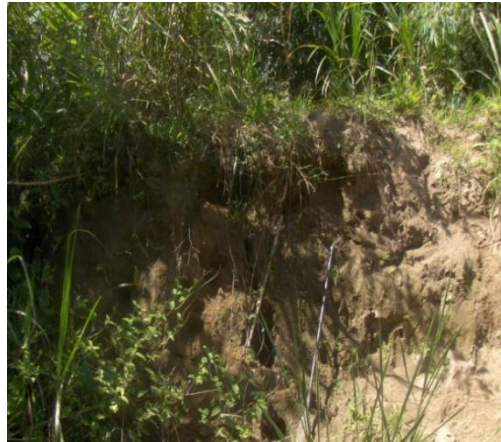
Fotografía 16. Calicata Perfil del suelo en el área del proyecto.
