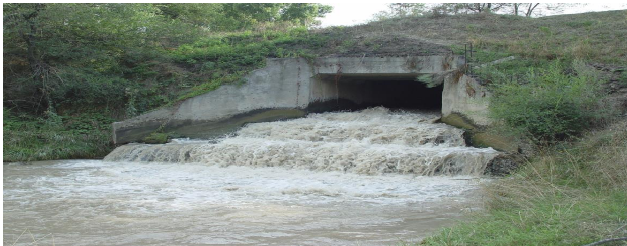
Сброс воды с плотины водохранилища
