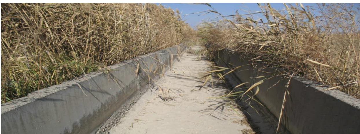
Общий вид сечений прямоугольных железобетонных каналов
