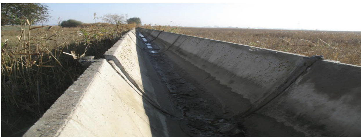
Общий вид сечений железобетонных каналов
