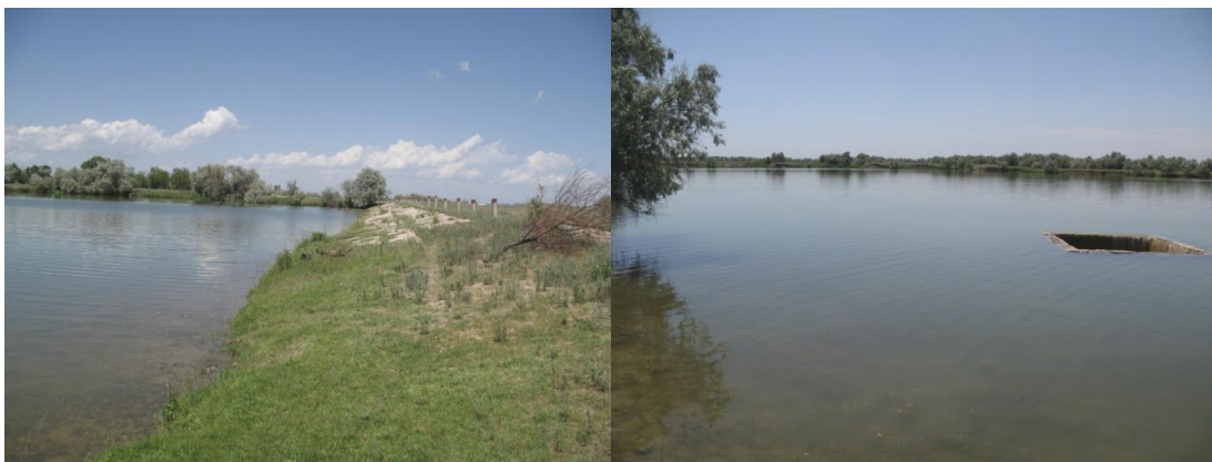
Нижняя плотина с донным водосбросом на реке Карасу-Байсерке
