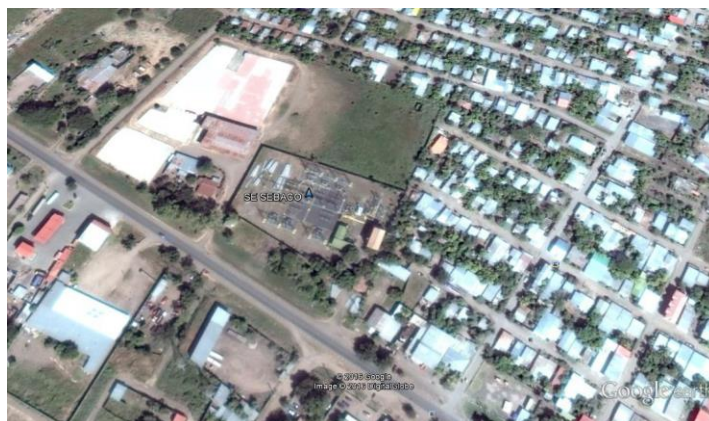
Figura No.- 24.-Subestación Sébaco
