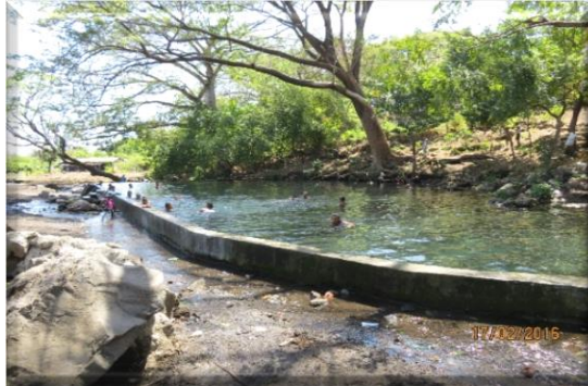
Poza La Piscina, usada como fuente de abastecimiento de agua local.
