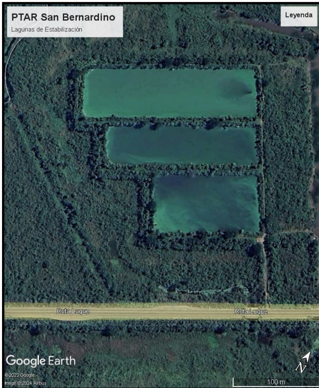
Figura 1.130. PTAR San Bernardino, compuesta por lagunas de estabilización
