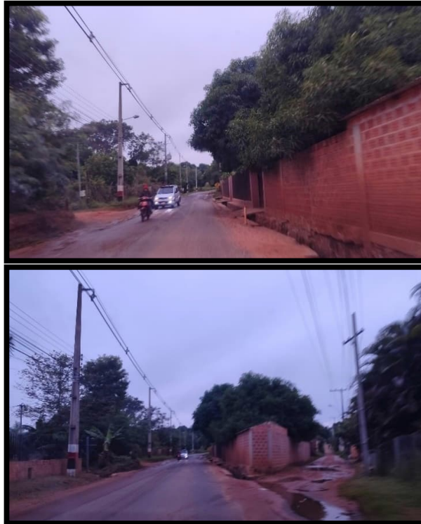
Figura 1.78. Elementos de captación pluvial anegados sobre Ruta Departamental D076.
