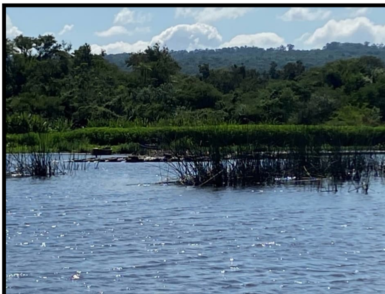
Figura 1.21. Estado actual de estructura de Geobolsas en la embocadura del Río Salado en el lago Ypacaraí
