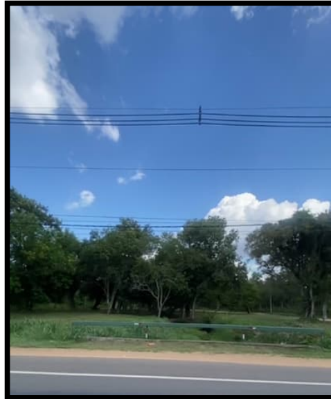
Figura 1.127. Puente sobre Arroyo Agua-y, Ruta Luque-San Bernardino.
