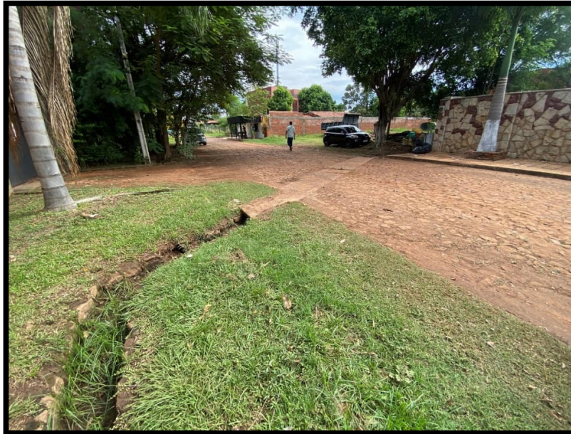
Figura 1.106. Zanja de captación pluvial y calle empedrada en sobre Calle Carmen de Peña y Ruta Nacional YP02.
