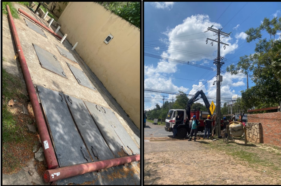
Figura 1.125. (a) Estación de Bombeo N°4; (b) reposición postes de tendido eléctrico.
