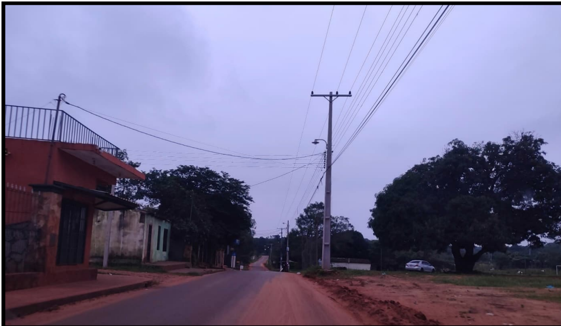
Figura 1.74. Calzada reducida, líneas de tensión y procesos erosivos en márgenes de vereda sobre Valle Karé.
