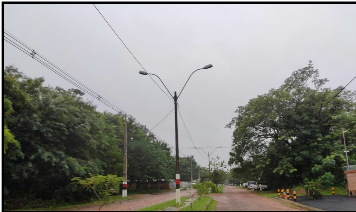
Figura 1.83. Avenida Mariscal Estigarribia, tendido eléctrico e iluminación.
