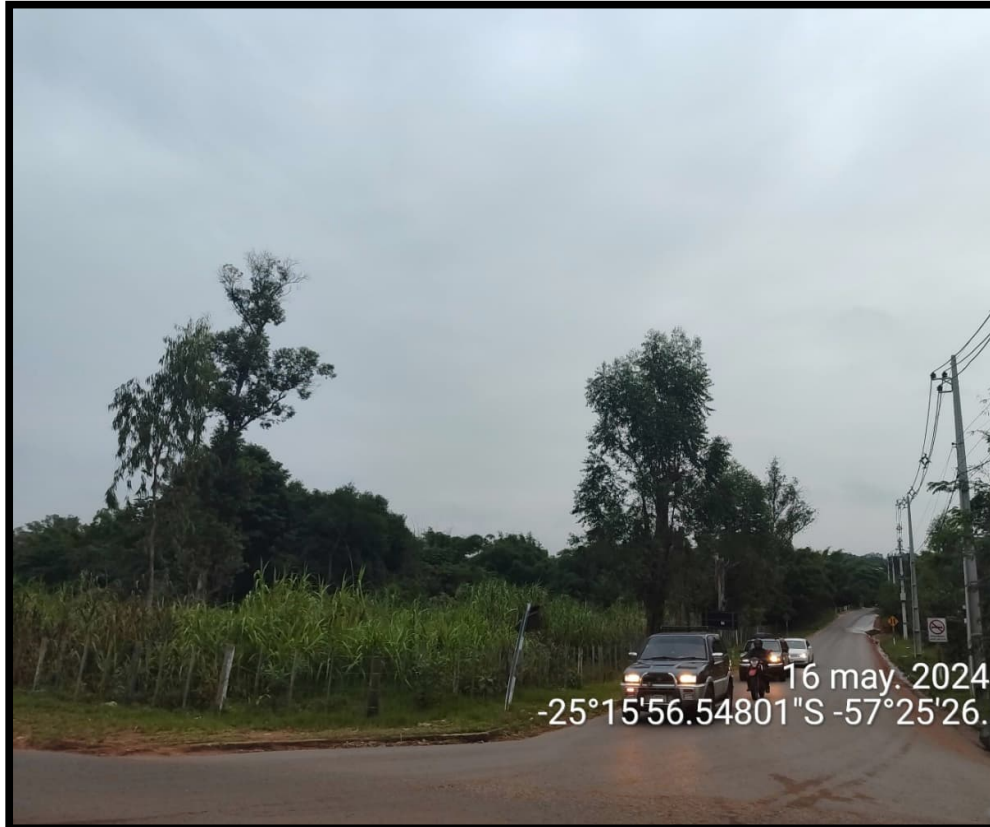
Figura 1.54. Predio de emplazamiento Estación de Bombeo sobre Ruta Departamental D076.
