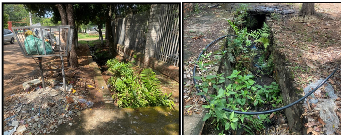
Figura 1.102. Zanjas de desagüe pluvial en estado de deterioro, acumulación de sedimentos y basura y con conexiones irregulares.
