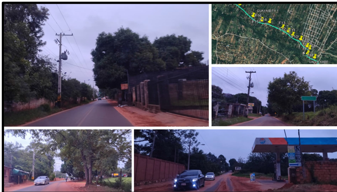
Figura 1.75. Entorno residencial mixto, viviendas, comercios, líneas de tendido eléctrico de media tensión margen izquierdo sobre RD076.
