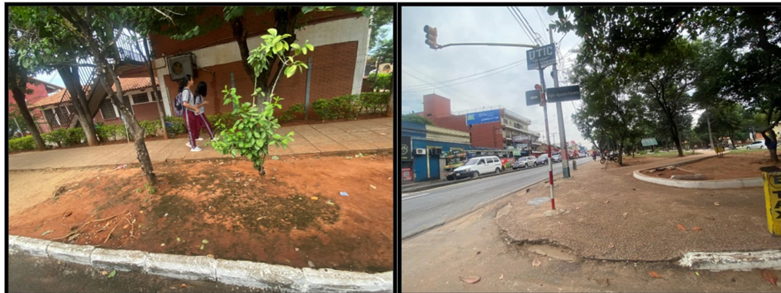
Figura 1.95. Capiatá: (a) Falta de desagües pluviales y erosión de suelo en veredas; (b) línea de media tensión sobre ruta departamental.
