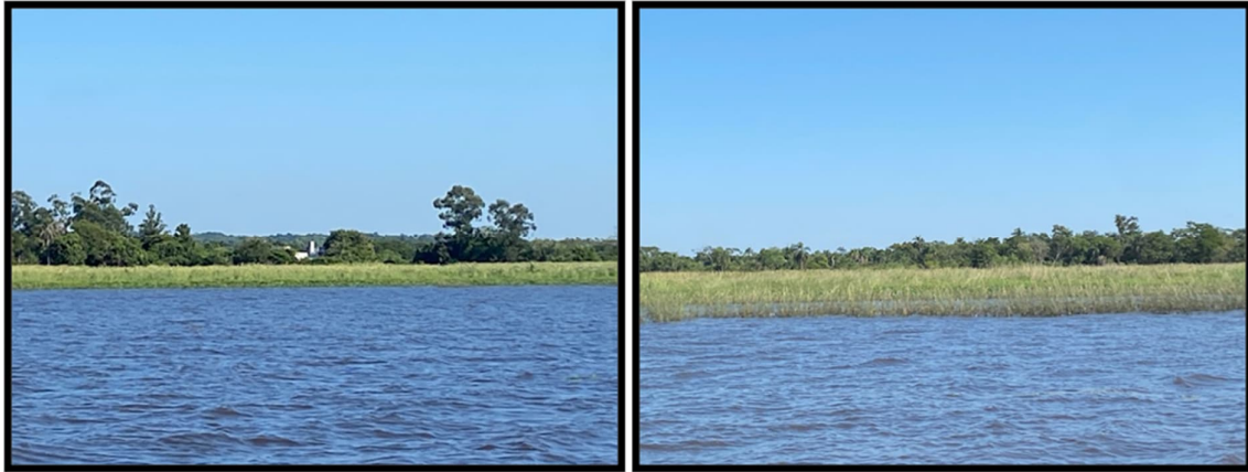
Figura 1.15: (a) Zona de Inicio del Dique; (b) Zona de Fin del Dique
