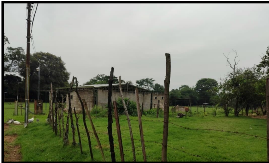
Figura 1.44. Predio Primera Estación de Bombeo Capiatá.
