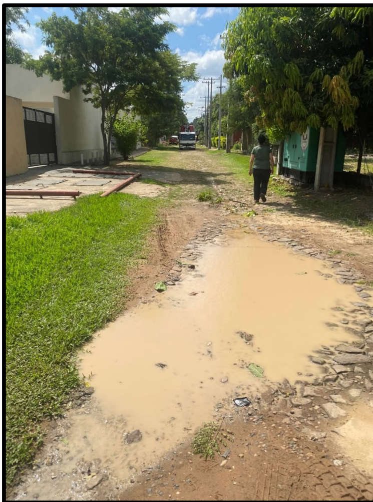
Figura 1.124. Emplazamiento de la Estación de Bombeo N°4, San Bernardino.
