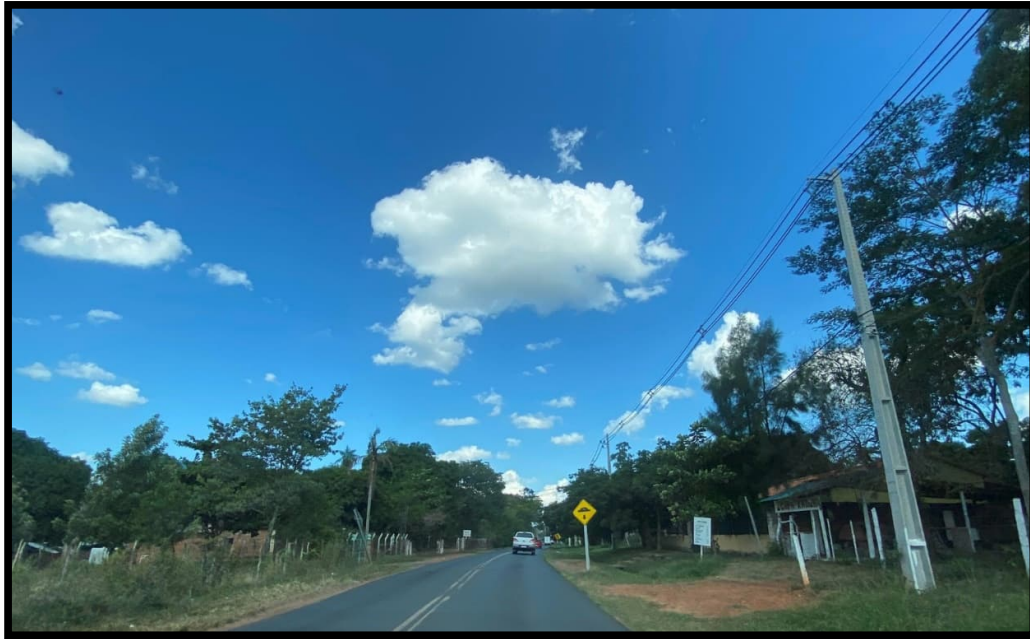
Figura 1.89. Calle Mariscal Francisco Solano López, trazado línea de impulsión Areguá.
