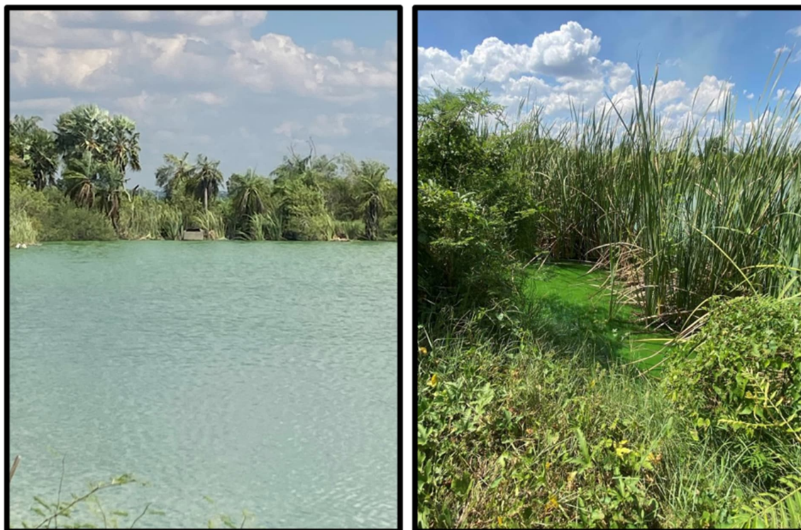
Figura 1.133. Lagunas de estabilización: (a) Entrada del agua; (b) crecimiento de algas en las lagunas
