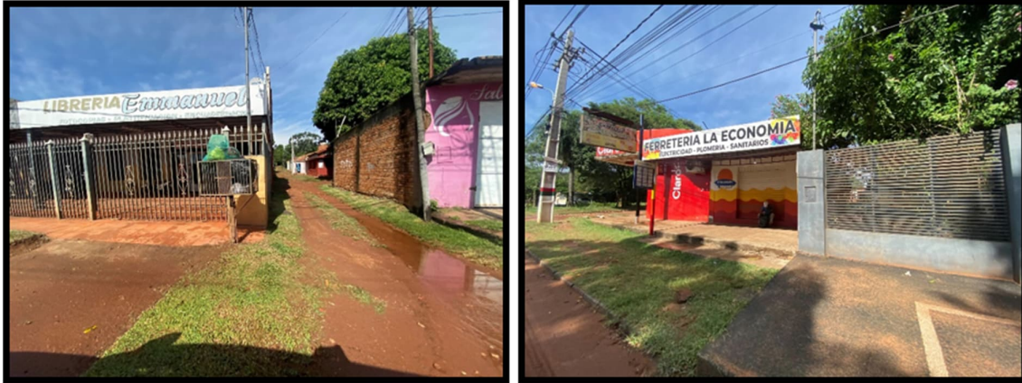
Figura 1.50. Comercios y viviendas, anegamiento de agua y arrastre de sedimentos.
