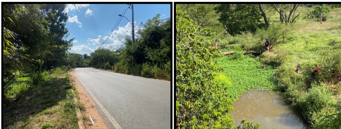
Figura 1.55. Puente sobre Arroyo Yukyry-Mi y actividad de pesca sobre el Arroyo.
