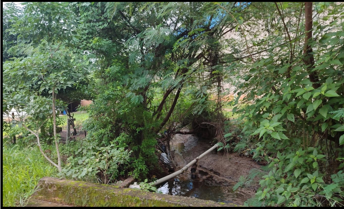
Figura 1.69. Conexión irregular a canal sobre calle sin nombre.
