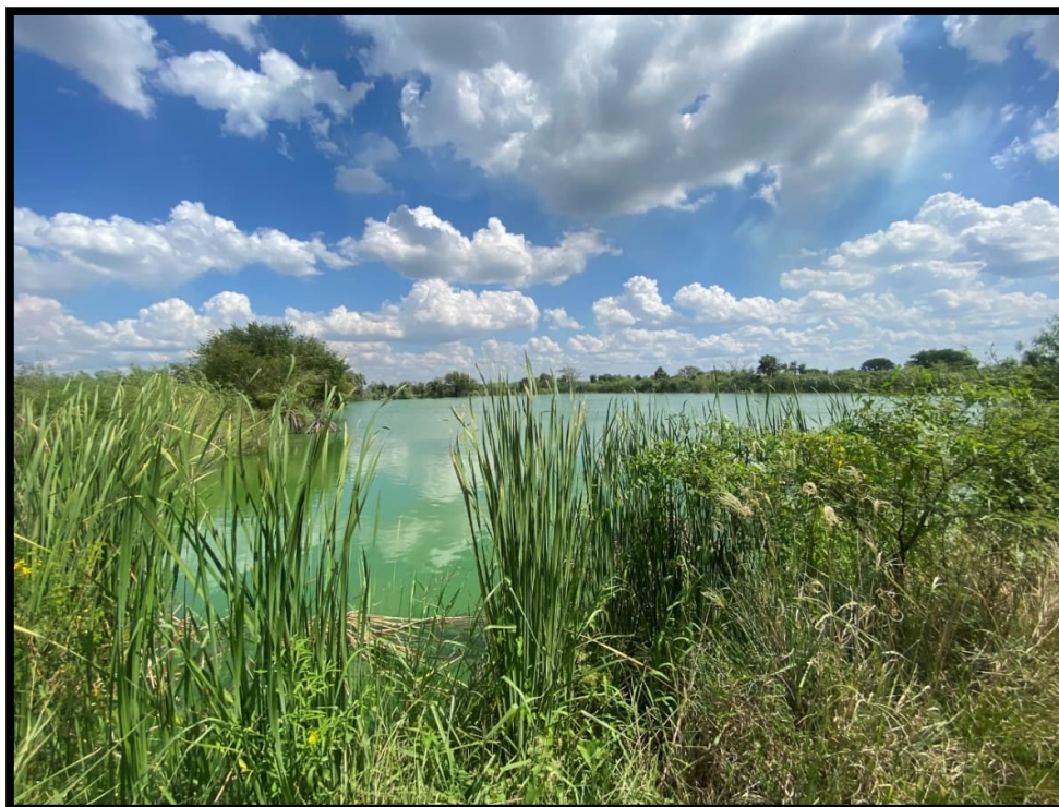
Figura 1.132. Lagunas de estabilización, PTAR San Bernardino.
