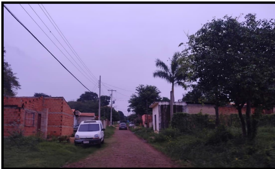
Figura 1.45. Camino de acceso al predio de la Primera Estación de Bombeo Capiatá.
