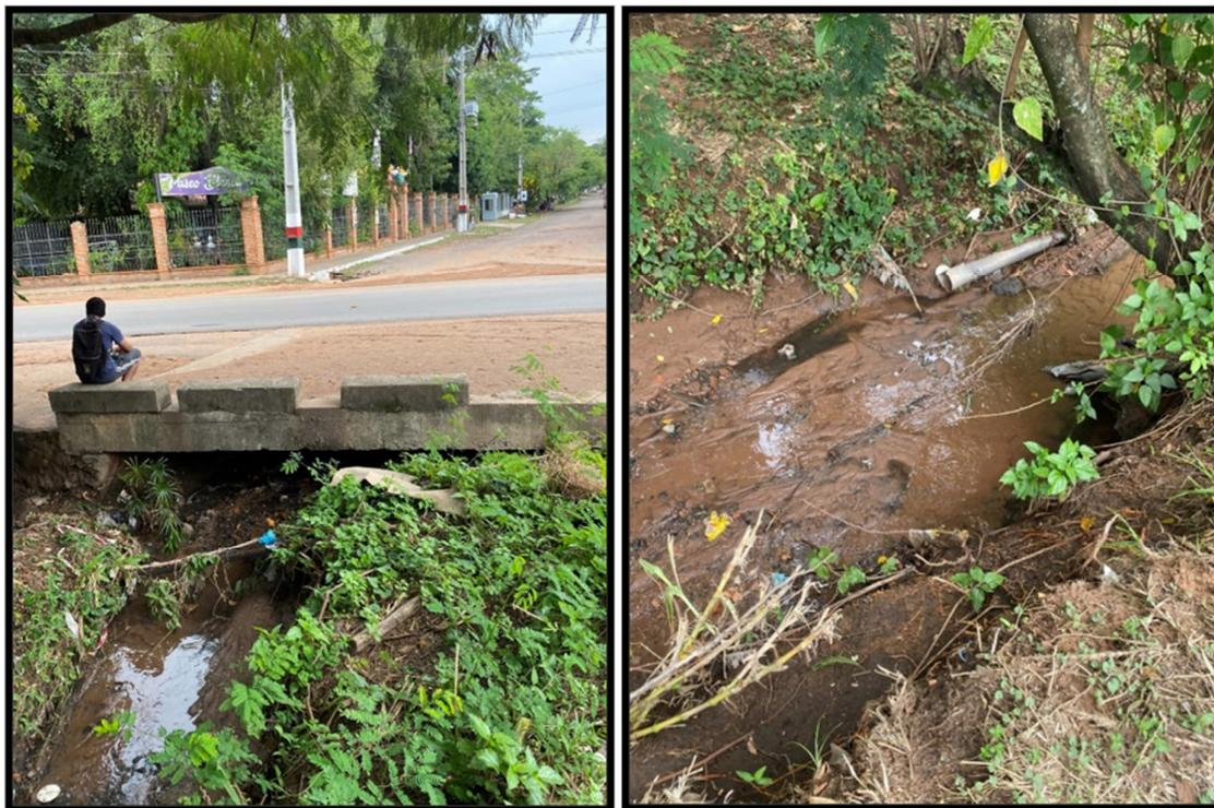
**Figura 1.99. Arroyo Santo Domingo desentubado en su último tramo. Vista de conexiones irregulares y erosión de suelos.**
