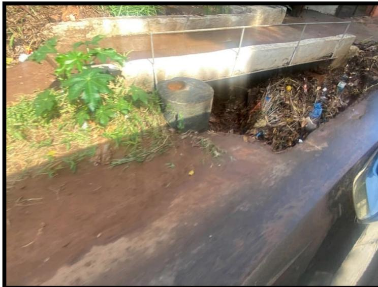
**Figura 1.53. Elemento de Captación Pluvial con restos de ramas y residuos. sobre D076.**
