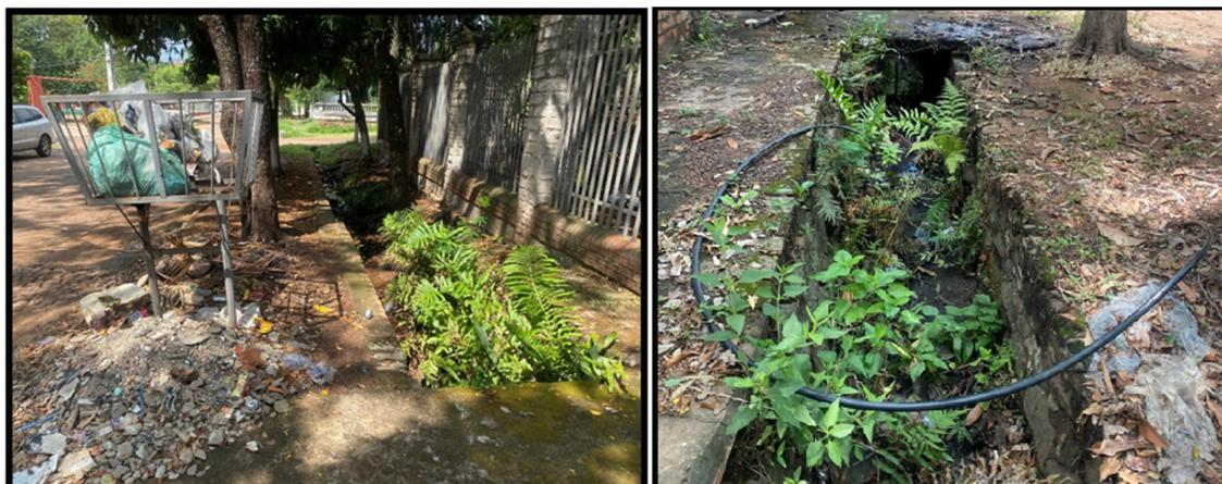
**Figura 1.102. Zanjas de desagüe pluvial en estado de deterioro, acumulación de sedimentos y basura y con conexiones irregulares.**
