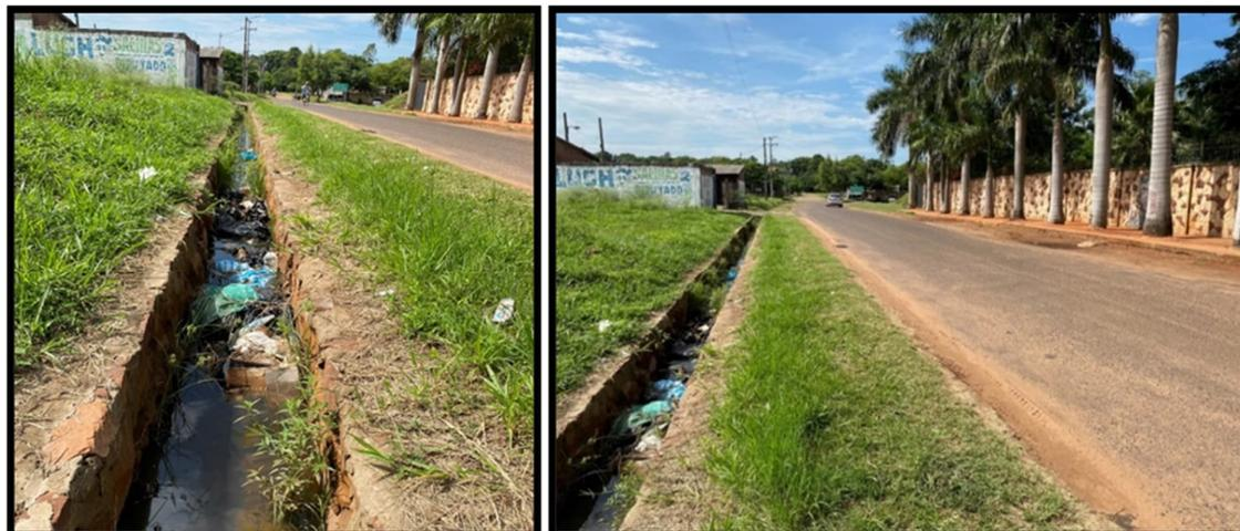
Figura 1.105. Zanjas de desagüe pluvial en deterioro sobre calle Genaro Rodríguez y Virgen del Rosario, con conexiones tendido eléctrico de media tensión
