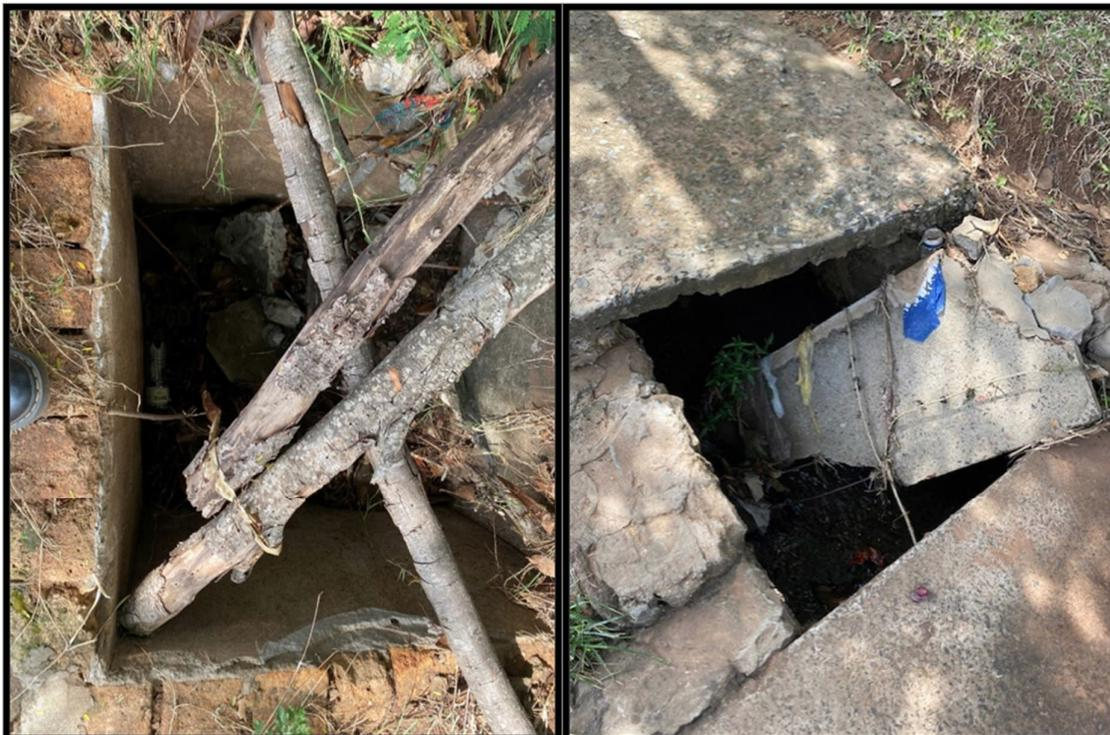
**Figura 1.107. Elementos de captación pluvial en estado de deterioro.**
