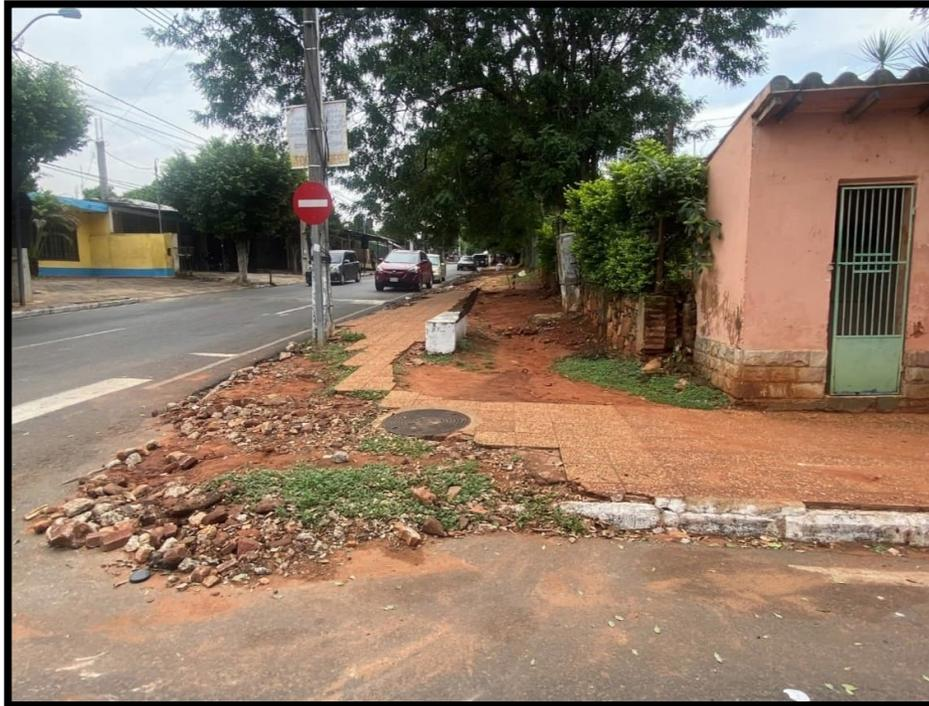
Figura 1.96. Veredas en mal estado sobre calle Boquerón, intersección Ruta Departamental D012.
