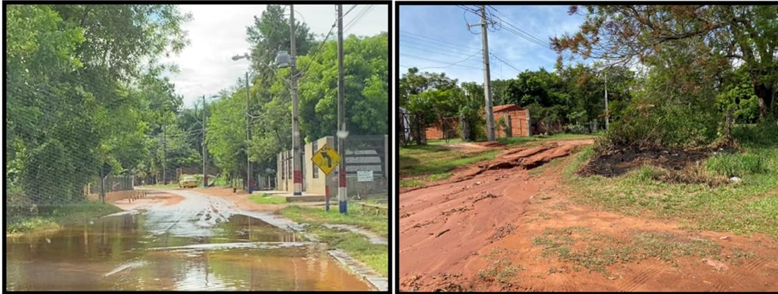
**Figura 1.52. Anegamiento de Agua y Deterioro de calles de tierra.**
