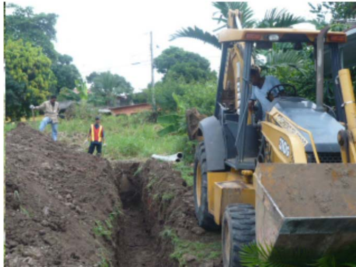
Figura 2.16. Ejemplo de la Actividad de Excavación en Tierra
