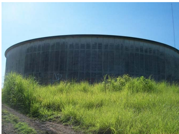
Área de los tanques de almacenamiento en el Cerro San Cristóbal
