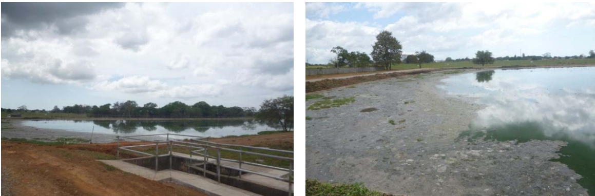
Figura 4.20. Laguna de Oxidación de la Planta de Aguas Residuales en David
