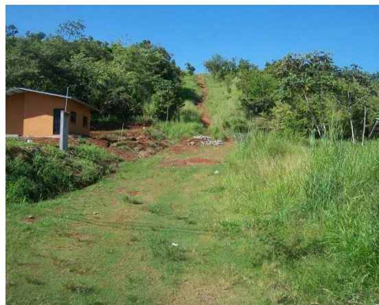
Camino de acceso a los tanques de almacenamiento en el Cerro San Cristóbal
