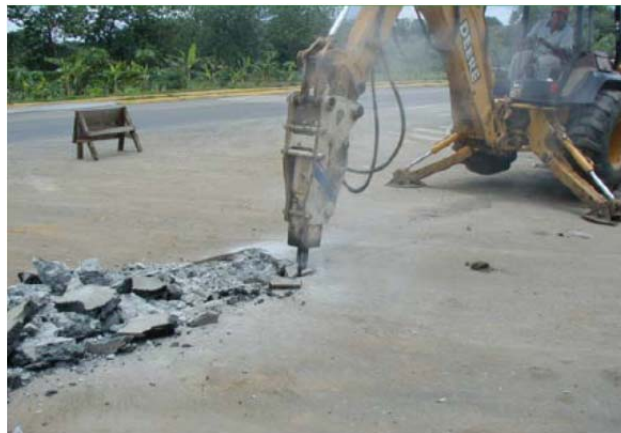
Figura 2.15. Remoción de Pavimento de Hormigón
