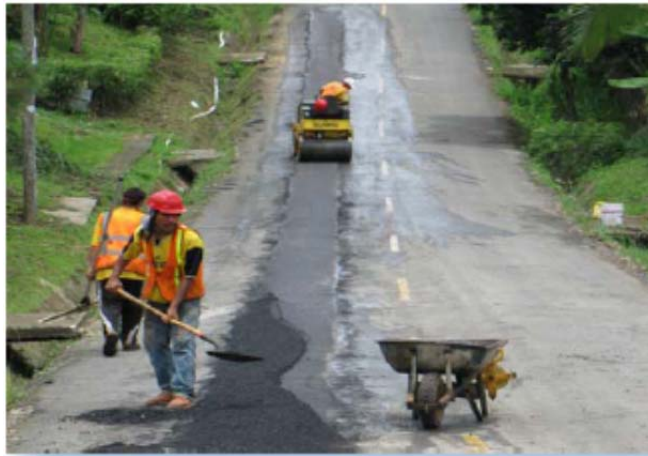
Figura 2.24. Ejemplo de Trabajos de Reposición de Carpeta Asfáltica
