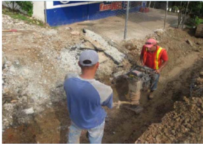
Figura 2.22. Ejemplo de Trabajos de Compactación del Relleno sobre una Tubería
