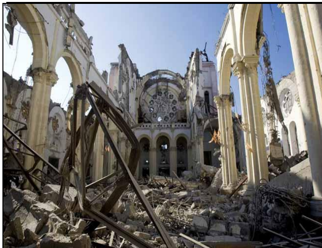
Photo 1 . Cathédrale de Port-au-Prince après le tremblement de terre
