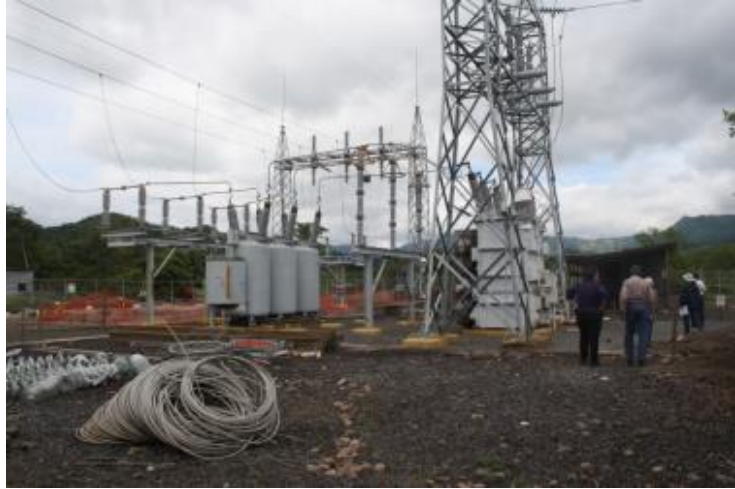
Sitio de la actual Subestación San Ramón.
