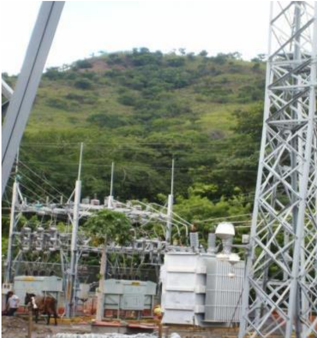
Instalaciones de la actual SE San Ramón
