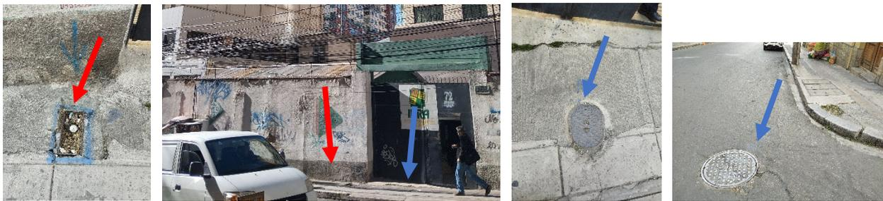
**Figura 29: Acometida de agua potable (rojo) y conexión al alcantarillado (azul)**
