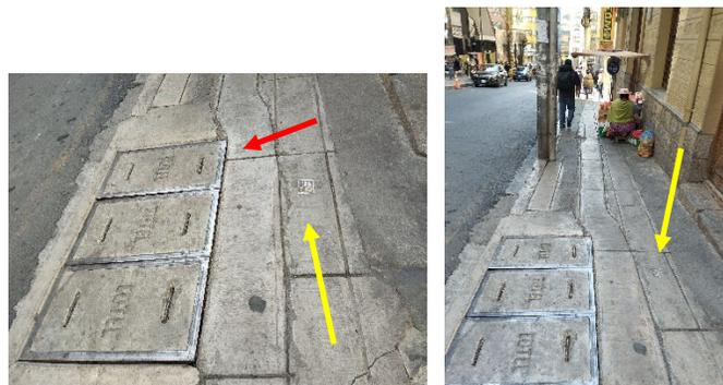
**Figura 31: Cámara de distribución COTEL y paso de línea de gas de YPFB**
