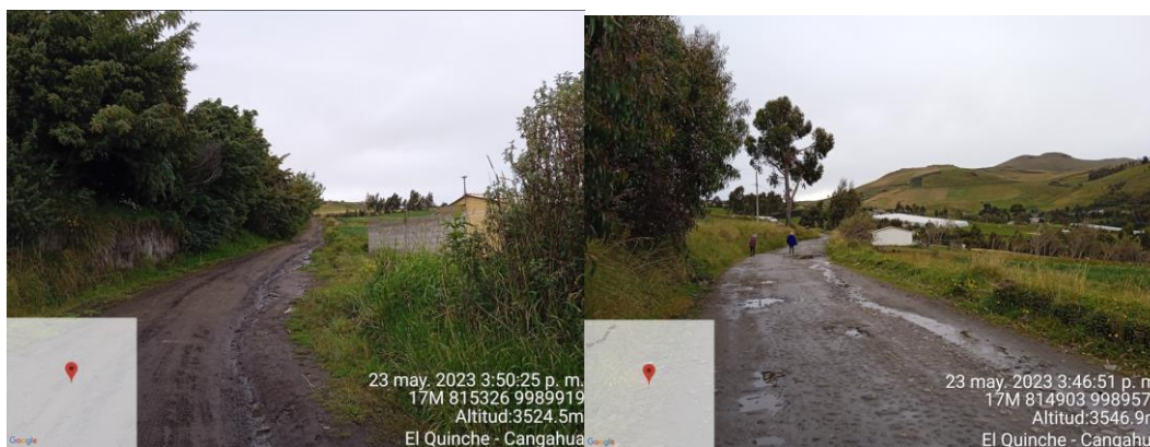
Ilustración63. Viviendas y estructuras ubicadas al borde de la vía
