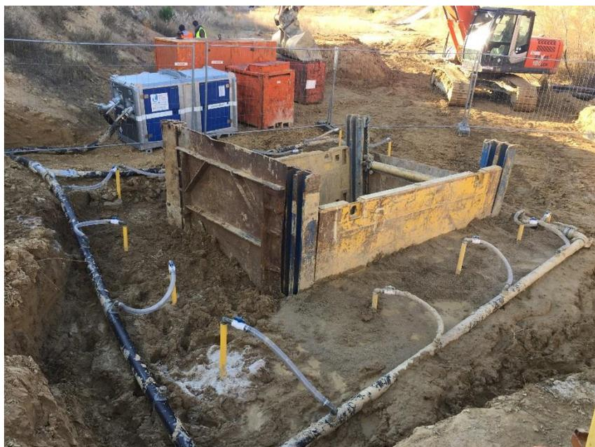
Photographie 20 : Exemple d'un rabattement de nappe (Source : RTE, 2017)
