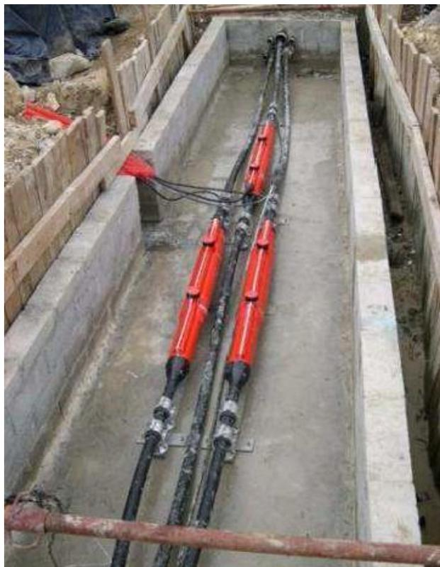
*Photographie 27 : Exemple d'une chambre de jonction (Source : RTE)*
