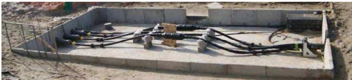
*Photographie 20 : Chambre de jonction d'atterrage en travaux (Source : Nexans, 2016)*
