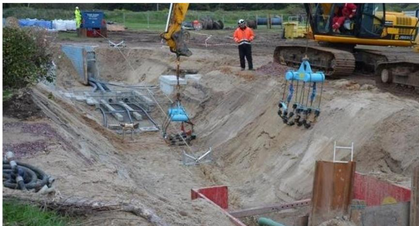
Photographie 22 : Tirage au niveau de la chambre d'atterrage (Source : RTE, 2016)
