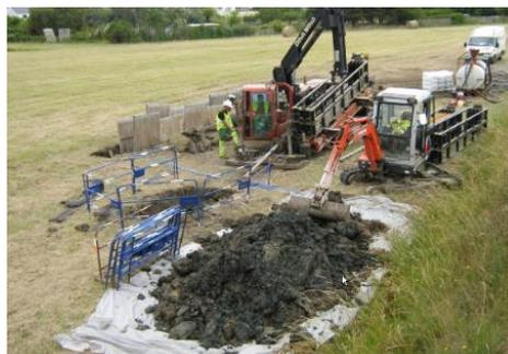
Photographie 28 : Illustrations de la technique du forage dirigé (Source : RTE, 2016)
