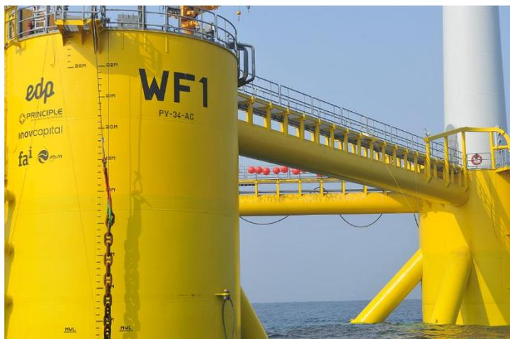
Photographie 8 : Apposition d'une peinture jaune sur l'ensemble du flotteur WF1 (Source : PPI)
