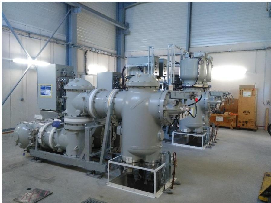
Photographie 30 : Exemple de caisson PSEM 63 kV (Source : RTE, 2018)
