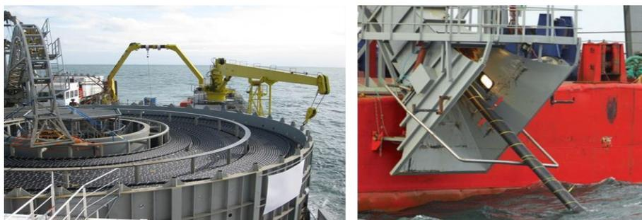
Photographie 13 : Pose des câbles sous-marins (Source : RTE)
