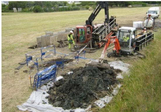
*Photographie 12 : Illustrations de la technique du forage dirigé (Source : RTE, 2016)*
