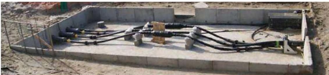
Photographie 10 : Chambre de jonction d'atterrage en travaux (Source : Nexans, 2016)
