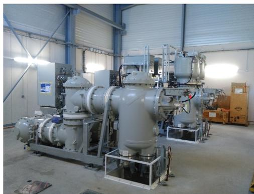
Exemple de caisson PSEM 63 kV
