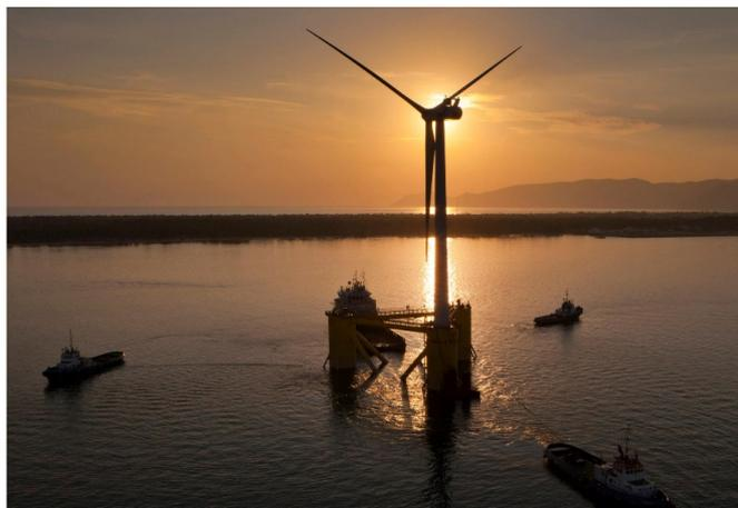
Photographie 5 : Remorquage du prototype WindFloat 1 (source : PPI) Les câbles inter-éoliennes
