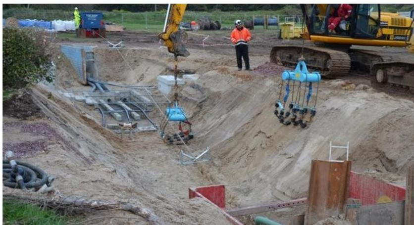
Photographie 11 : Tirage au niveau de la chambre d'atterrage (Source : RTE, 2016)
