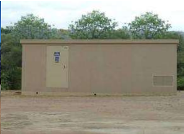
Figure 40 : Poste de livraison
