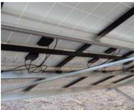
Figure 36 : Exemples de boîtes de jonction et d'interconnexion en série des modules
