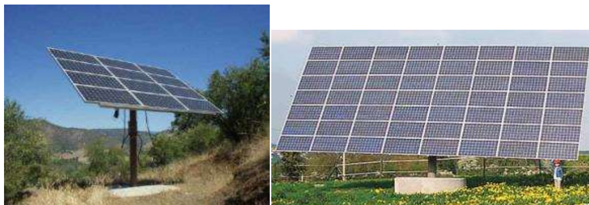
Figure 31 : Tracker 1 axe (à gauche) et 2 axes (à droite)
