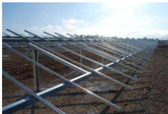
Figure 35 : Exemple de structures et d'ancrage sur pieux
