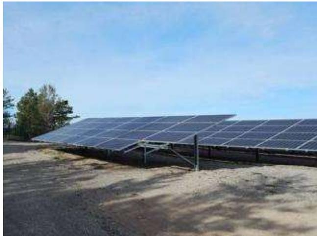
**Figure 34 : Exemple d'une table photovoltaïque**
