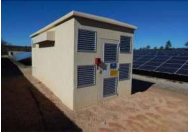
**Figure 41 : Poste de transformation sans parement**
