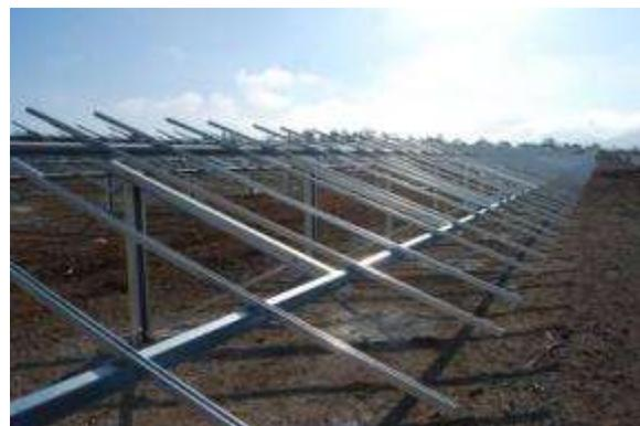
**Figure 37 : Exemple de structures et d'ancrage sur pieux**
