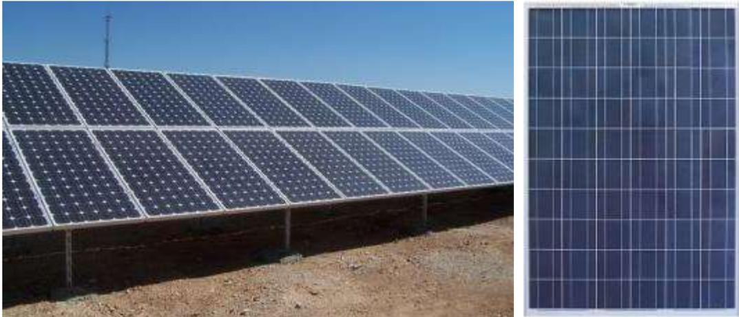
**Figure 27 et Figure 28 : Module des cellules monocristallines et des cellules polycristallines**
