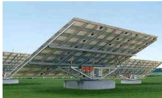
**Figure 35 : Exemple de tracker 2 axes**
