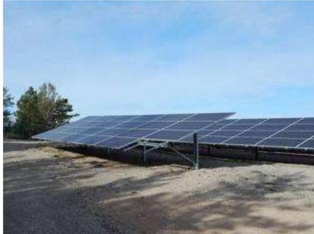
Figure 29 : Exemple d'une table photovoltaïque
