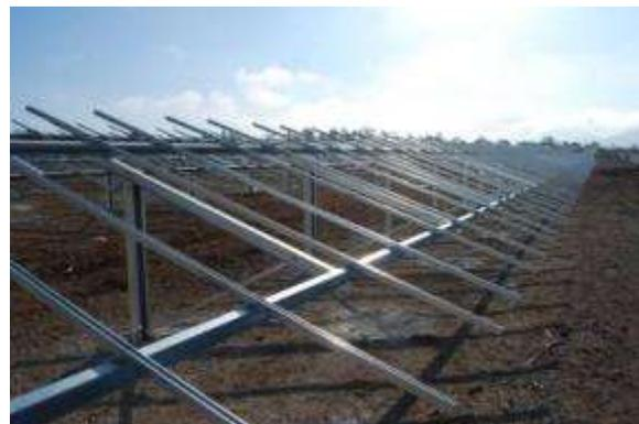
Figure 32 : Exemple de structures et d'ancrage sur pieux
