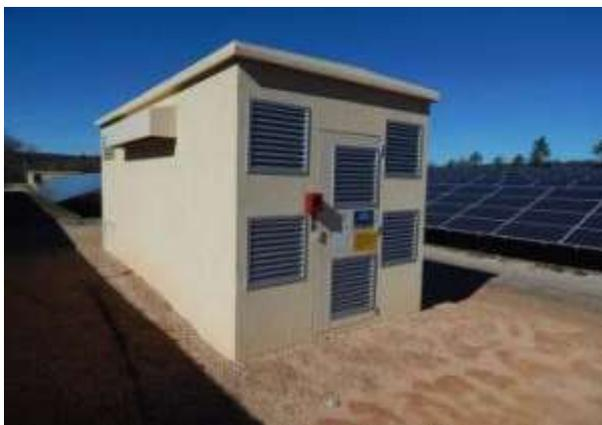
**Figure 36 : Poste de transformation sans parement**
