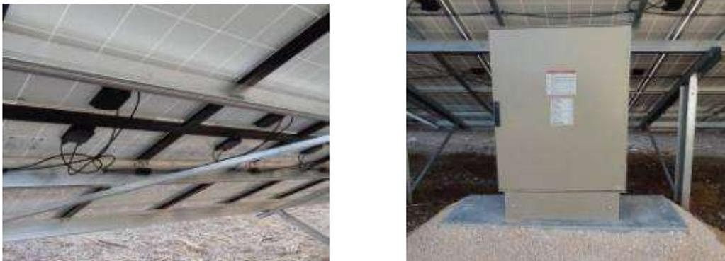
**Figure 33 : Exemples de boîtes de jonction et d'interconnexion en série des modules**
