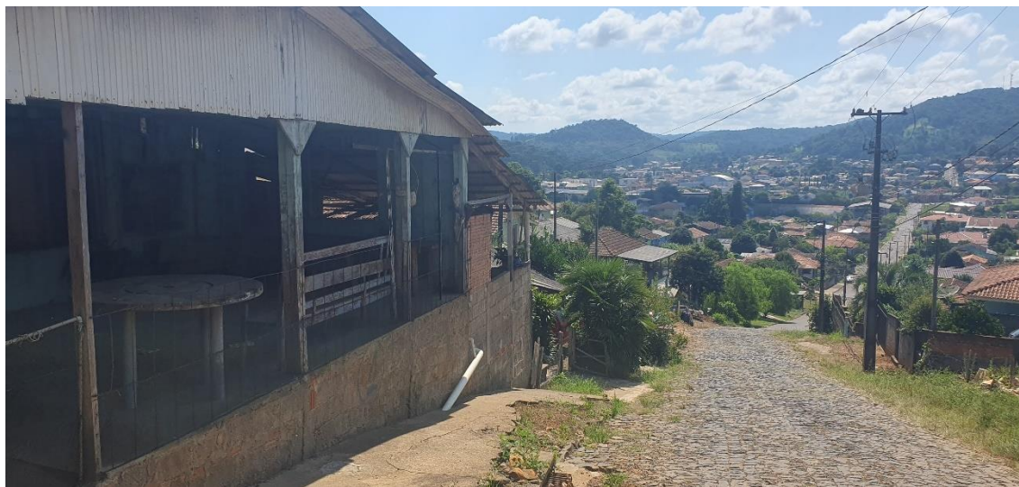
Foto 4 – Padrão de via local de acesso a projeto em área urbana/sede municipal pavimentado em pedra poliédrica e com conservação precária.
