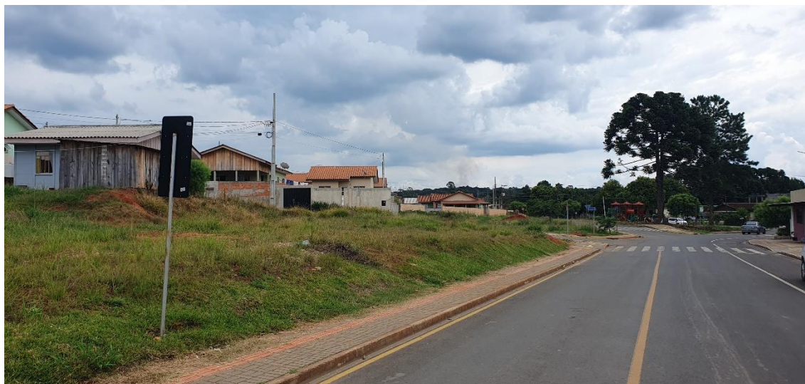
Foto 6 – Padrão de via local de acesso a projeto em área urbana/sede municipal com pavimentação asfáltica e em bom estado de conservação
