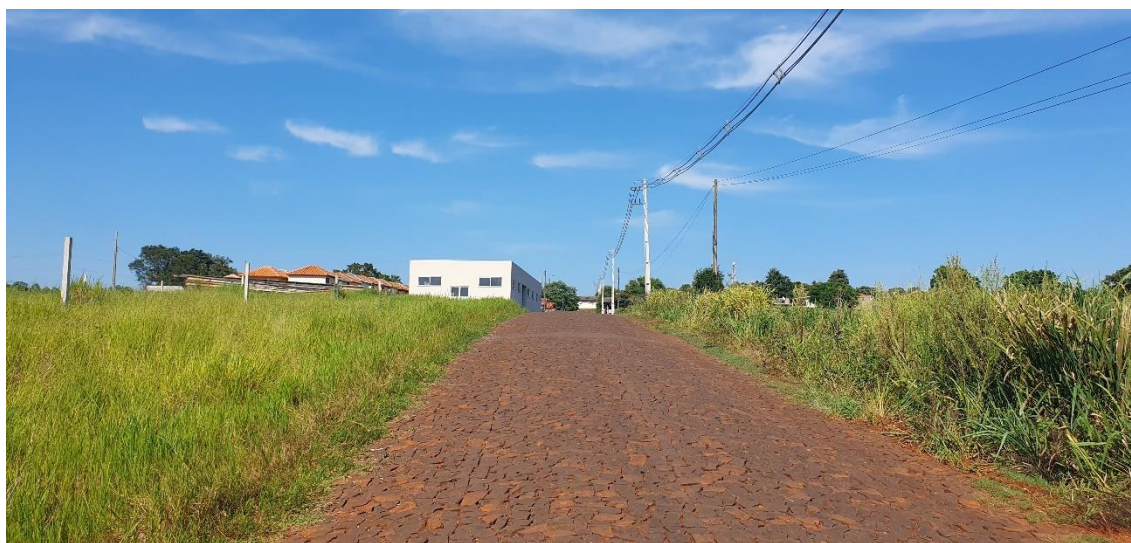
Foto 5 – Padrão de via local de acesso a projeto em área urbana/sede municipal pavimentado em pedra poliédrica e com conservação razoável
