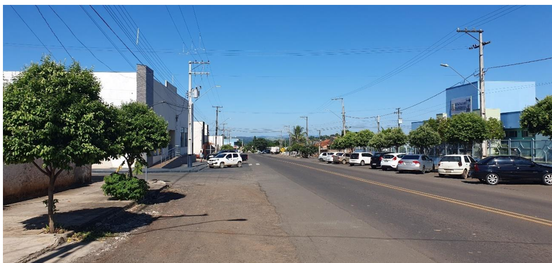
Foto 7 – Área central de município, com travessia de rodovia em bom estado de conservação, onde se encontram os diversos equipamentos sociais.
