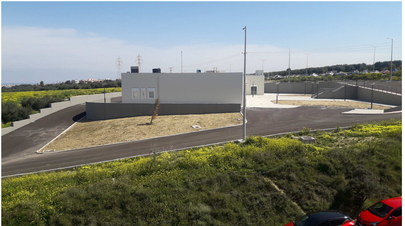
Άποψη του τμήματος ακινήτου για την προσθήκη καθ' ύψος στο κτήριο του Ανατομείου (θέση λήψης 5)
