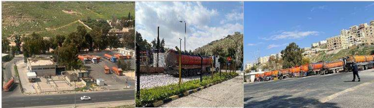
الشكل 5: صور مختارة لمرفق خزانات استلام وتفرغ الصرف الصحي (ECO Consult، 2021)
