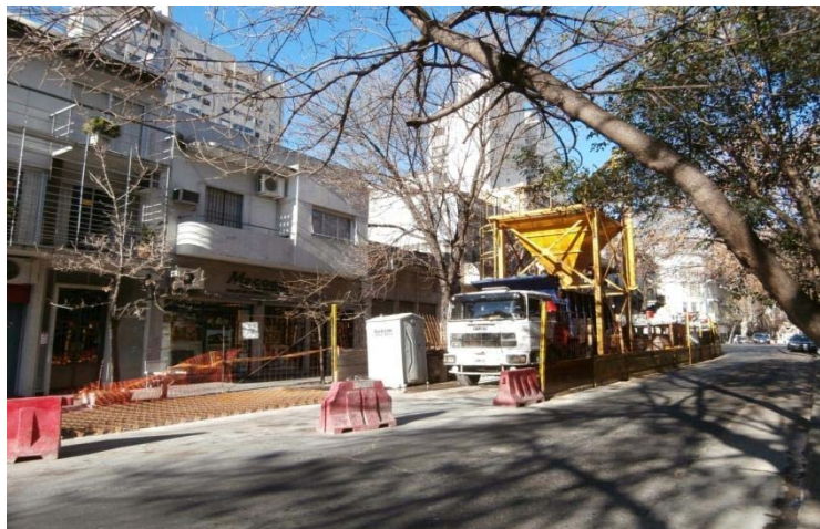
Figura 4. Instalaciones auxiliares en frente de obra
