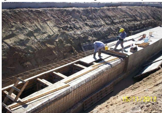
Figura 5. Construcción de desagües de la Autopista Illia
