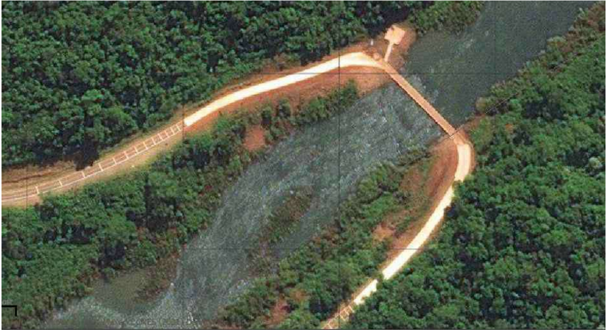
Figura N° 2. Puente (pasarela) actual. Fuente: Proyecto Arroyo Yabotí.
