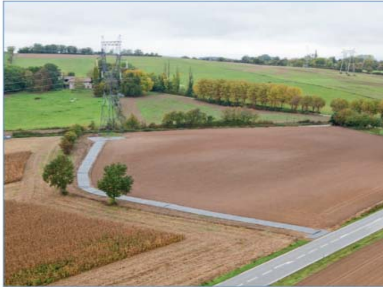
Figure 8: Piste provisoire d'accès à un pylône (Source : (Source : Rte : Réseau de transport d'électricité, Pièces n°3.1, PROJET « 2LOIRES » : Reconstruction à 2 circuits de la ligne électrique existante à 225 000 volts entre Praclaux (43) - Sanssac (43) - Trevas (43) Rivière (42), étude d'impact, Partie I, Juillet 2013))
