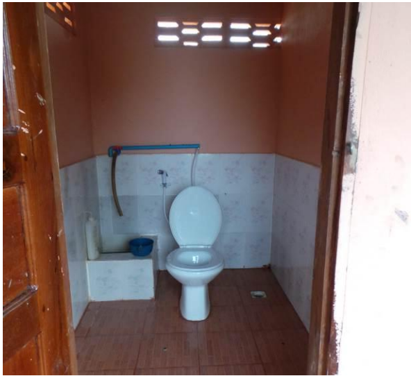
Pour flush toilet with soak away system in Koh Russei
