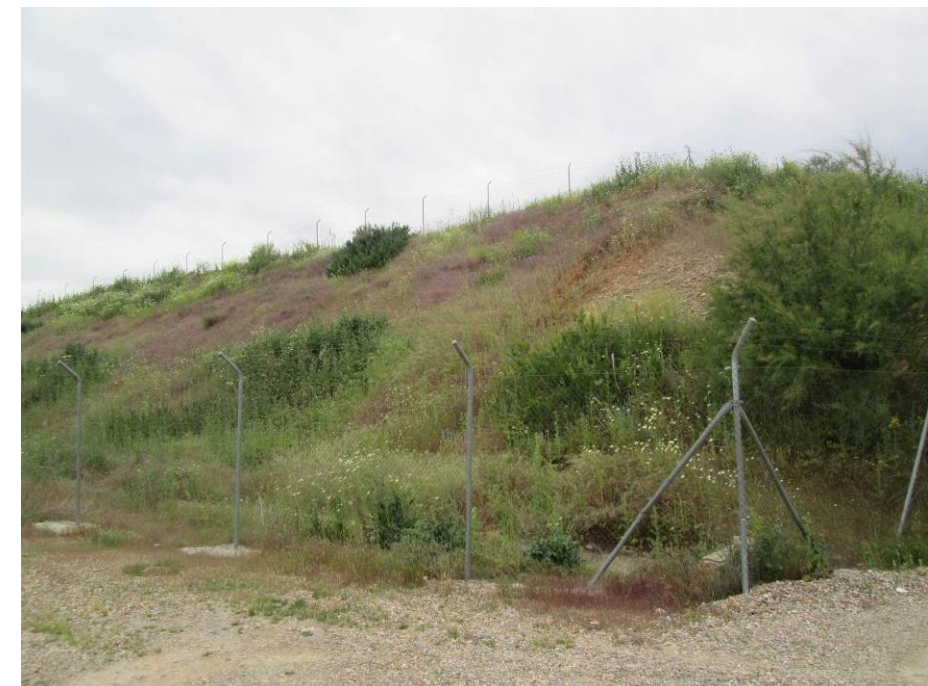
Fig. 39 – 40. Camino de servicio de la LAV y talud de la zona agrícola olivarera que se verá afectado por el desmonte del p.k 5+250 de la alternativa C.
