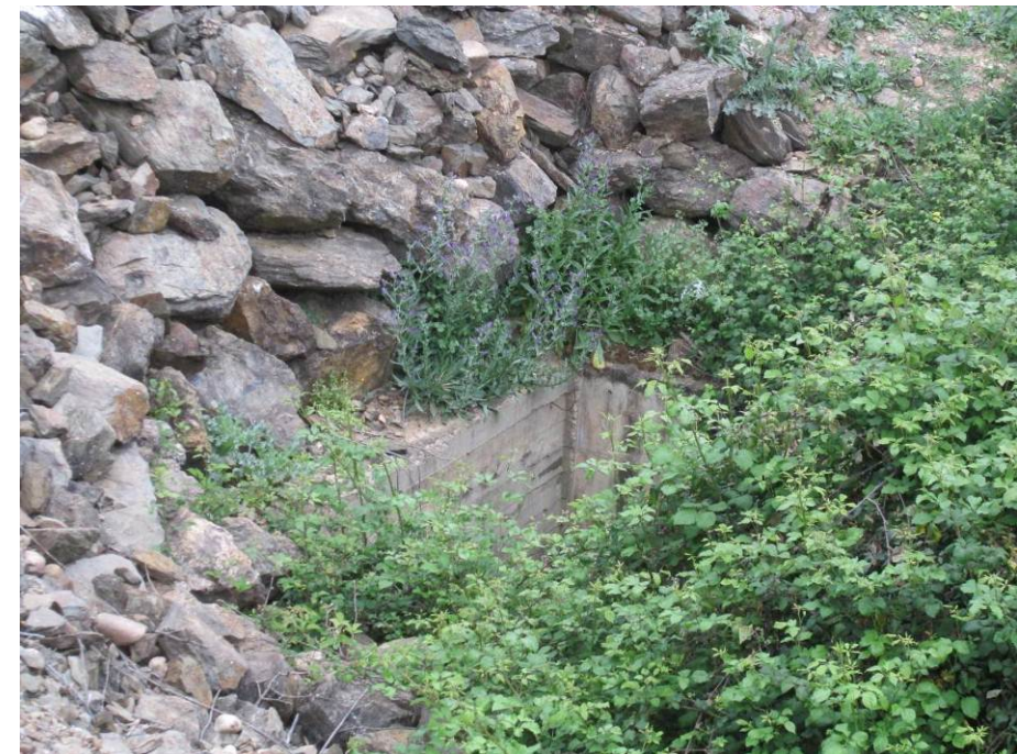
Fig. 25-28. Obras de drenaje transversal existentes en la LAV Madrid – Sevilla. La primera está situada en el pp.kk. 368+700. La segunda está cubierta de residuos vegetales, ubicada en el p.k. 367+800. Se observa el camino de servicio de la LAV desde el paso inferior 1.1 –C. La última obra de drenaje transversal es la ubicada en el p.k. 367+200. Se encuentra cubierta de vegetación hidrófila.
