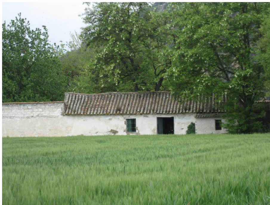
Fig.29- 30. Cortijo de la Barqueta. Construcción agrícola en estado de abandono, identificada como yacimiento según el PGOU de Almodóvar del Río. Se ubica en el p.k. 3+020 de la alternativa C, al borde del talud.
