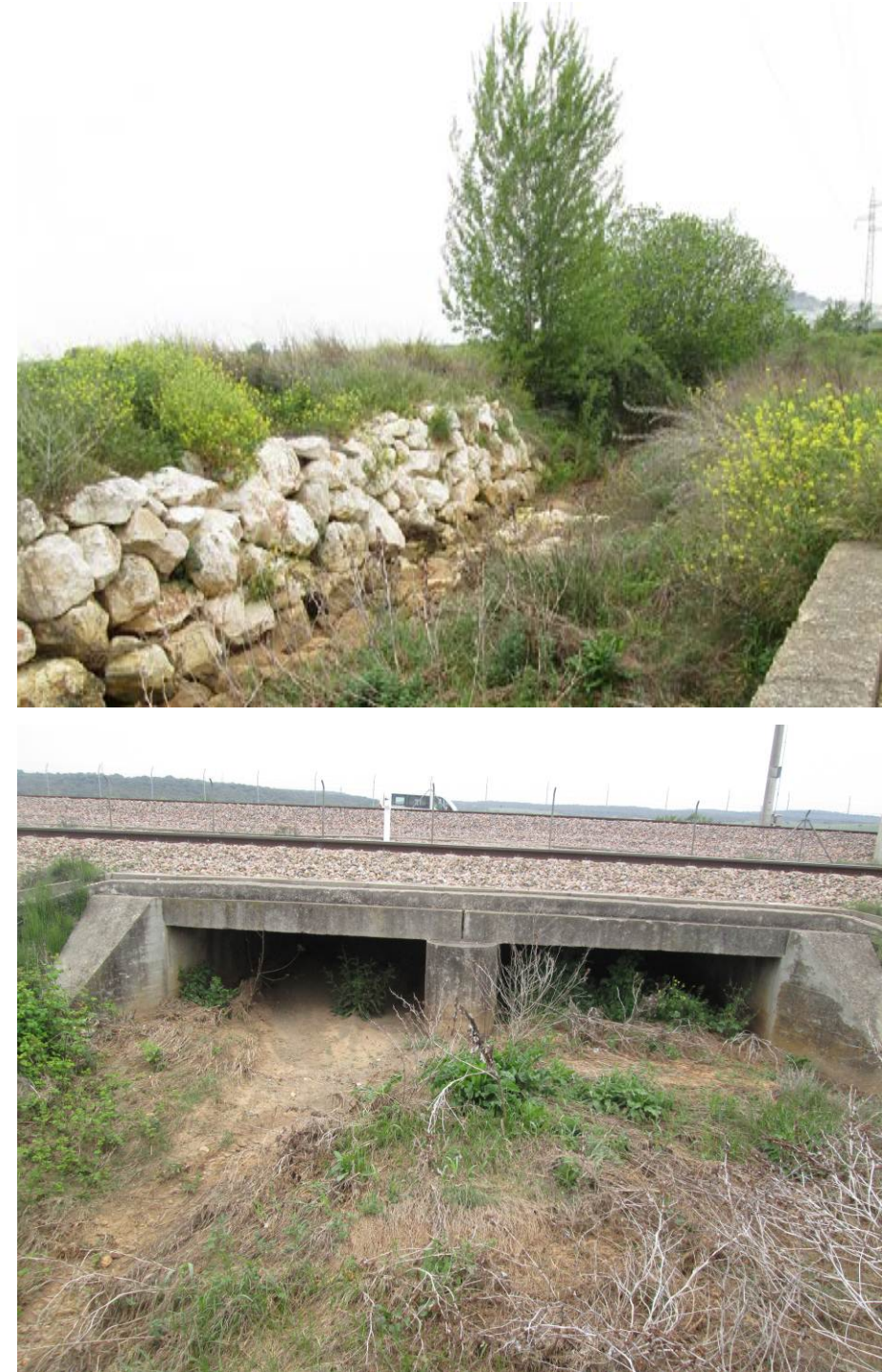
Fig. 9-12. Estado actual del área en la que se proyecta el inicio de la alternativa A entre los pp.kk. 0+000 – 0+500. Se aprecia vegetación hidrófila próxima a la acequia que es continuación del arroyo de los Majadales. En la última imagen se observa un detalle del drenaje transversal asociado a dicho arroyo ubicado en el p.k. 363+000 de la LAV Madrid – Sevilla.
