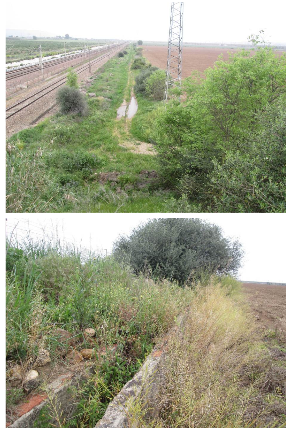
Fig. 5-8. Vista de la zona en la que se proyecta la rectificación de la vía convencional 0+500 – 0+000 tomada desde el paso superior 0.1 –A existente sobre la infraestructura ferroviaria. Se trata de una zona con vegetación hidrófila espontánea por la presencia de una acequia de riego en desuso que se muestra en detalle en la última imagen.
