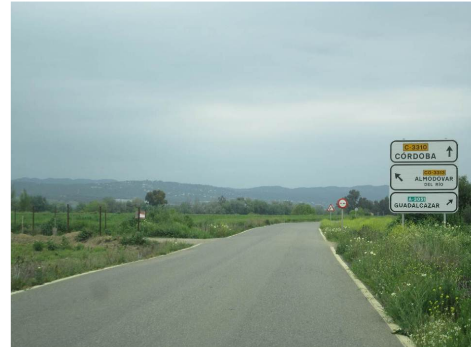
Fig. 35. Cordel de Córdoba a Palma en el punto de intersección con la futura alternativa C en el p.k. 4+500. Actualmente es empleada como infraestructura viaria (CP-234)
