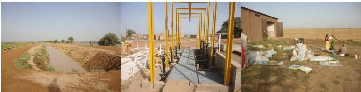
Photos canal d'amener, ouvrage, rizerie
