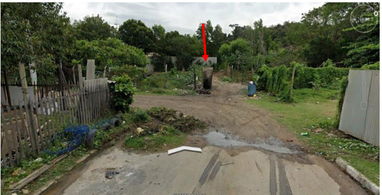
Figura 26: Imagem do final da rua Dório Silva. Aos fundos encontra-se o muro da ETE da Araçás (seta vermelha).
