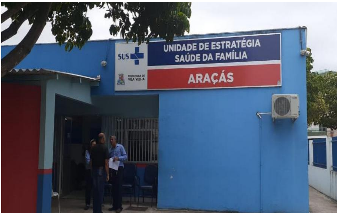
Figura 15: Vista da fachada da Unidade de Saúde de Araçás.
