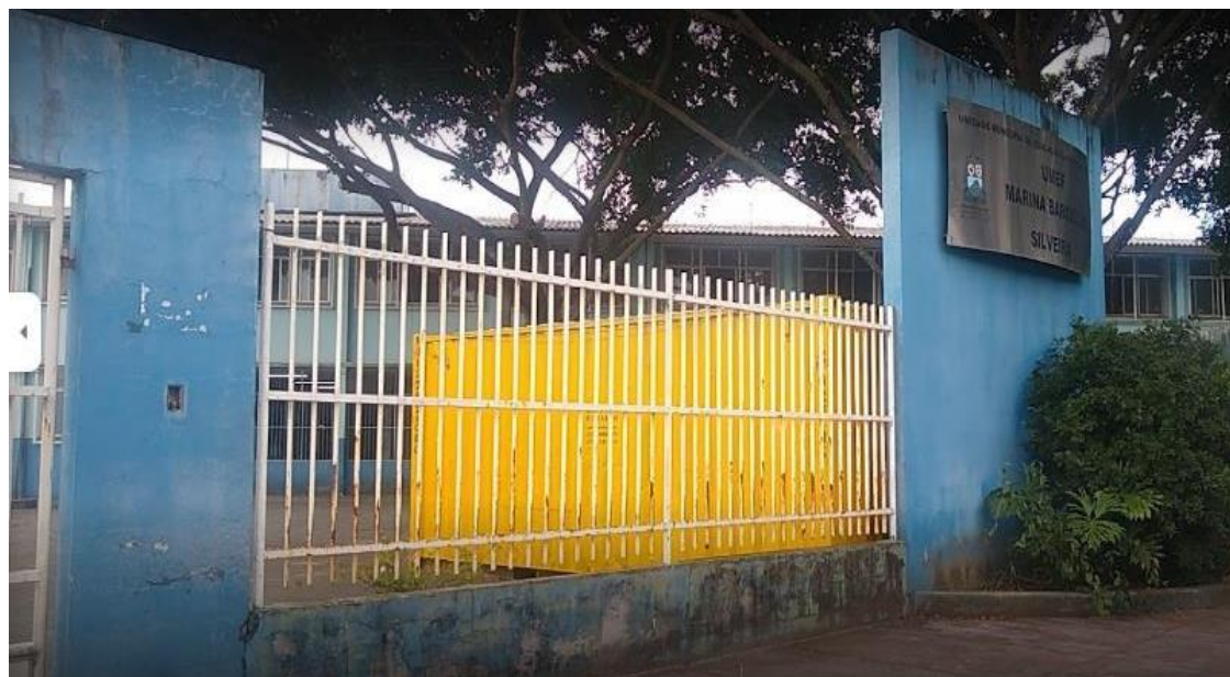
Figura 13: Vista da fachada da EMEF Marina Barcellos Silveira.
